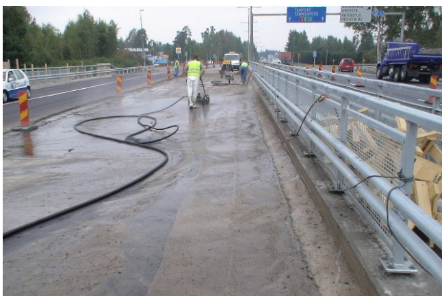
Kuva 2. Kannen yläpinnan tasovesipesua.
