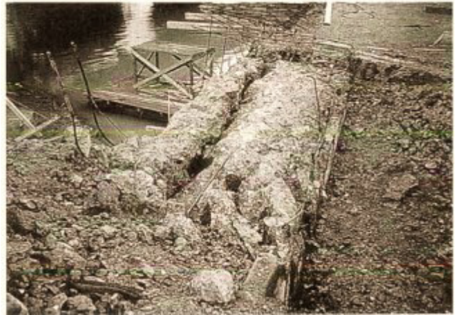
Kuva 25. Paisunta-aineella murrettu siipimuuri.
