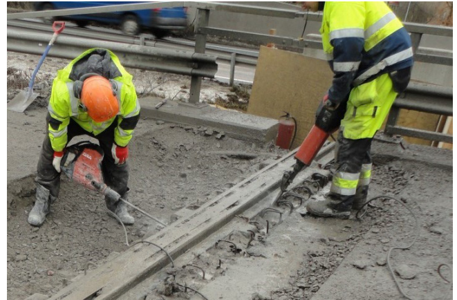
Kuva 11. Sähkökäyttöinen piikkausvasara.
