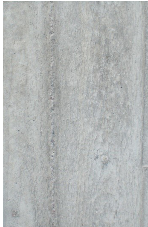
Kuva 41. Betonipinta ennen suihkupuhdistusta.
