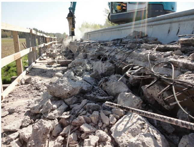
Kuva 10. Piikkausvasara työ­koneeseen kiinnitettyä.
