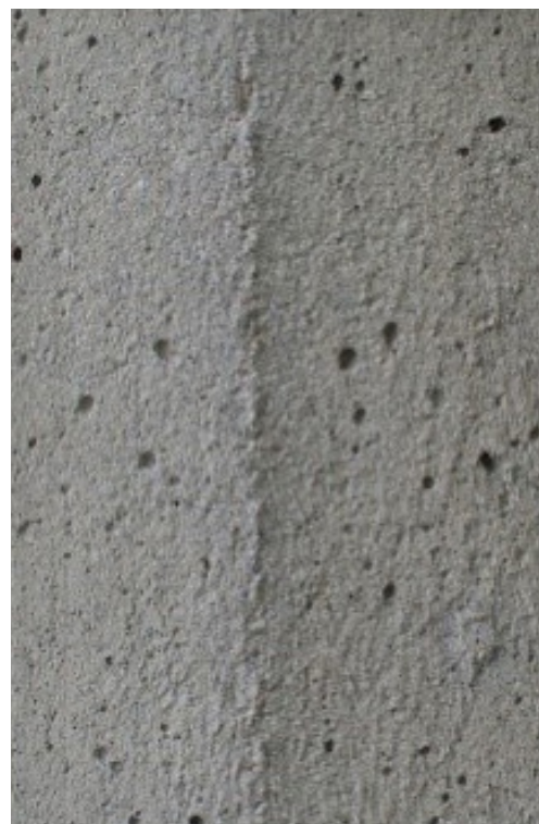
Kuva 42. Erittäin kevyt suihkupuhdistus
