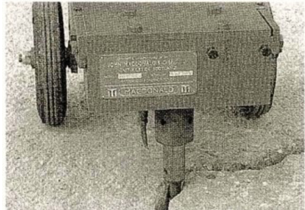
Kuva 27. Halkeaman avartamista kovametalliterällä.
