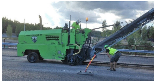
Kuva 28. Voimakas asfalttijyrsin
