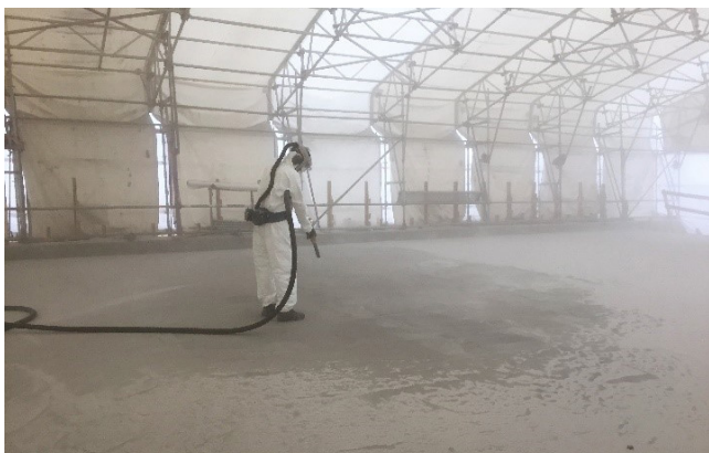
Kuva 31. Betonipinnan suihkupuhdistusta hiekkapuhalluksella.
