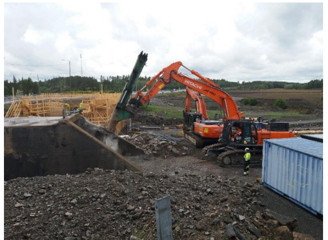
Kuva 26. Pudotusjätkäleellä purkamista.
