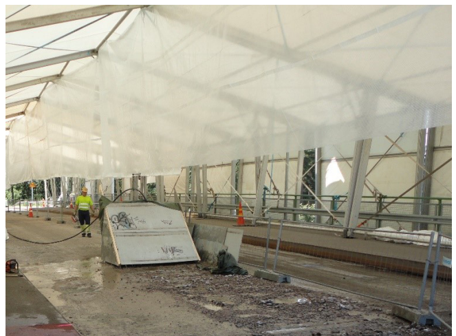
Kuva 14. Kansilaatan yläpinnan vesipiikkausta.
