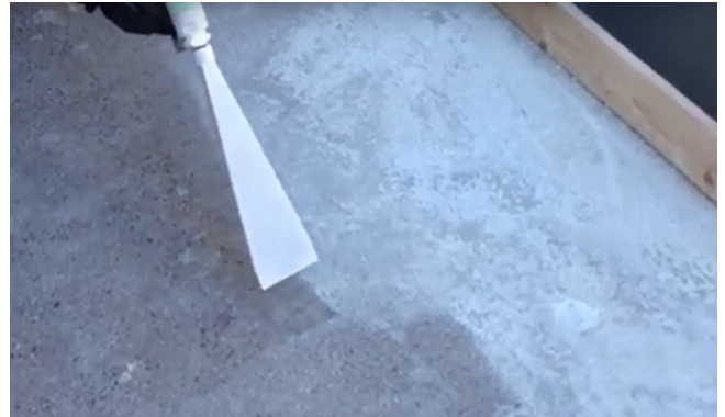
Kuva 34. Kuivajääpuhallusta.
