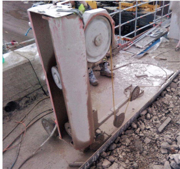
Kuva 22. Läpivientiaukon teko vaijerisahalla.
