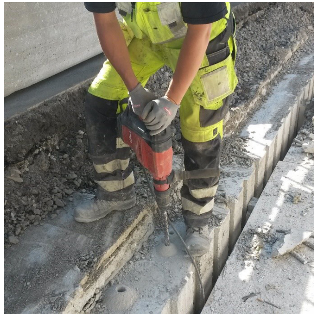
Kuva 18. Raudoitustankojen ankkurointireikien porausta iskuporakoneella.
