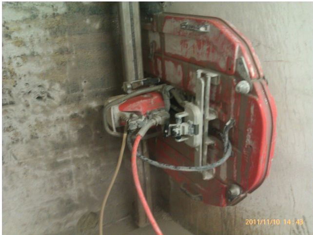
Kuva 20. Betonirakenteen purkua seinäsahalla.
