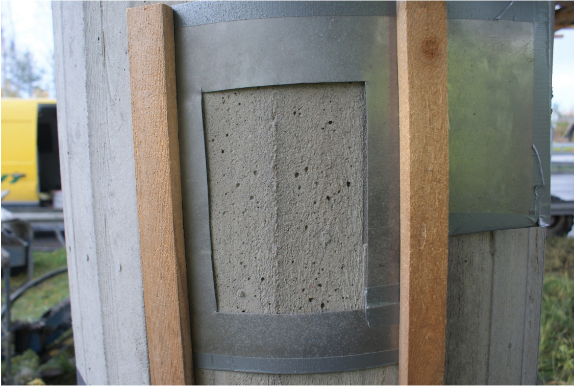
Kuva 3. Erittäin kevyt suihkupuhdistus.
