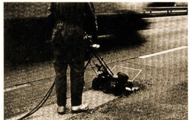
Kuva 35. Betonipinnan liekkiharjausta.
