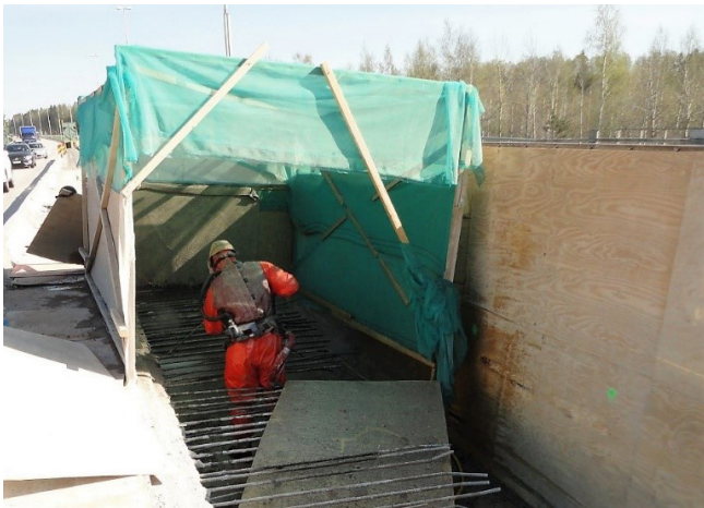
Kuva 16. Piikatun pinnan viimeistelyä vesipiikalla.
