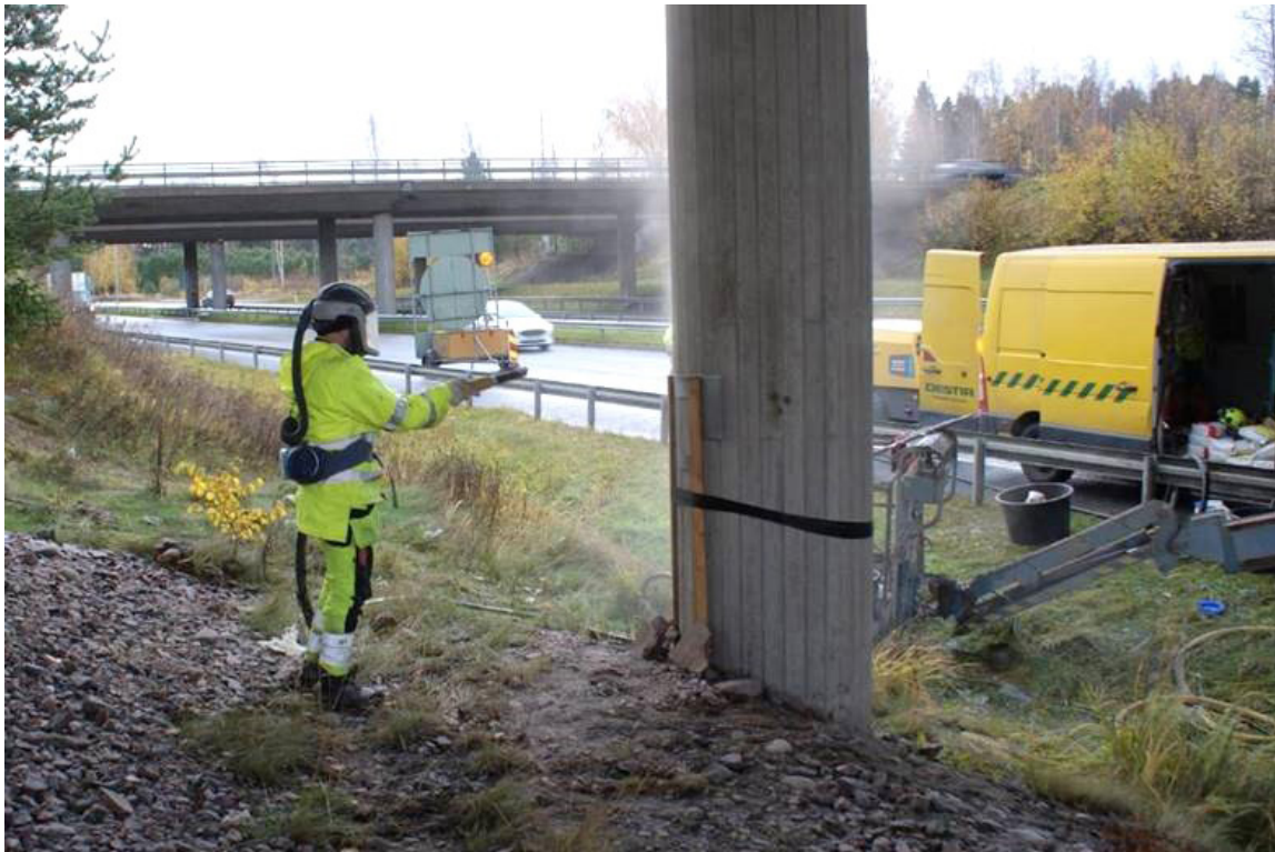
Kuva 1. Pilarin koealueen suihkupuhdistusta.
