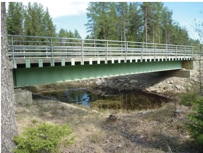
Kuva 9. Yksiaukkoinen teräksinen ajoneuvo-liikenteen palkkisilta
