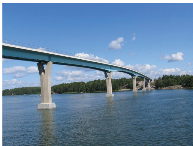
Kuva 14. Jatkuva viisteellinen liittopalkkisilta
