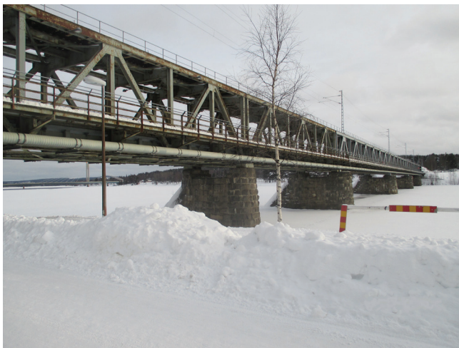
Kuva 17. Ristikkosilta, jossa ristikot sijaitsevat ajoradan alapuolella.
