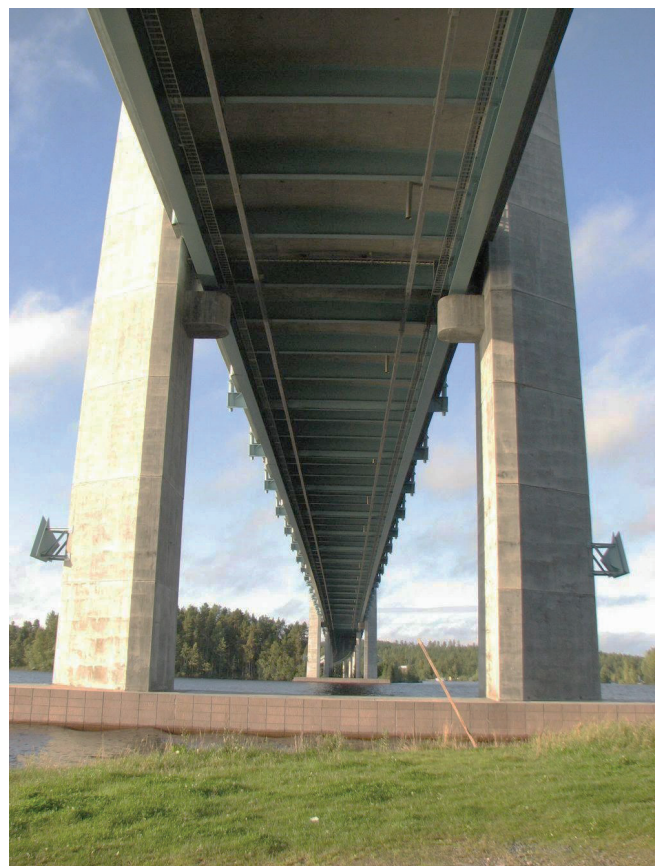
Kuva 28. Vinoköysisillan tyypillinen päällysrakenteen palkisto.
