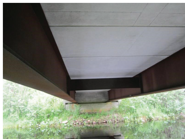
Kuva 15. Tyyppi-piirustussarjan mukaisen yksiaukkoisen liittopalkkisillan päällysrakenne.
