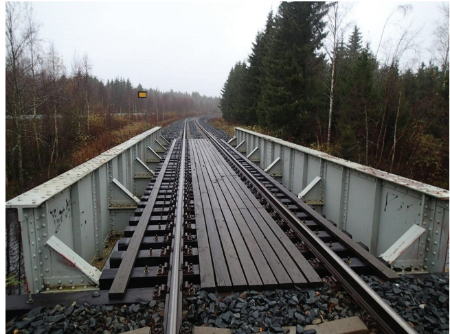
Kuva 10. Rautatiesilloissa käytetty teräspalkiston tyyppi, jossa raiteita kantavat sekundäärirakenteet sijaitsevat pääpalkkien alaosan tasolla.
