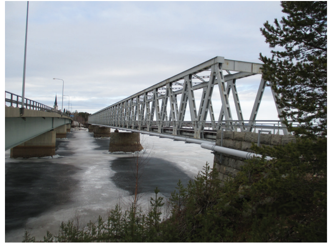
Kuva 18. Ristikkosilta, jossa ristikot sijaitsevat ajoradan yläpuolella sillan molemmilla reunoilla.
