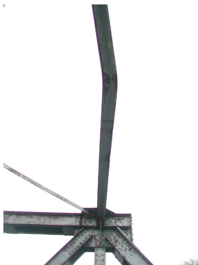
Kuva 64. Törmäysvaurio ristikkosillan portaalin yläpoikkisiteessä.
