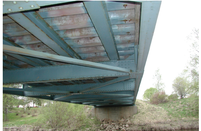
Kuva 41. Vaakaristikko, jossa sauvojen liitokset on toteutettu niittiliitoksen ja profiileina on L- ja T-teräkset.
