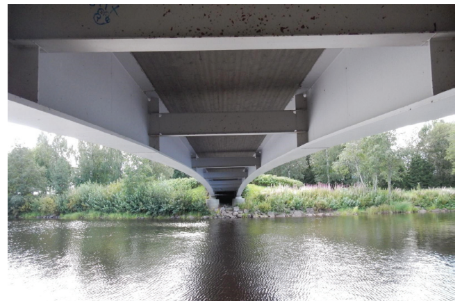
Kuva 36. Hitsatun levypalkkisillan tyypillinen poikkipalkki. Poikkipalkin liitos pääpalkkiin on tehty hitsaamalla
