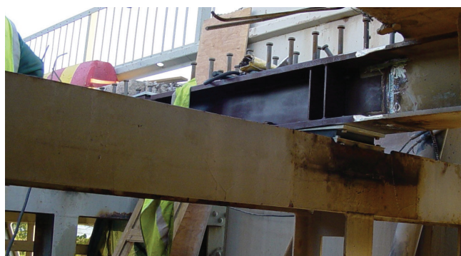
Kuva 3. Riippusillan pituussuuntaisen sekundäärikannattimen korjaustyö uusimalla rakenneosa osittain.
