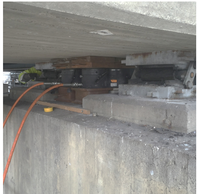
Kuva 81. Yksimäntäiset hydraulitunkit laakereiden korjaukseen liittyvässä nostotyössä.
