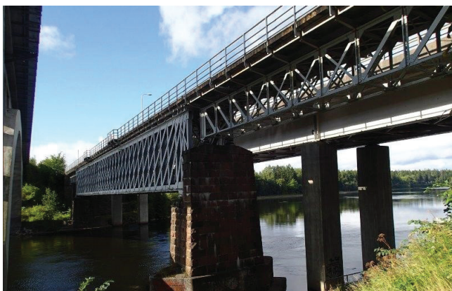
Kuva 5. Kymijoen (Korian) rautatiesilta Elimäellä on rakennettu 1870.
