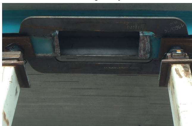
Kuva 2. Pienen kotelopalkkikannattimen alalaipan törmäysvaurion korjauksen työnaikainen tuenta.
