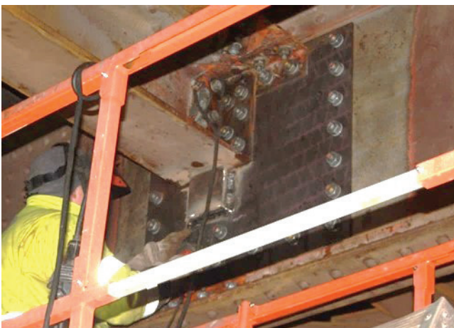
Kuva 80. Korjattavan liittokohdan mallinnuskuvaa ja valokuva samasta liittoksesta.
