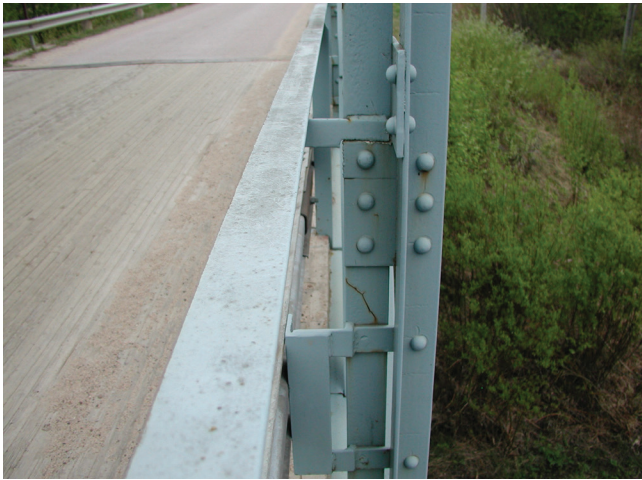
Kuva 53. Ristikkosillan vertikaalisauva, joka on tehty kahdesta kulmittain sijaitsevasta L-profiilista. L-profiilit on yhdistetty toisiinsa teräslevyillä.
