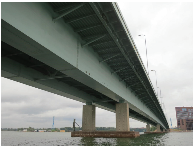
Kuva 16. Kotelopalkkisilta, jossa on ortotrooppinen teräskansi.
