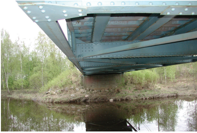
Kuva 38. Niittaamalla kootun ristikkosillan tyypillinen poikkipalkki.
