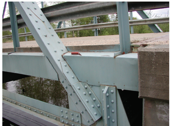
Kuva 49. Niitatusen ristikkosillan alapaarre, joka on tehty teräslevystä ja kahdesta L-profiilista.
