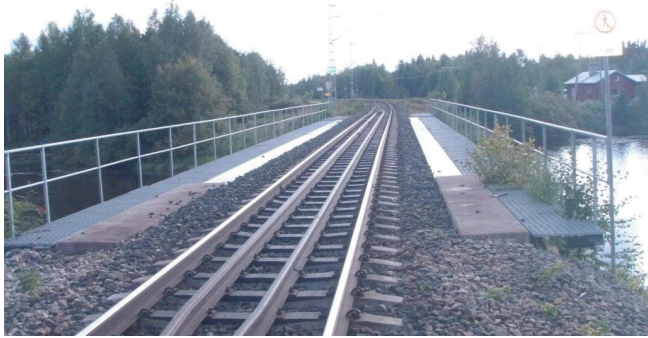
Kuva 55. Teräsrakenteinen kaukalopalkkisilta, jossa ratapölkkyt ja kiskot tukeutuvat tukikerroksen välityksellä teräsrakenteeseen.
