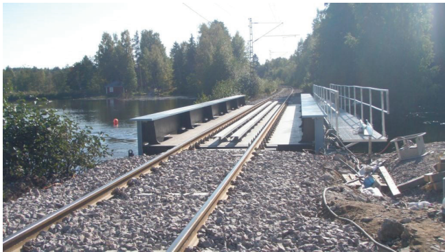
Kuva 56. Teräsrakenteinen kaukalopalkkisilta, jossa raiteet tukeutuvat suoraan teräsrakenteeseen.
