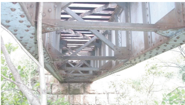
Kuva 39. Niittaamalla kootun palkkisillan poikkiristikko.
