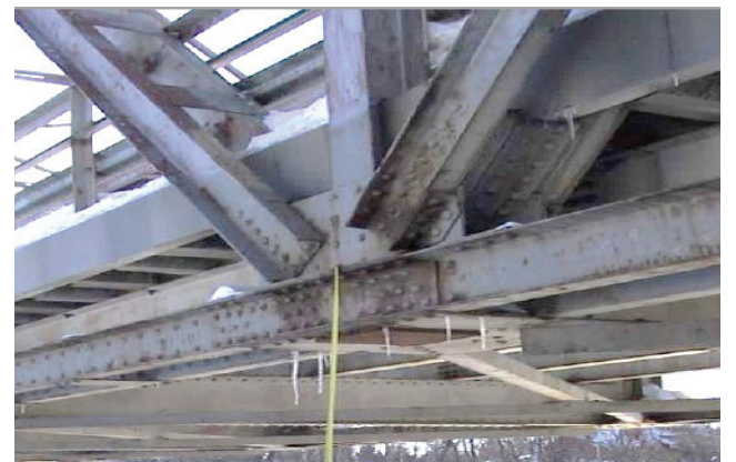
Kuva 52. Ristikkosillan vertikaali- ja diagonaalisauvojen liittyminen alapaarteeseen. Vertikaalisauva on tehty valssatusta I-profiilista ja diagonaalisauvat on tehty kahdesta U-profiilista
