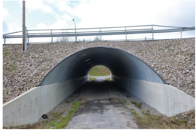
Kuva 29. Teräksinen holvisilta kevyenliikenteen alikulkukäytävänä.
