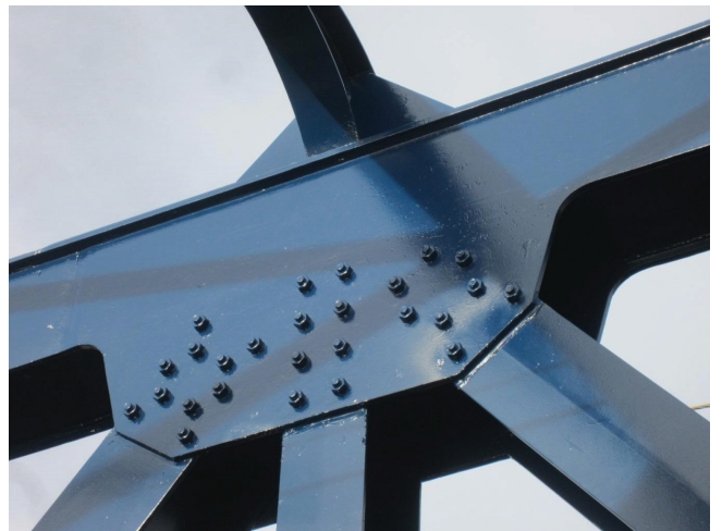
Kuva 20. Ristikkosillan kitkaliitos esijännitetyn ruuvein
