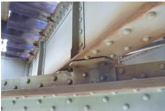
Kuva 33. Niittaamalla kootun sillan tyypillinen pituussuuntainen sekundääripalkki.
