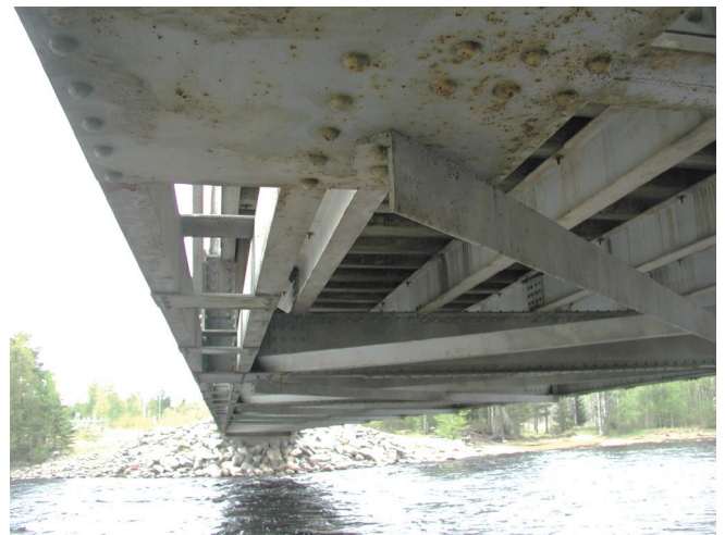
Kuva 19. Ristikkosillan niittiliitos.
