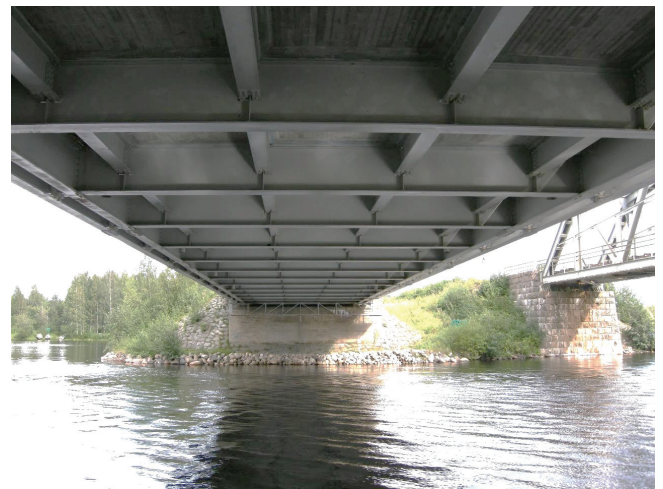
Kuva 23. Langer-palkkisillan tyypillinen päällysrakenteen palkisto
