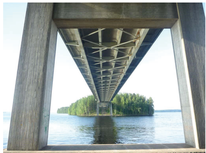
Kuva 25. Riippusillan tyypillinen päällysrakenteen palkisto.
