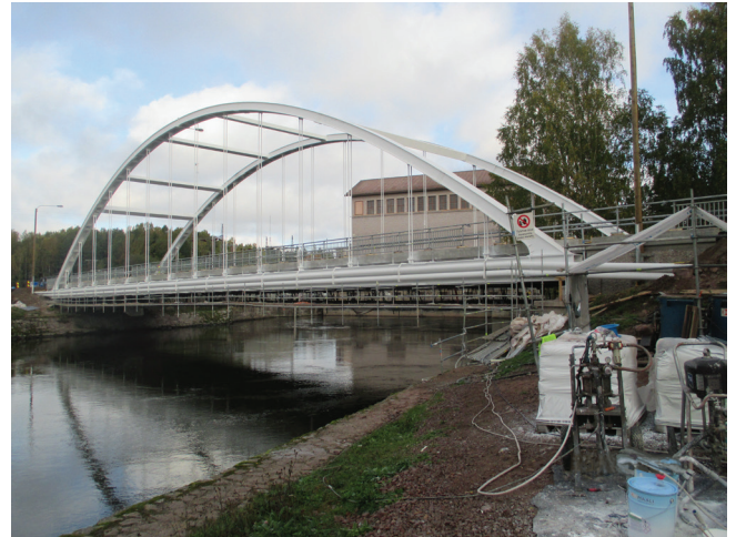
Kuva 22. Langer-palkkisilta. Kannen alapuolelle on tehty telineet pintakäsittelyä varten
