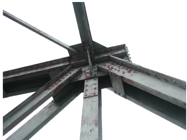
Kuva 48. Niitatusen ristikkosillan yläpaarre, joka muodostuu kahdesta erillisestä profiilista. Vertikaali- ja diagonaalisauvat on asennettu profiilien väliin.
