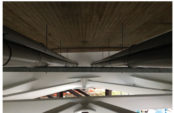
Kuva 42. Hitsaamalla kootun sillan vaakaristikko, joka on tehty rakenneputkista
