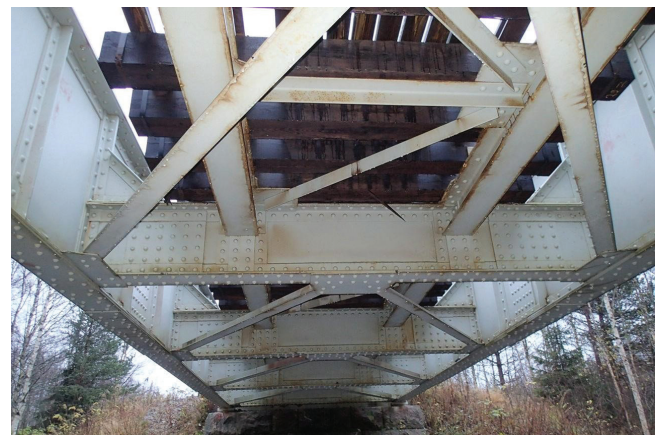
Kuva 37. Niittaamalla kootun teräspalkkisillan tyypillinen poikkipalkki.
