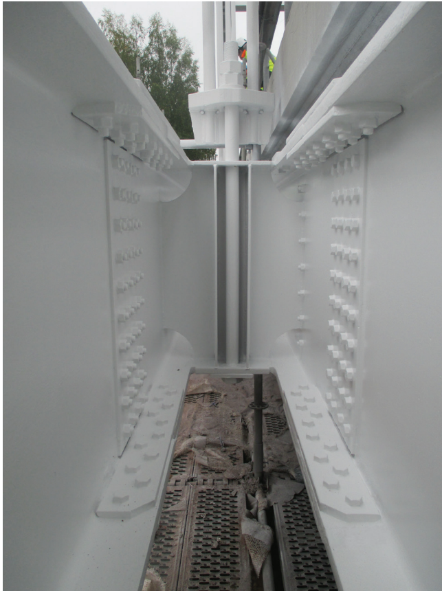
Kuva 50. Langer-palkkisillan kaksiumainen alapaarre ja vetotangon liitos uumien välissä.
