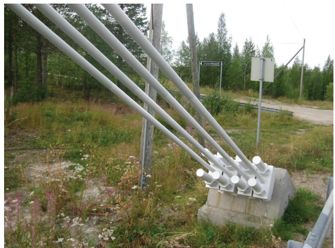
Kuva 26. Riippuköyden ankkurointi.
