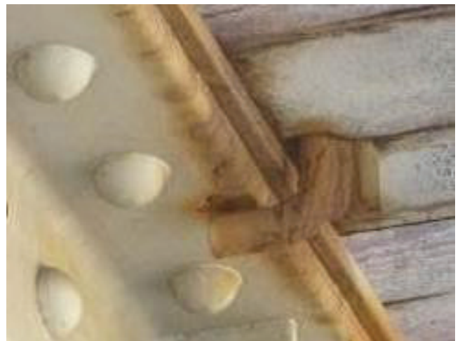
Kuva 57. Puusiltapölkkyjen kiinnitys teräsrakenteeseen koukkupultilla.
