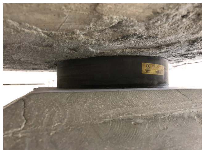
Kuva 28. Kumilevyllaakereiden uusimisen yhteydessä kannen alapinta on jäänyt oikaisematta. Vasemmanpuoleinen laakeri kantaa enemmän kuormaa kuin oikeanpuoleinen. (T-1663 Rekoisten silta)
