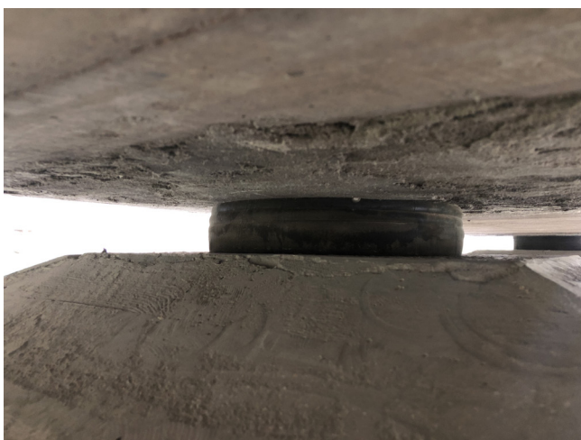
Kuva 28. Kumilevyllaakereiden uusimisen yhteydessä kannen alapinta on jäänyt oikaisematta. Vasemmanpuoleinen laakeri kantaa enemmän kuormaa kuin oikeanpuoleinen. (T-1663 Rekoisten silta)
