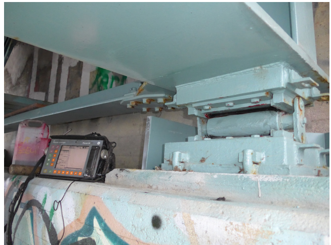
Kuva 27. Kreutz-rullalaakerin ultraäänimittaus (U-1162 Hiidenveden silta).
