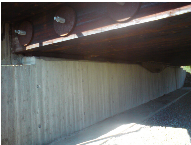
Kuva 1. Puusillan laakerina toimii pelkkä lankku.
