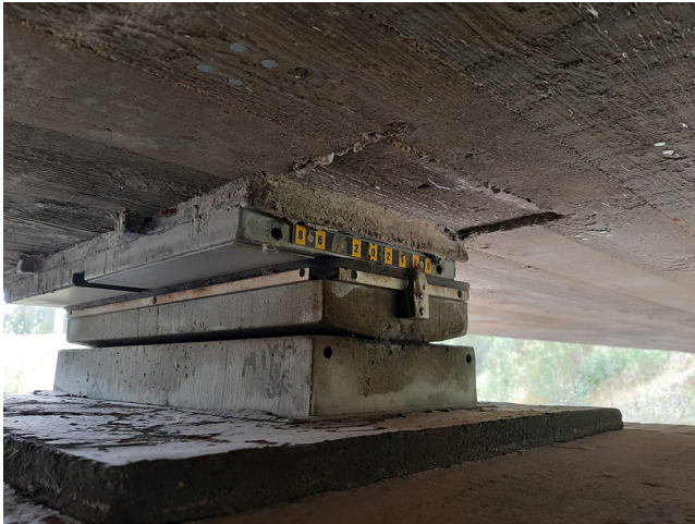
Kuva 24. Laakerin asennusvirhe. Liikevaran pitäisi olla +25 mm, mutta osoitin on 60...70 mm kohdalla (H-3058 Nohkuan alikulkusilta).
