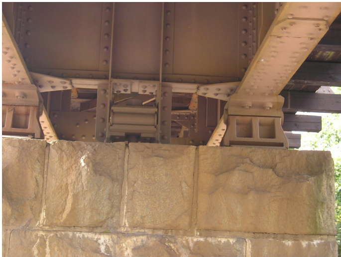
Kuva 9. Vetolaakeri (keskellä) (KaS-3088, Mansikkakosken vanha ratasilta).
