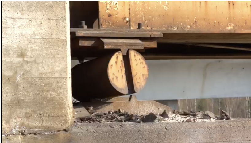
Kuva 21. Laakeri nousee irti alalevystä junan ylittäessä sillan (KaS-3063 Saimaan kanavan ratasilta).
