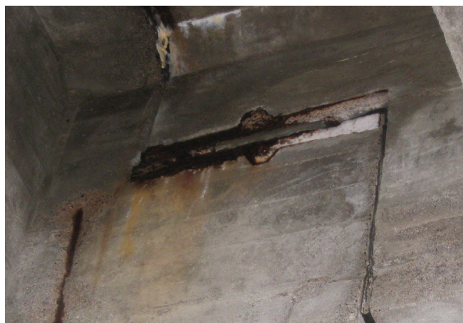
Kuva 2. Lyijylevylaakeri (nivelpalkkisillan nivel) (Karjaan ylikulkusilta).
