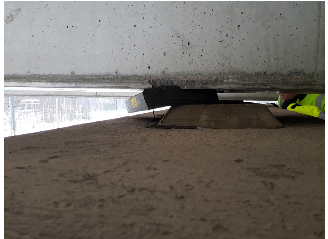
Kuva 26. "Kävelyn" seurauksen paikaltaan siirtynyt laakeri (T-6024 Kummun YKS).
