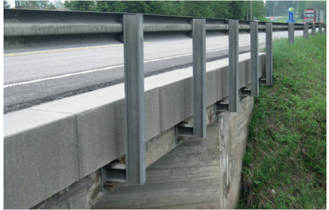
Kuva 33. Luonnonkivestä tehty reunapalkki (Maatianjärven silta, Korpilahti).
