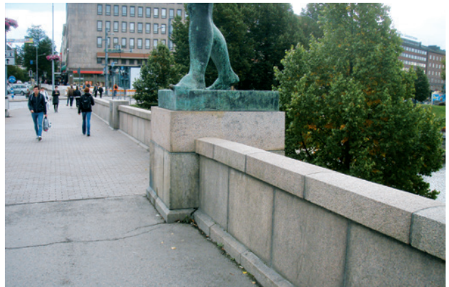
Kuva 34. Luonnonkivestä tehty ukkopylväs, patsaan jalusta ja kivikaide (Hämeensilta, Tampere).
