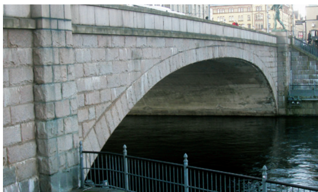
Kuva 3. Luonnonkiven käyttöä pitäisi lisätä siltarakenteiden verhouksissa (Hämeensilta, Tampere).
