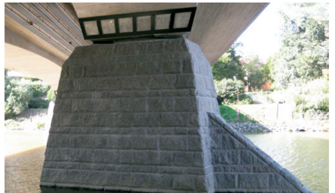
Kuva 7. Välituen ja jäänsärkijän kiverhous (Tuomaansilta, Turku).
