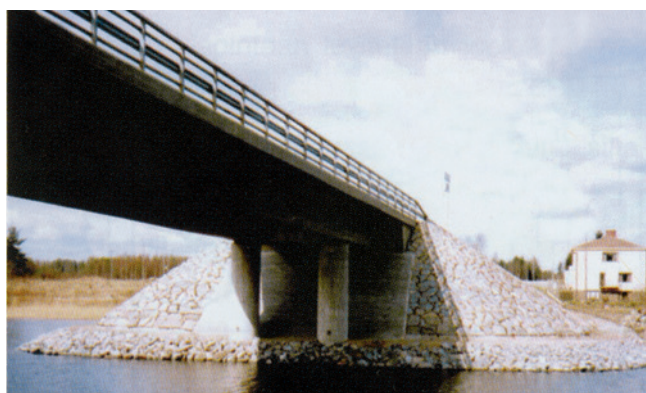
Kuva 2. Luonnonkiveä käytetään nykyisin yleisimmin sillan keiloissa ja luiskissa (Kortessalmen silta, Kangasniemi/Joutsa).
