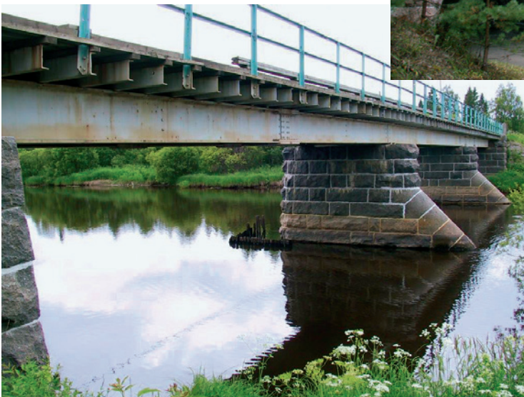
Kuva 3/3. Kaakamojoen silta (teräspalkki), Tornio, valmistunut vuonna 1935.
