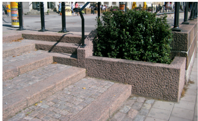
Kuva 41. Luonnonkivirakenteita Aurajoen rannalla (Turku).
