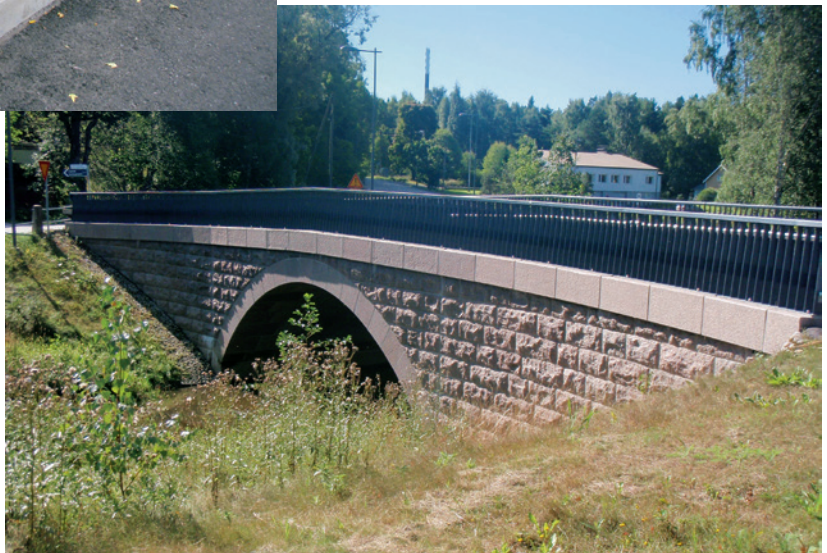
Kuva 4/4. Kannusilta, Espoo, valmistunut vuonna 2008.
