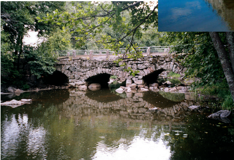
Kuva 1/3. Lapijoen silta, Eurajoki, valmistunut vuonna 1883.
