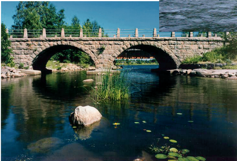
Kuva 2/3. Salmen silta, Hamina, valmistunut vuonna 1904.
