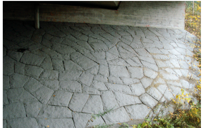
Kuva 36. Etuluiskan kivilaattaverhous.
