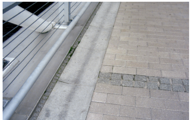
Kuva 38. Kivilaatoista tehty reunakouru ja noppakiveyksiä.
