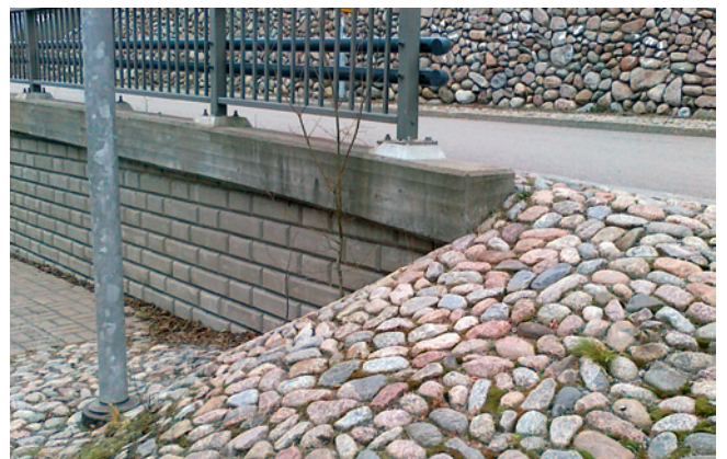
Kuva 37. Kenttäkiviverhous tukimuurin keilassa ja takana näkyvän tukimuurin verhouksena.
