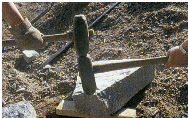
Kuva 20. Kivilaattaa työstetään lekalla ja meisselfillä.
