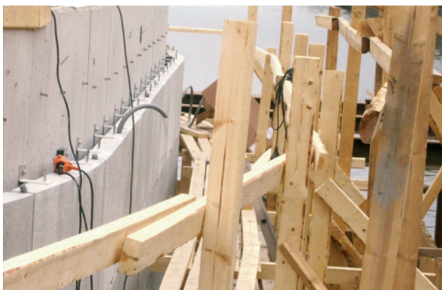
Kuva 31. Välituen kivilaattaverhous (Myllysilta, Turku).
