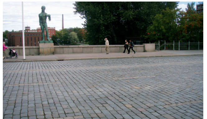
Kuva 6. Nupukivipäällyste sillan ajoradan päällysteenä (Hämeensilta, Tampere).
