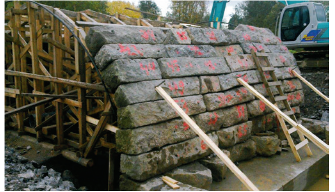
Kuva 5. Valtaalan silta (Isokyrö) purettiin ja koottiin uudestaan siten, että toinen kantamuuri perustettiin kalliolle ja toinen paalutetun teräsbetonilaatan varaan.
