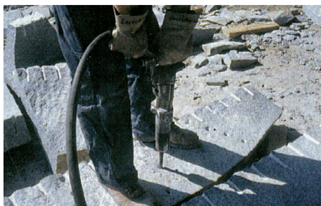
Kuva 17. Reikien poraus halkaisulinjaan
