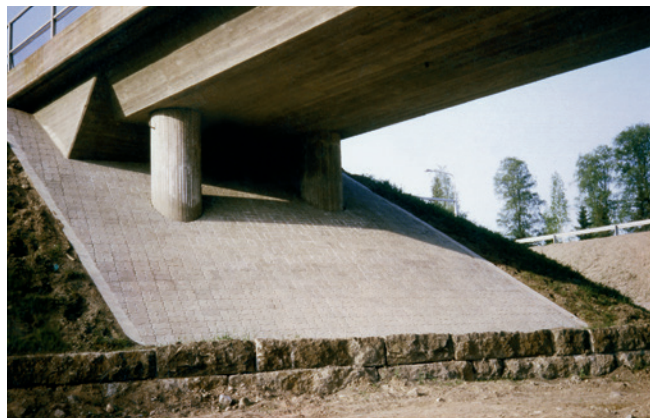
Kuva 35. Kivirakenteinen tukimuri etuluiskan juuressa.
