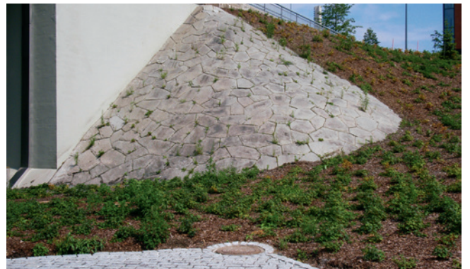
Kuva 8. Vuonna 1959 tehty keilan kivilaattaverhous puhdistettuna.
