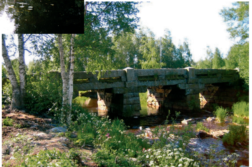
Kuva 1/4. Harrströmin (kivipalkki)silta, Korsnäs, valmistunut vuonna 1898.
