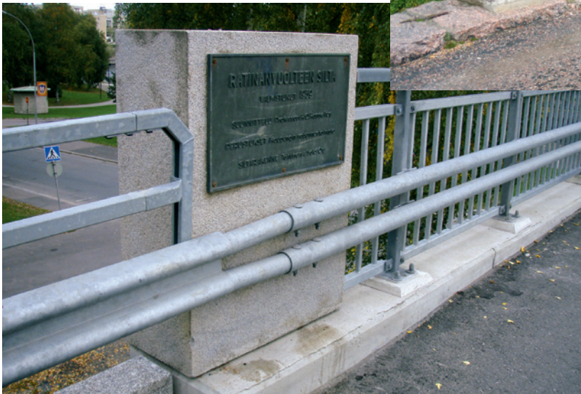
Kuva 4/3. Ukkopylväs, Ratinan silta, Tampere.
