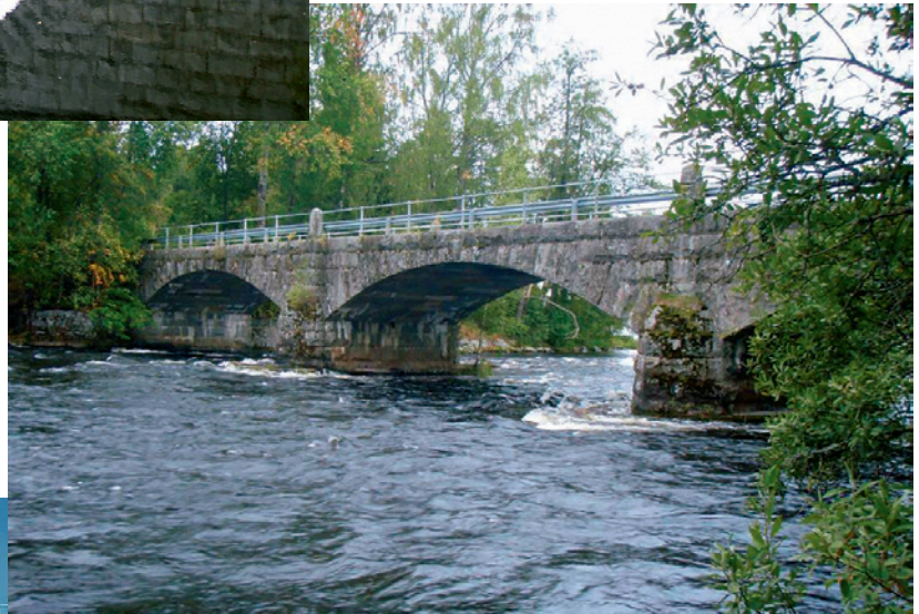
Kuva 2/2. Murolekosken silta, Ruovesi, valmistunut vuonna 1905.
