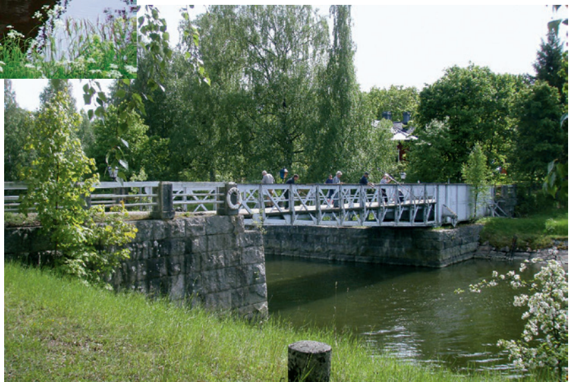
Kuva 3/4. Strömman kanavan silta (kääntösilta), Salo, valmistunut vuonna 1897.
