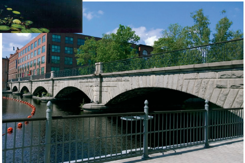
Kuva 2/4. Satakunnan silta, Tampere, valmistunut vuonna 1900.
