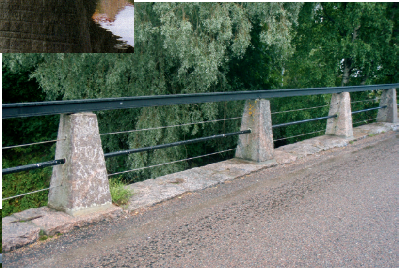
Kuva 4/2. Kaidepylväs, Brobackan silta, Vantaa.
