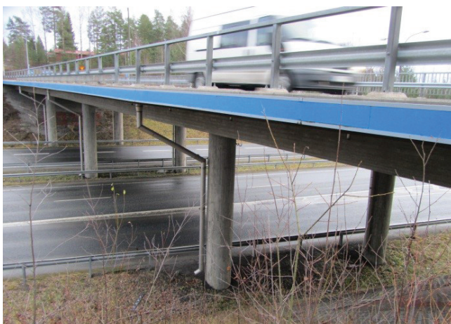
Kuva 23. Oikein jatkettut syöksytorvet.
