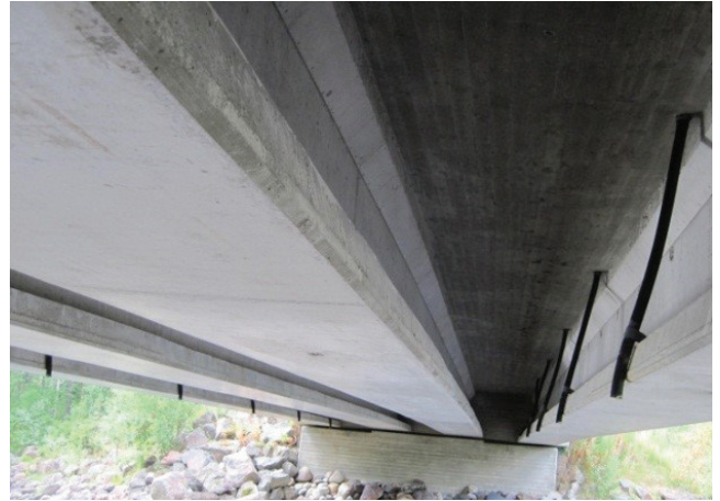
Kuva 17. Tippuputket on jatkettu PE-putkilla.
