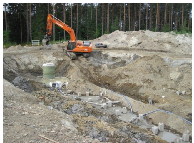
Kuva 49. Alikulkukäytävän pumppaamo rakenteilla.
