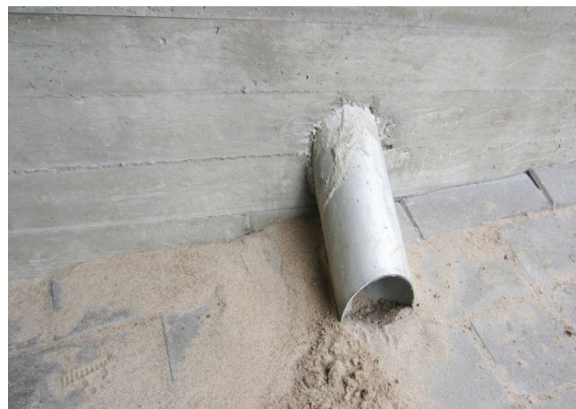
Kuva 25. Vedenpoistoputki etumuurin läpi.
