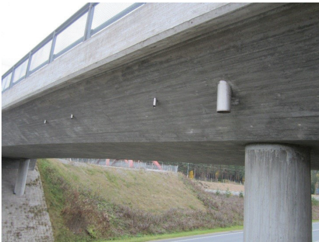
Kuva 41. Sillan reunoissa olevat tippuputket ja syöksytorvi.
