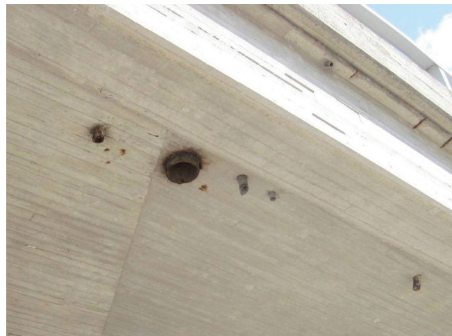
Kuva 42. Tippuputket syöksytorven vieressä.
