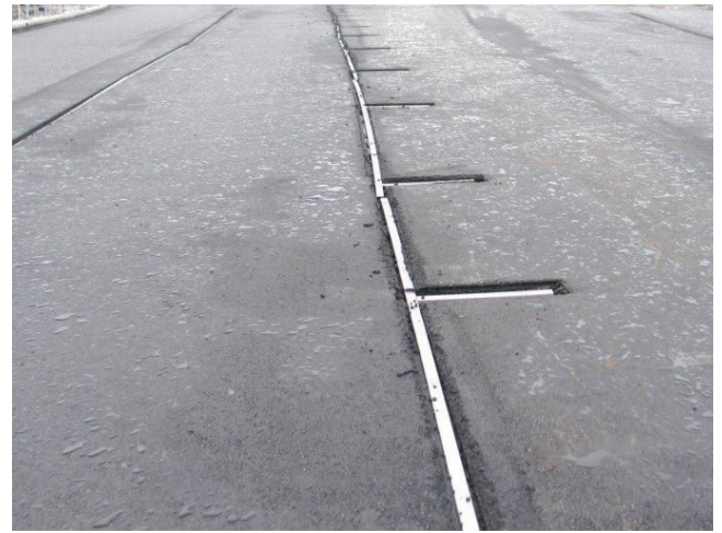
Kuva 45. Salaojat tippuputkilinjan päällä ja tulevan reunatuen alla.
