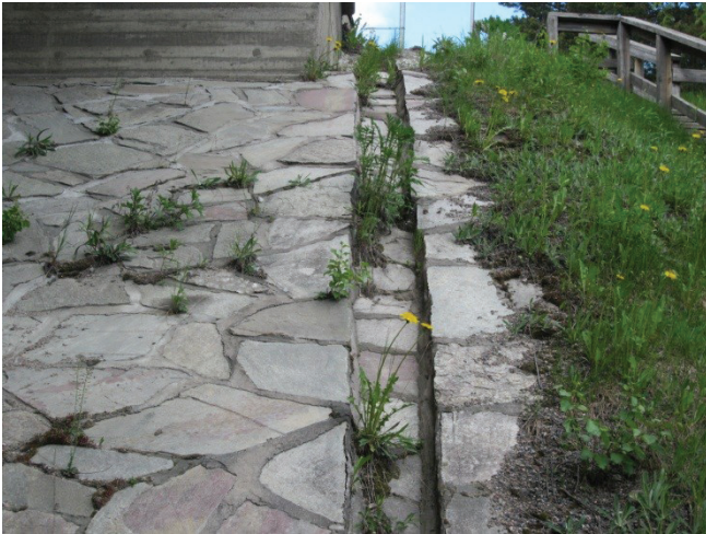
Kuva 38. Hulevesikouruksi muotoiltu etuluiskan reuna.
