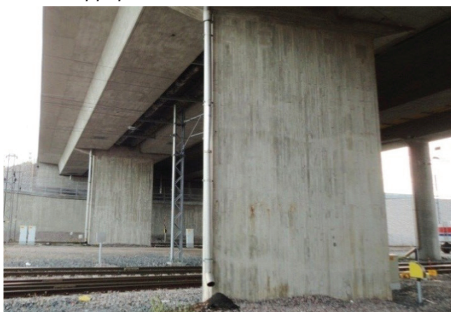
Kuva 3. Oikein rakennettu syöksytorven jatkoputki.
