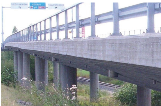
Kuva 2. Sillan päällysrakenteen syöksytorvet ja tippuputket.
