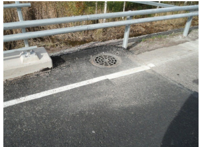
Kuva 33. Asfalttireunus ja hulevesikaivo.
