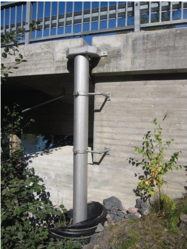
Kuva 39. Muoviputkesta tehty loiskekuppi.
