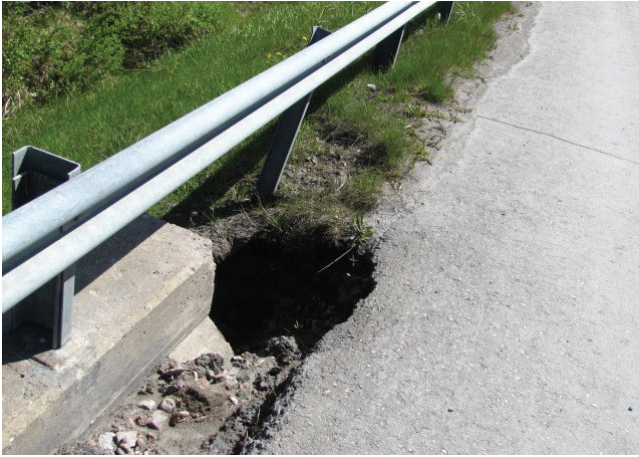
Kuva 8. Liikenneturvallisuutta vaarantava syöpymä.
