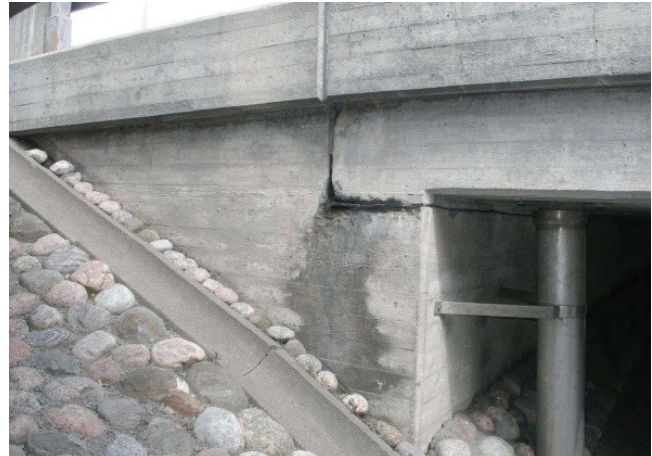
Kuva 27. Betoninen hulevesikouru etuluiskan reunassa.
