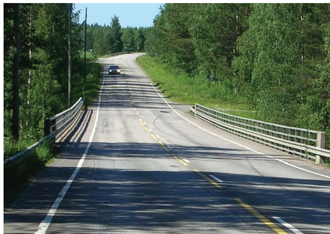
Kuva 21. Kovera tiegeometria siltapaikalla.
