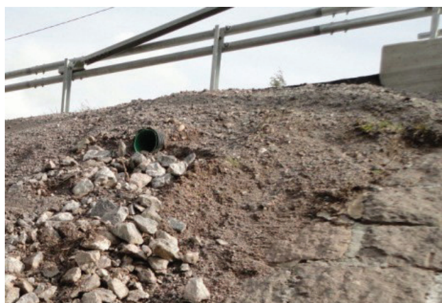
Kuva 26. Hulevesiputki ja eroosiosuojaus luiskassa.
