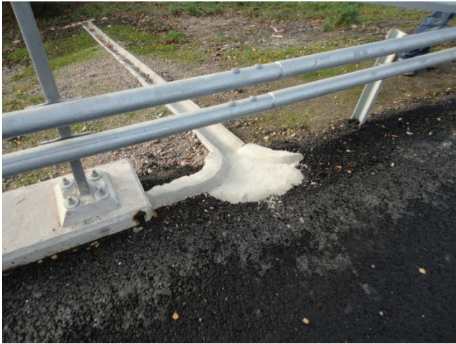
Kuva 34. Reunus ja suppilo hulevesikourun yläpäässä.
