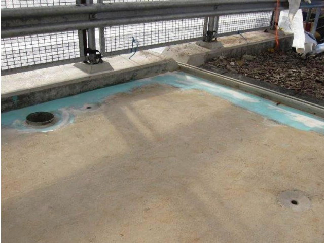
Kuva 43. Syöksytorven ja tippuputken korkeusasetat ennen kannen eristystä.
