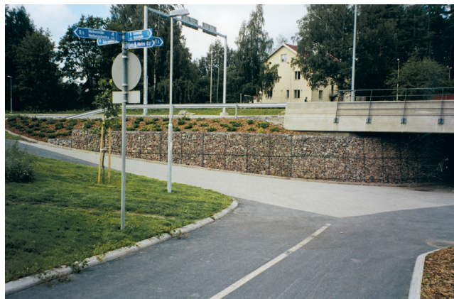
Kuva 20. Säännöllisen muotoinen tukimuri kivikoreista.
