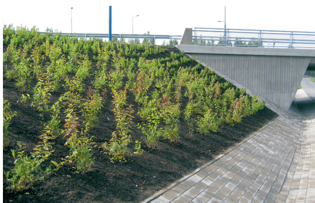
Kuva 3. Siltapaikkaa pehmentävä pensasverhous.
