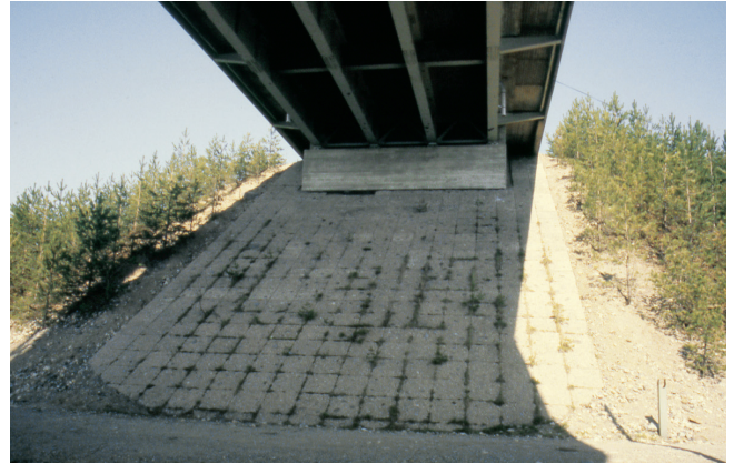
Kuva 18. Korkeahko betonilaattaverhous etu-luiskassa.
