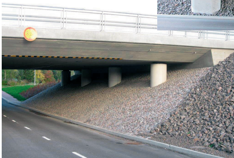
Kuva 1/11. Kenttäkiviverhous etuluiskassa.
