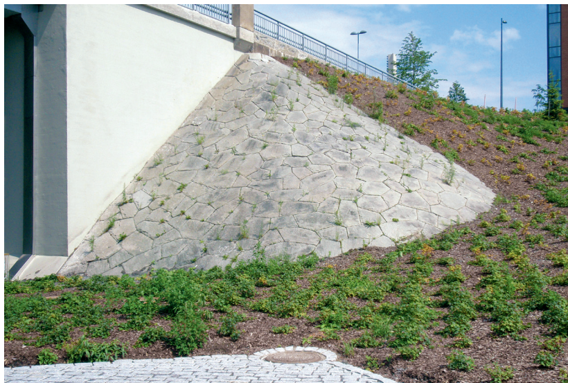
Kuva 1/1. Hyvin tehty kivikeila on kestävä (Ratinan silta, Tampere).
