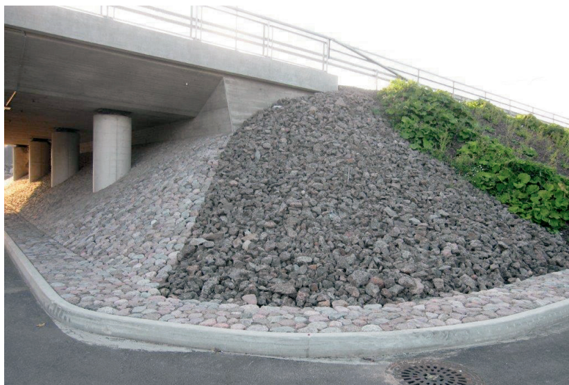
Kuva 1/9. Molskottiverhous keilassa.
