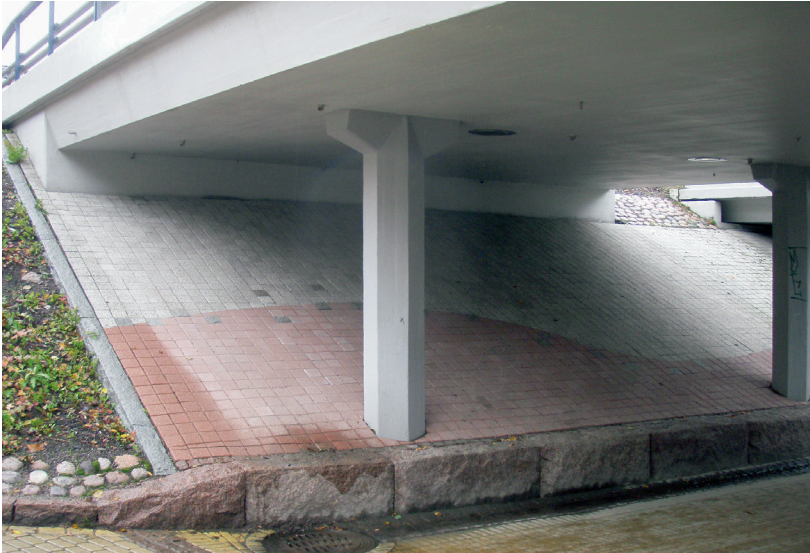
Kuva 2/1. Betonikiviverhous etuluiskassa.
