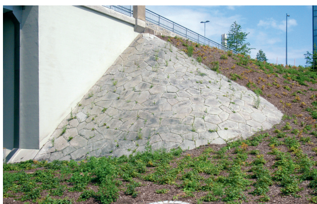
Kuva 1. Oikeaoppinen yli 50-vuotias kivilaatta-verhous puhdistettuna.
