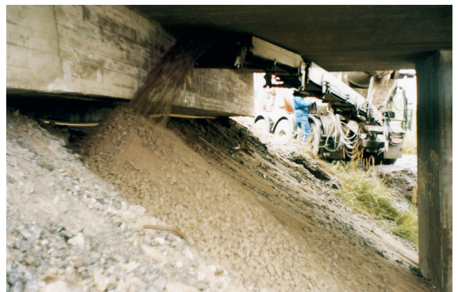
Kuva 31. Verhouksmateriaalin siirtoa kansilaatan alle hihnakuljettimella.
