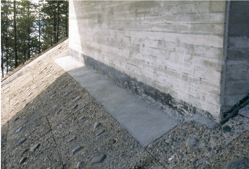
Kuva 2/5. Betonilaattaverhous ja tarkastustasanne.
