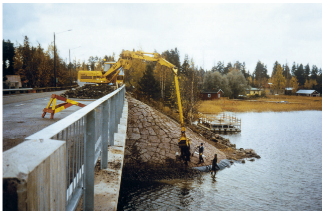
Kuva 16. Keilan kivilaattaverhousta korjataan.
