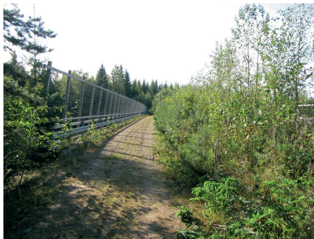
Kuva 13. Viherrakenteet sillan kannella.
