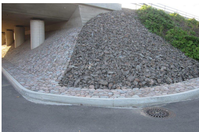
Kuva 17. Etuluiskassa kenttäkiviverhous ja keilassa molskottiverhous.
