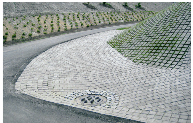
Kuva 19. Betonikiviverhouksia.
