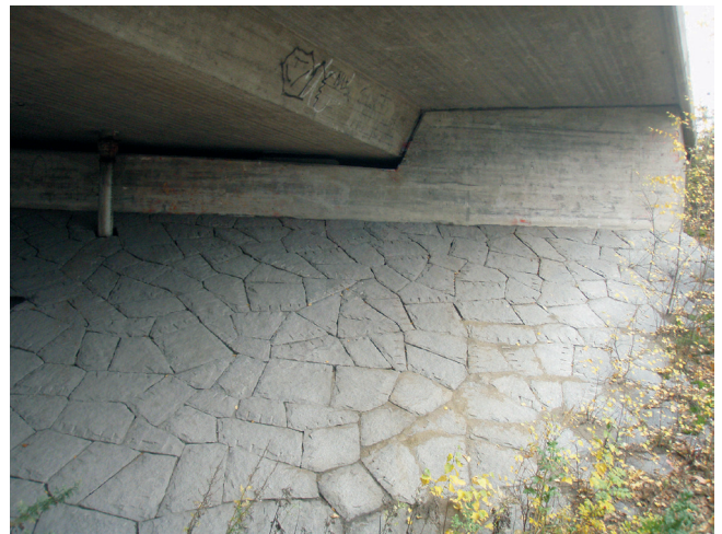
Kuva 37. Huolellisesti tehty etuluiskan kivilaattaverhous.
