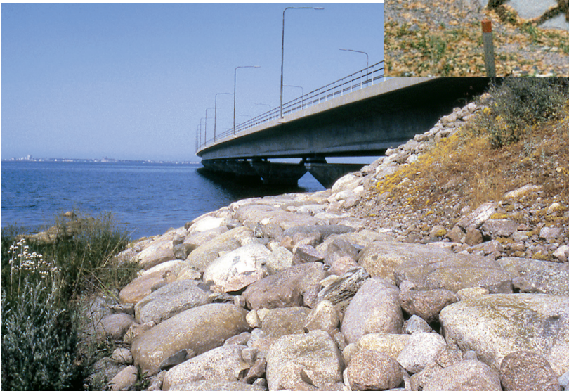
Kuva 1/7. Massiivinen kiviheitoverhous.
