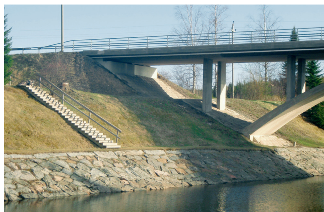
Kuva 26. Jätkänpolku ja välitasanne korkeassa etuluiskassa.
