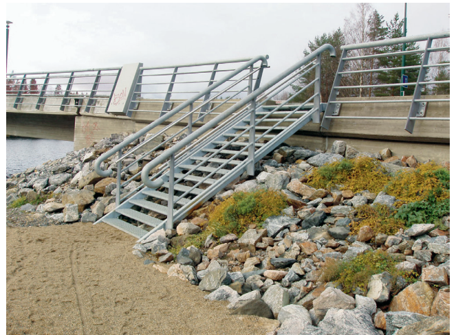
Kuva 40. Teräsporras sillan päässä.
