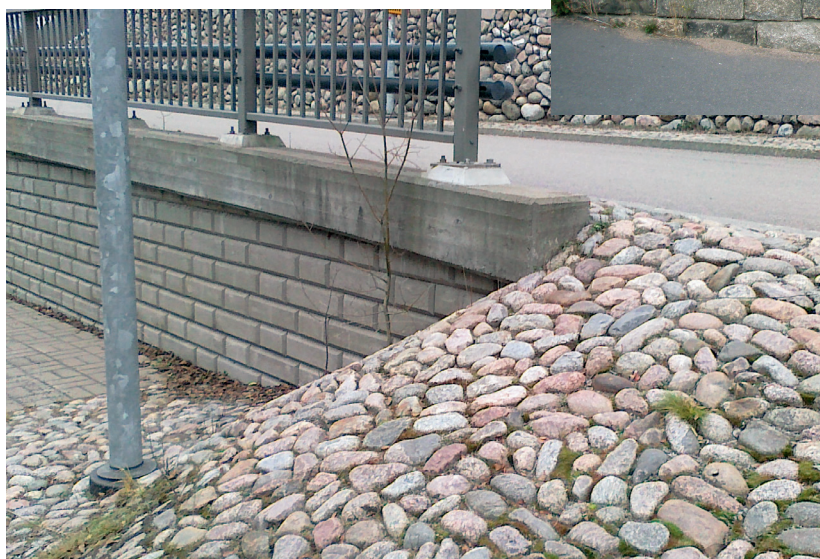
Kuva 1/3. Kenttäkivipintainen keilan ja tukimuurin verhouk.
