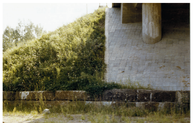
Kuva 32. Kylmämuuri keilan ja etuluiskan juurella.
