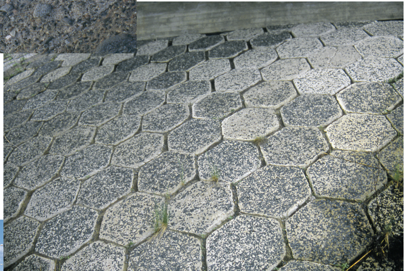
Kuva 2/6. Pesubetonilaattaverhous.
