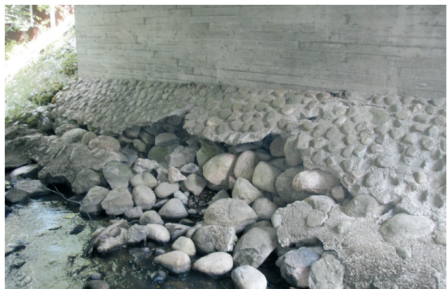
Kuva 11. Eroosiovaurio etuluiskassa.
