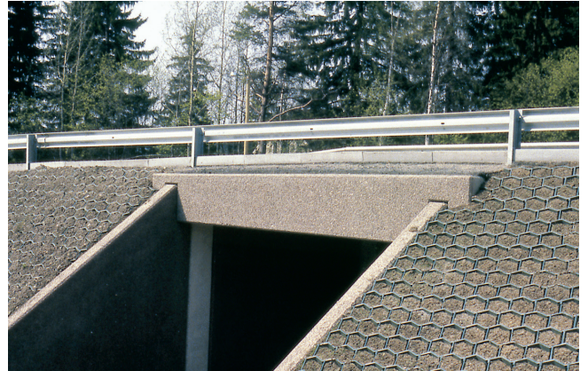
Kuva 14. Nurmiverhous on sidottu muovikennolla.
