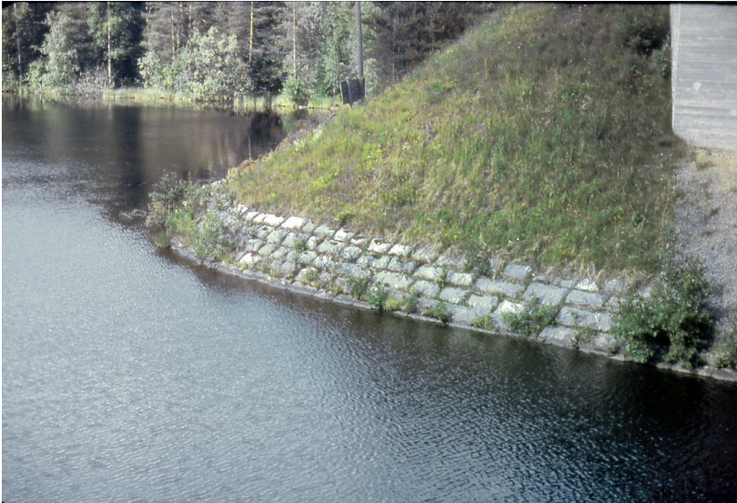
Kuva 1/5. Palkkiverhous keilan alaosassa.
