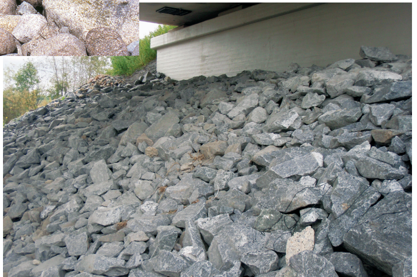
Kuva 1/8. Järjestetty kiviheitokeverhous.
