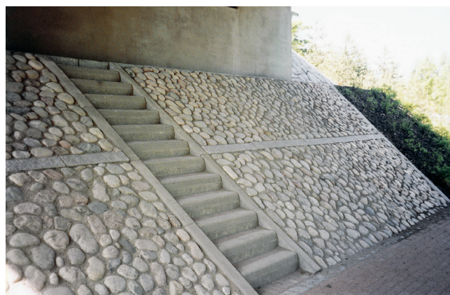
Kuva 27. Tarkastustasanne etuluiskan yläosassa ja tasanteelle johtavat portaat.
