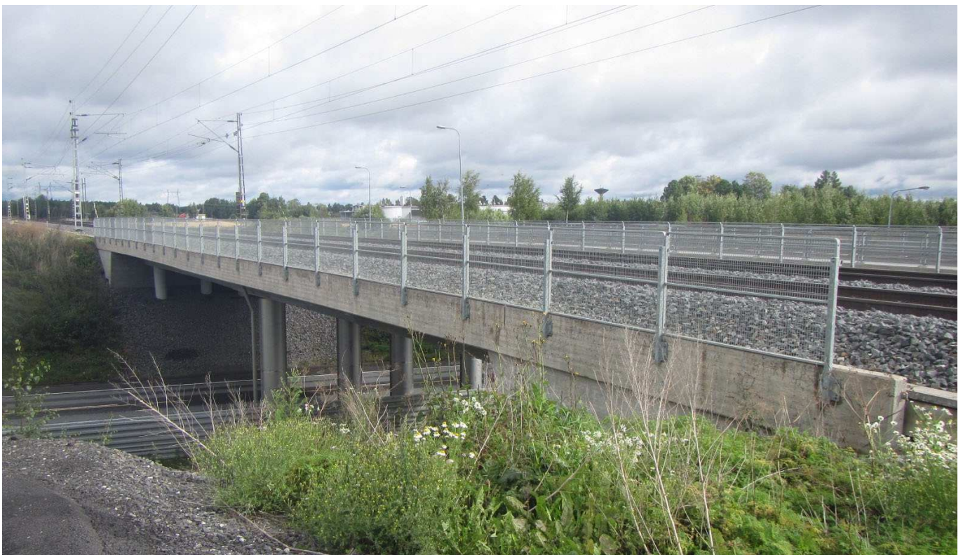
Kuva 30. Jännitetty betoninen jatkuva ulokelaattasilta (jBjul). Pohjan alikulkusilta (V-2701), Seinäjoki.
