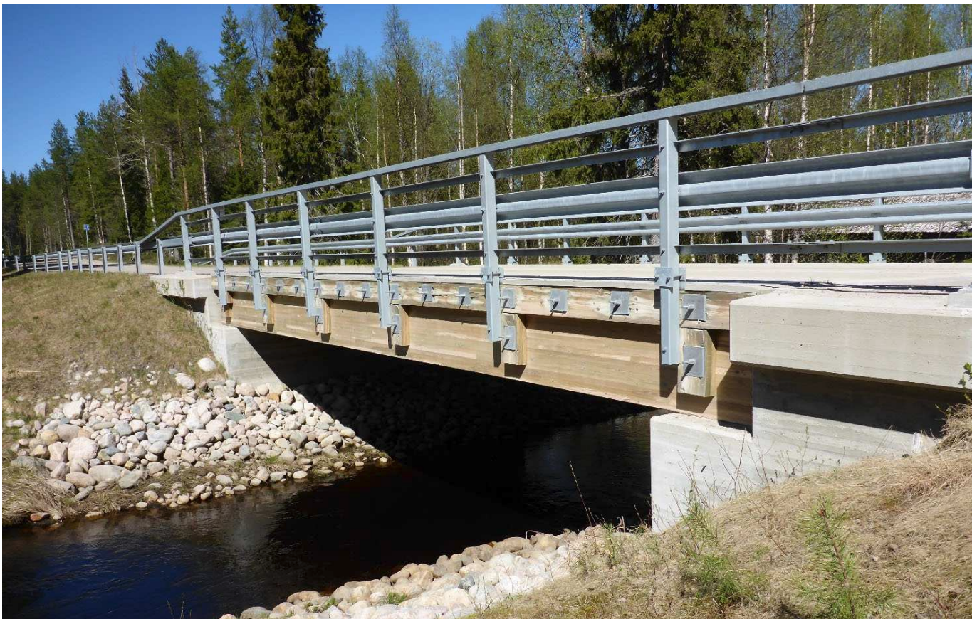
Kuva 44. Puinen liimattu palkkisilta (Plp). Teuronjoen silta (L-2244), Posio.
