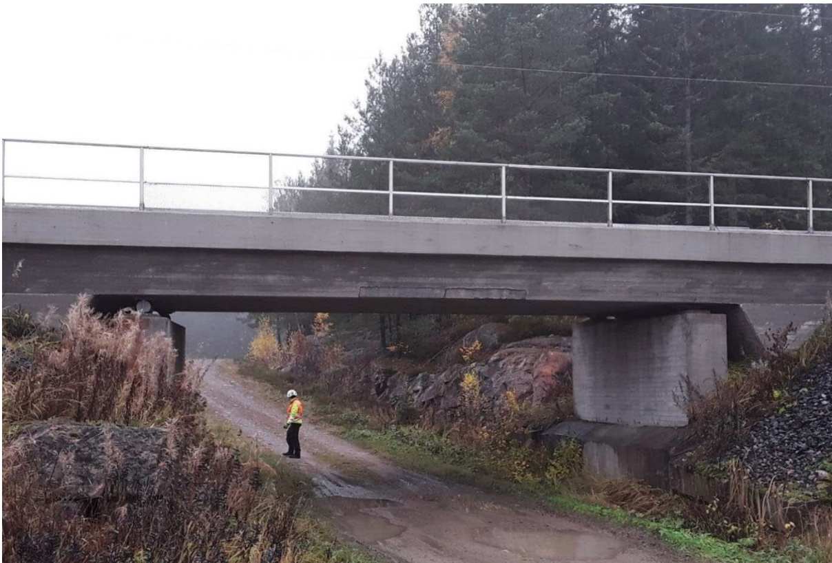
Kuva 12. Teräsbetoninen ulokekaukalopalkkisilta (Bukaup). Vestergården alikulkusilta (U-3894), Raasepori.
