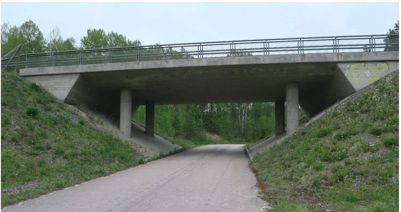
Kuva 4. Teräsbetoninen ulokelaattasilta (Bul). Raidiston risteysilta (H-2578), Orivesi.
