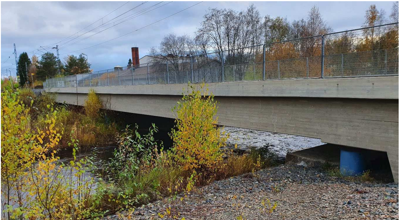
Kuva 27. Jännitetty betoninen jatkuva ulokekaukalopalkkisilta (jBjukaup). Kruununkylänjoen ratasilta (V-2712), Kruunupyy.
