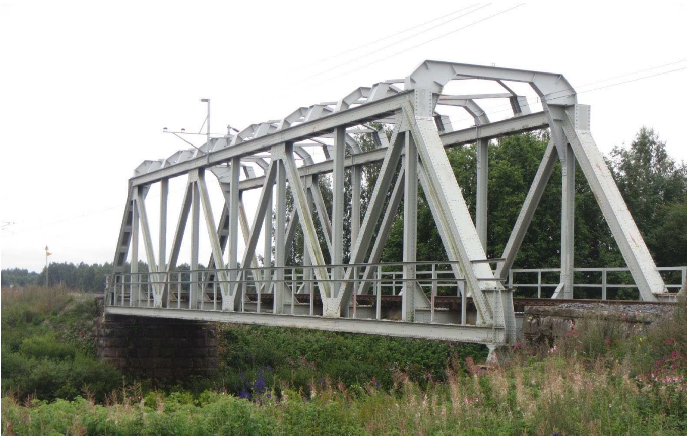
Kuva 37. Teräksinen ristikkosilta (Tr). Munakan ratasilta (Kyrönjoki) (V-2628), Ilmajoki.
