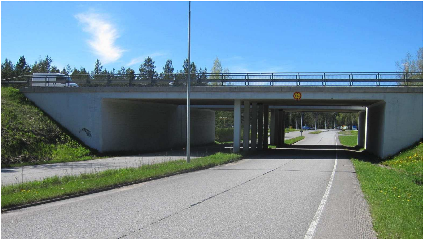
Kuva 23. Teräsbetoninen jatkuva laattakehäsilta (Bjlk). Paimalan risteyssilta (T-2387), Turku.
