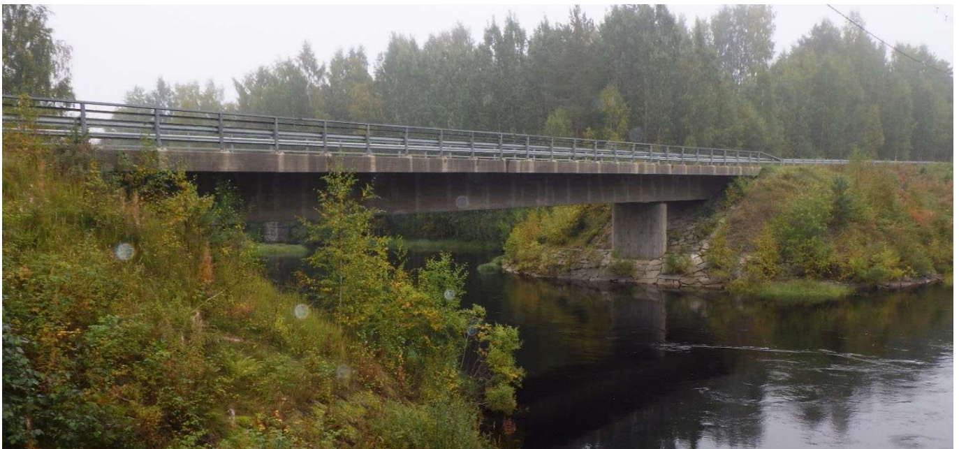
Kuva 16. Teräsbetoninen ulokekotelopalkkisilta (Bukp). Pisankosken silta (SK-198), Kuopio.
