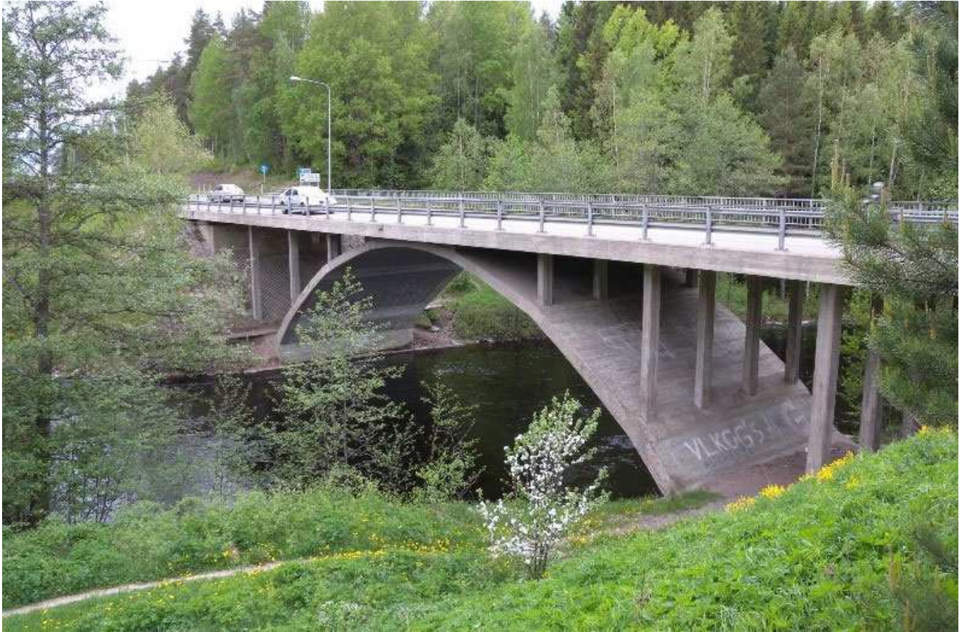
Kuva 17. Teräsbetoninen kaarisilta (Bkr). Käyräjoen silta (KaS-666), Kouvola.
