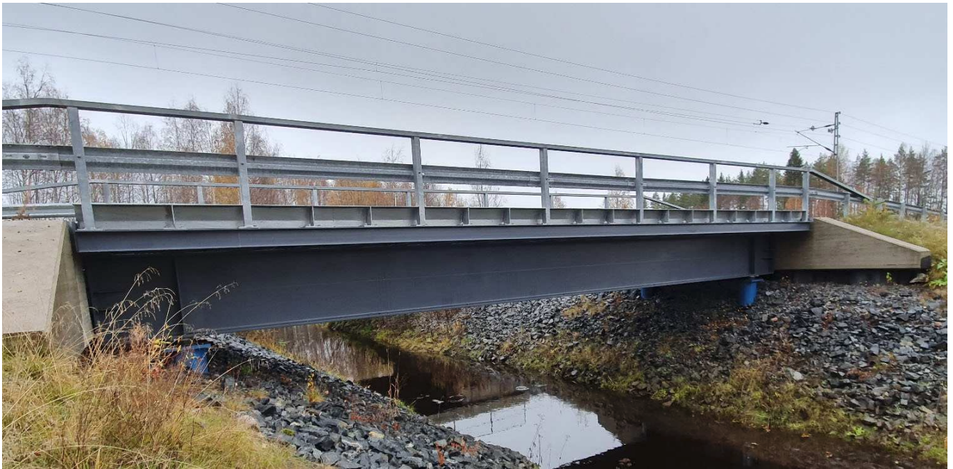
Kuva 31. Teräksinen palkkisisilta (Tp). Vaikonojan huoltotiesilta (O-4899), Oulainen.
