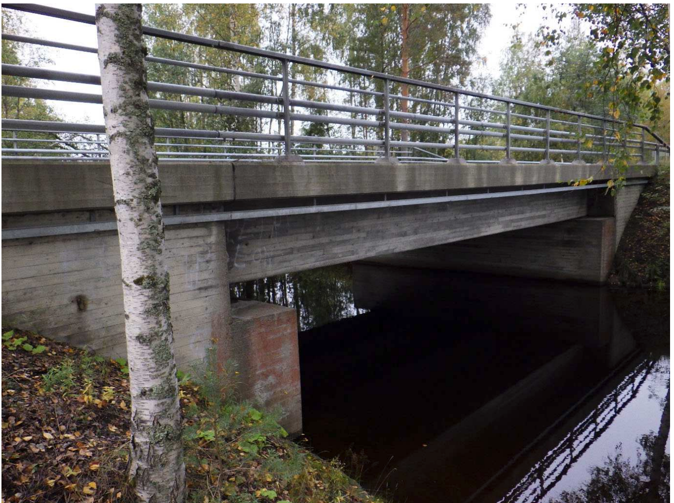
Kuva 6. Teräsbetoninen palkkisilta (Bp). Rapionjoen silta (SK-2260), Juva.
