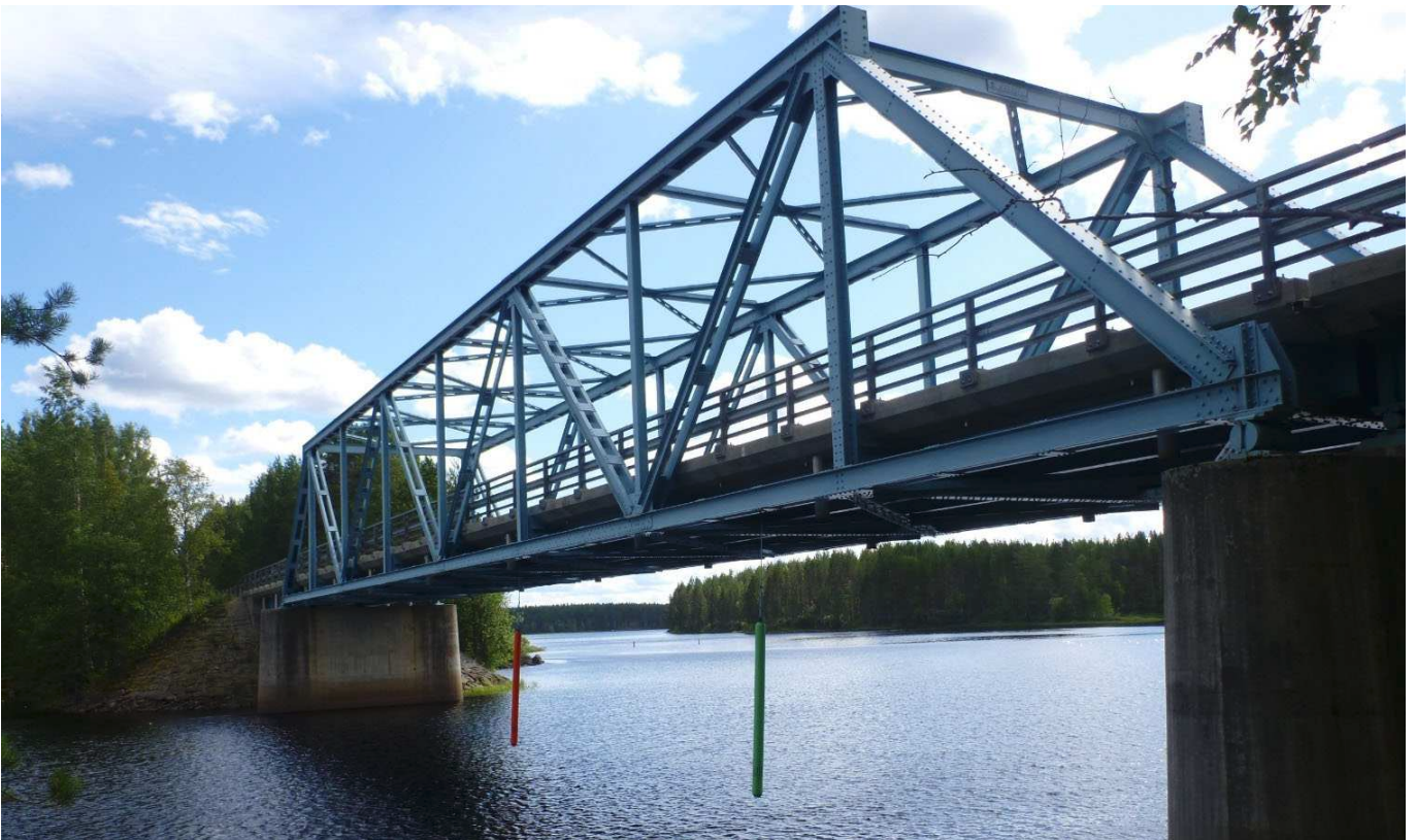
Kuva 38. Teräksinen ristikkosilta, betonikantinen (Trb). Oinassalmen silta (SK-1243), Ilomantsi.
