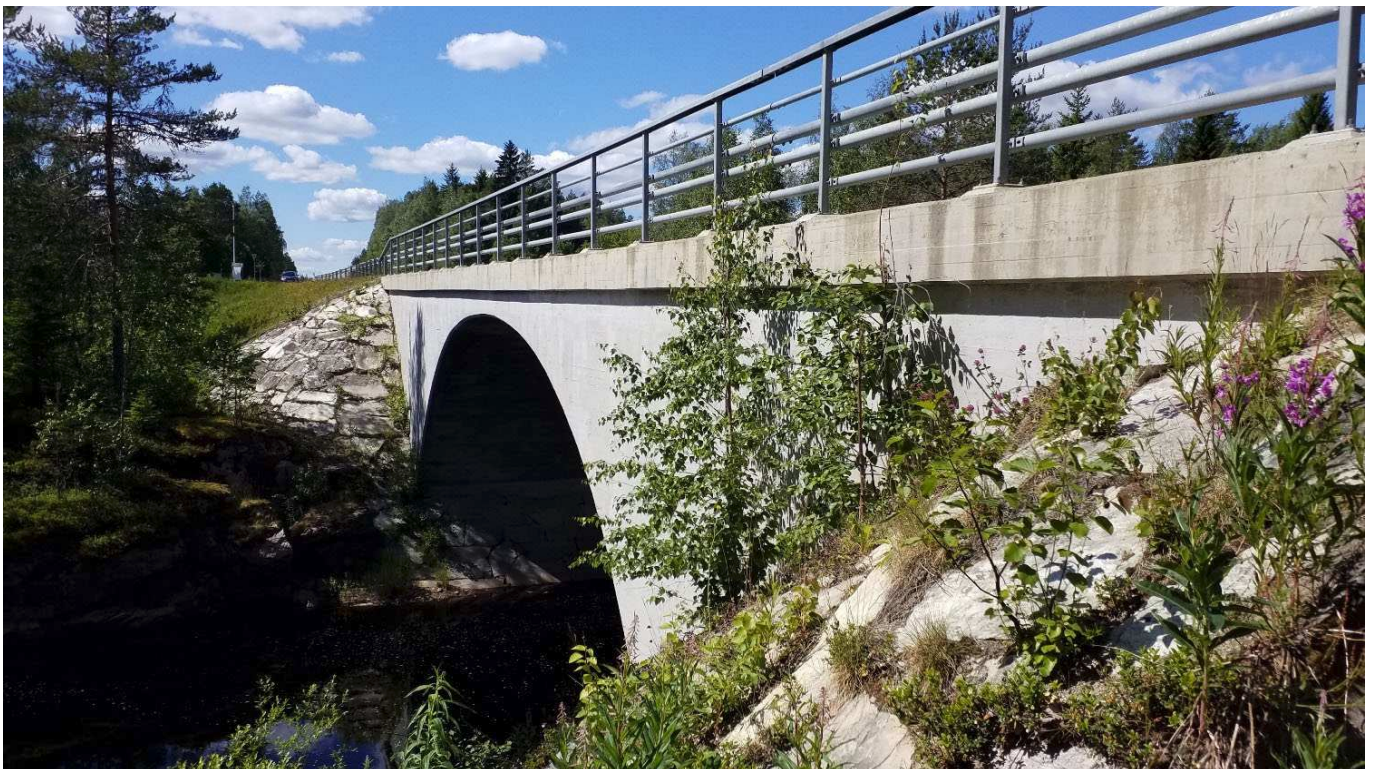
Kuva 18. Teräsbetoninen holvisilta (Bh). Lapinjoen silta (SK-444), Rautavaara.
