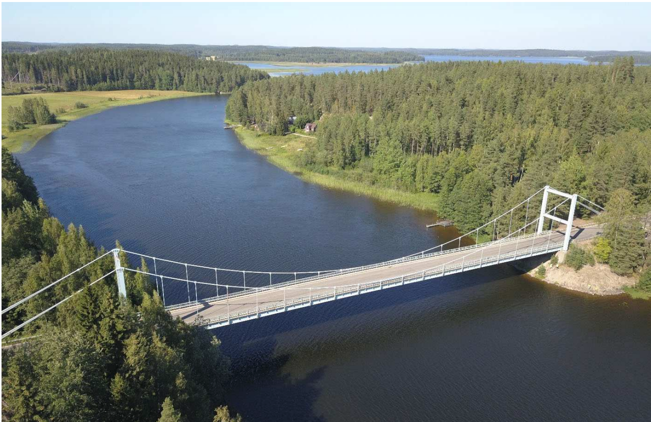
Kuva 41. Teräksinen riippusilta, betonikantinen (Trpb). Virran silta (KaS-665), Iitti.
