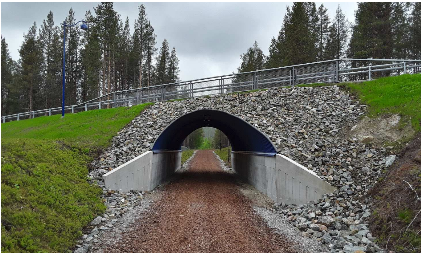
Kuva 47. Teräksinen holvisilta (Th). Koutamaantien alikulukäytävä (L-2013), Kittilä.
