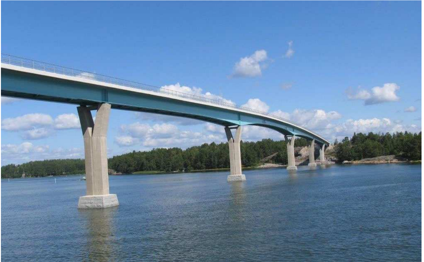
Kuva 33. Teräksinen jatkuva palkkisilta, betonikantinen, liittorakenteinen (Tjpb). Lövön silta (T-2581), Kemiönsaari.
