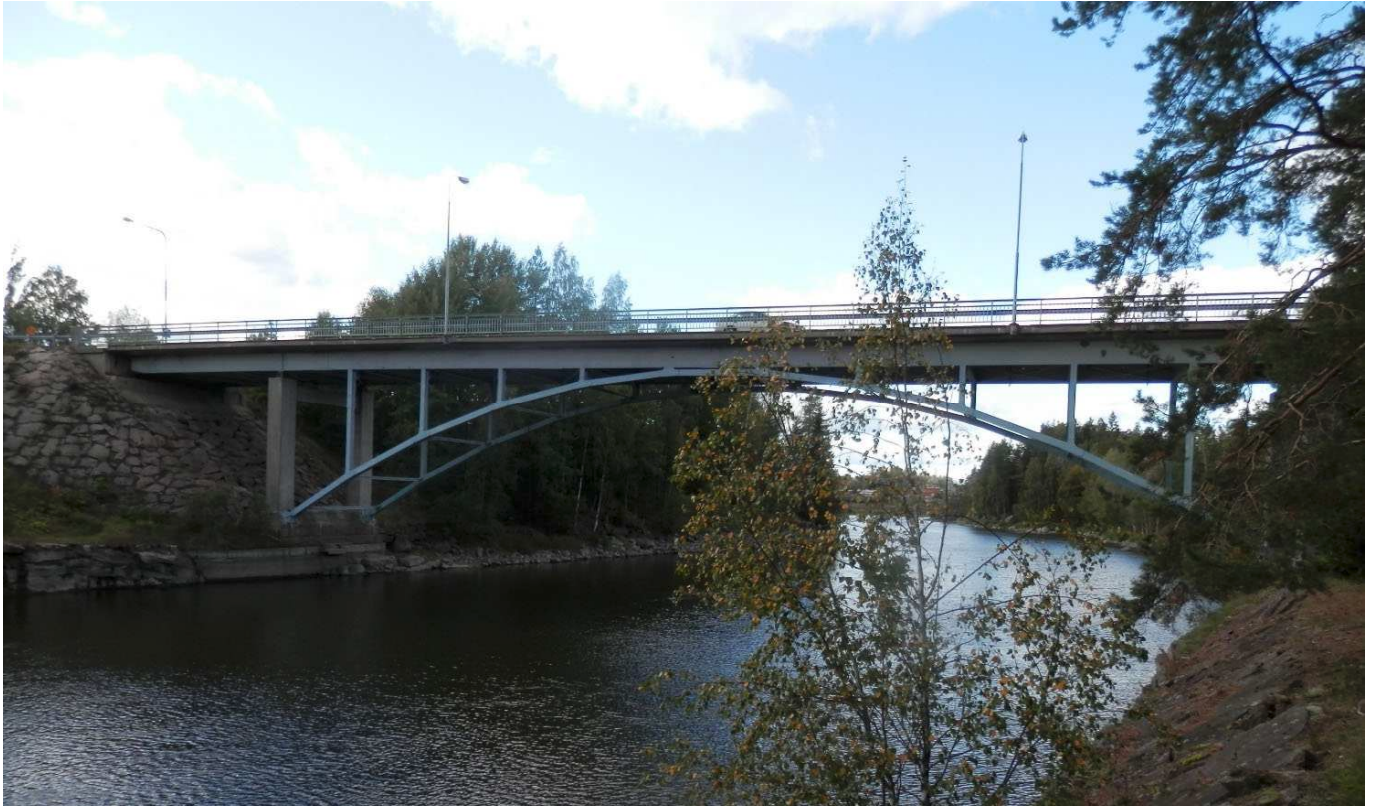
Kuva 39. Teräksinen kaarisilta, betonikantinen (Tkrb). Keskikosken silta I (KaS-91), Kouvola.
