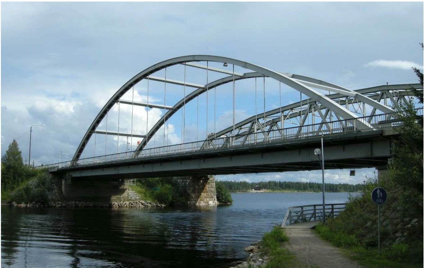
Kuva 40. Teräksinen Langerpalkkisilta, betonikantinen (Tlangerpb). Kiehimänjoen silta (O-2023), Paltamo.
