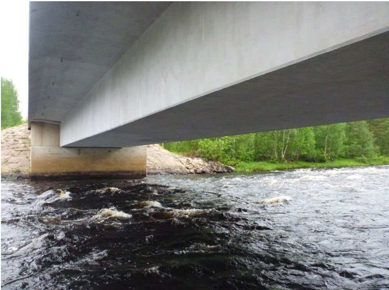
Kuva 14. Teräsbetoninen kotelopalkkisilta (Bkp). Meltausjoen silta (L-1513), Rovaniemi.
