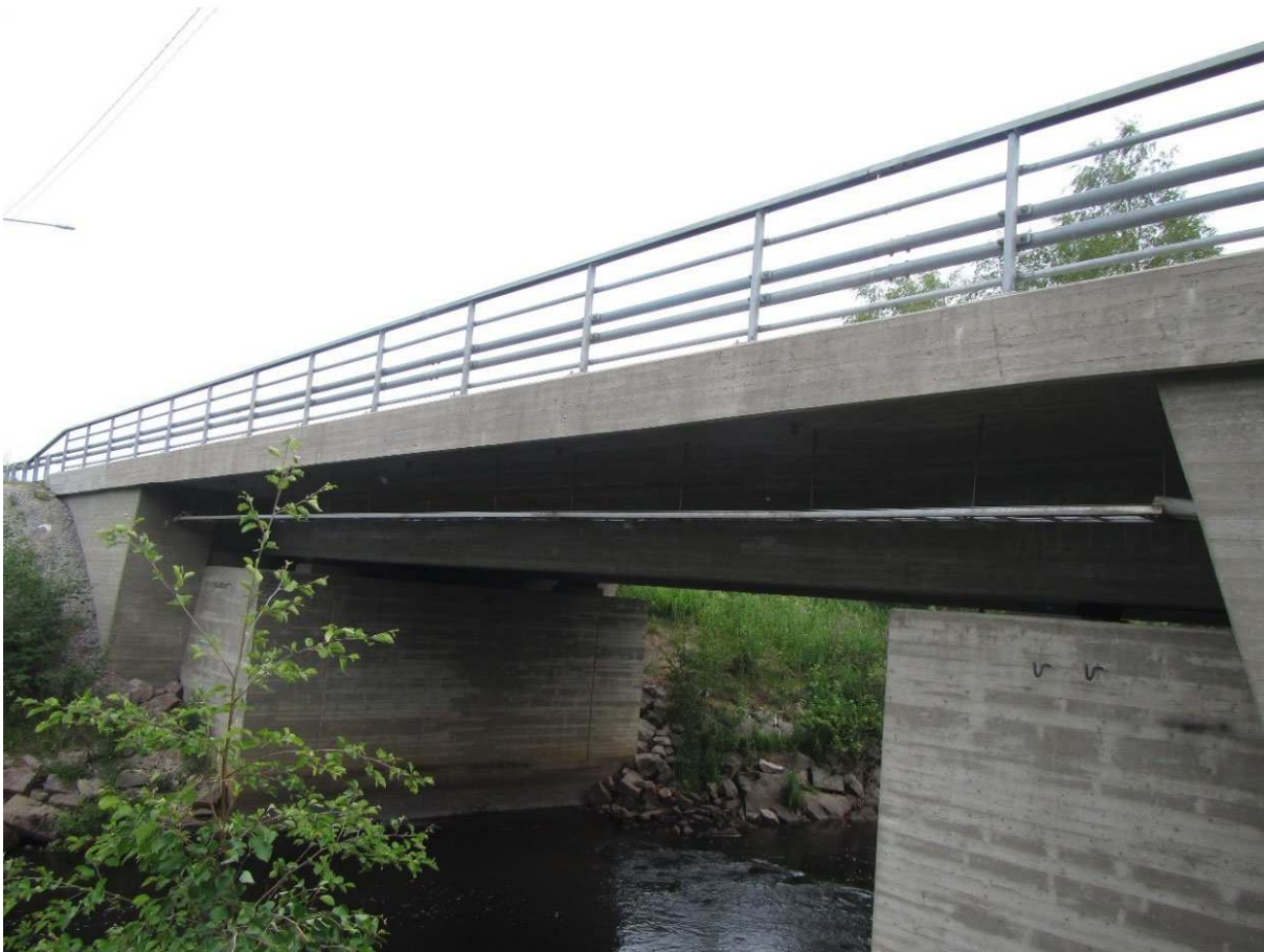
Kuva 8. Teräsbetoninen ulokepalkkisilta (Bup). Vääräjoen silta (O-3172), Sievi.
