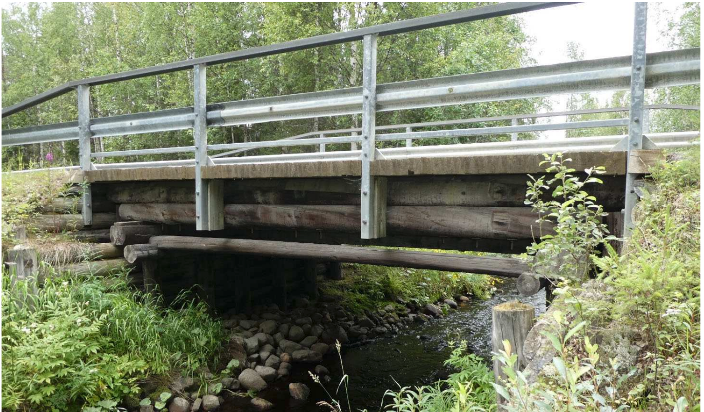
Kuva 43. Puinen palkkisilta (Pp). Outojoen silta (O-2457), Suomussalmi.
