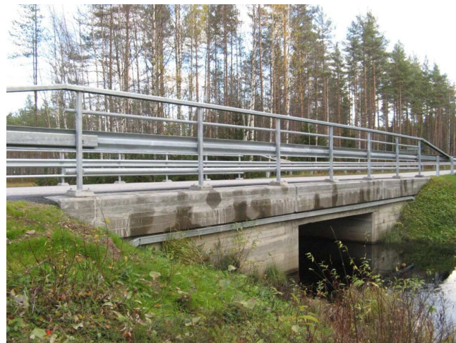
Kuva 13. Yksittäisen kaapelin sijoittaminen teräskoteloon.
