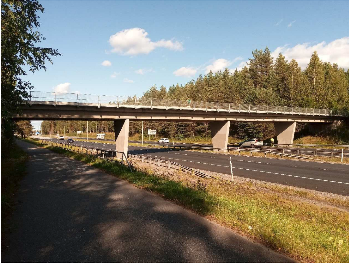
Kuva 11. Teräsbetoninen jatkuva kaukalopalkkisilta (Bjkaup). Käpykankaan alikulkusilta, vt 6 (SK-2939), Joensuu.
