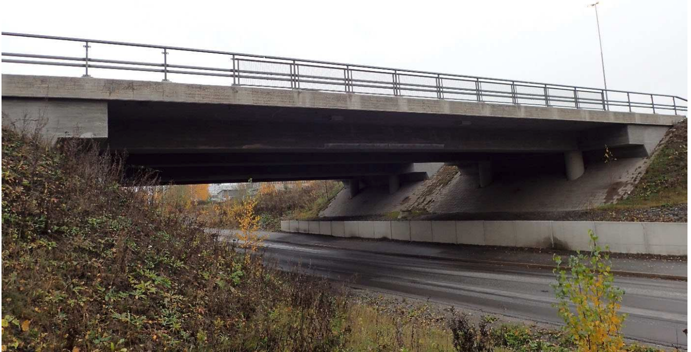
Kuva 25. Jännitetty betoninen ulokepalkkisilta (jBup). Turkkiradan risteyssilta (H-2710), Pirkkala.
