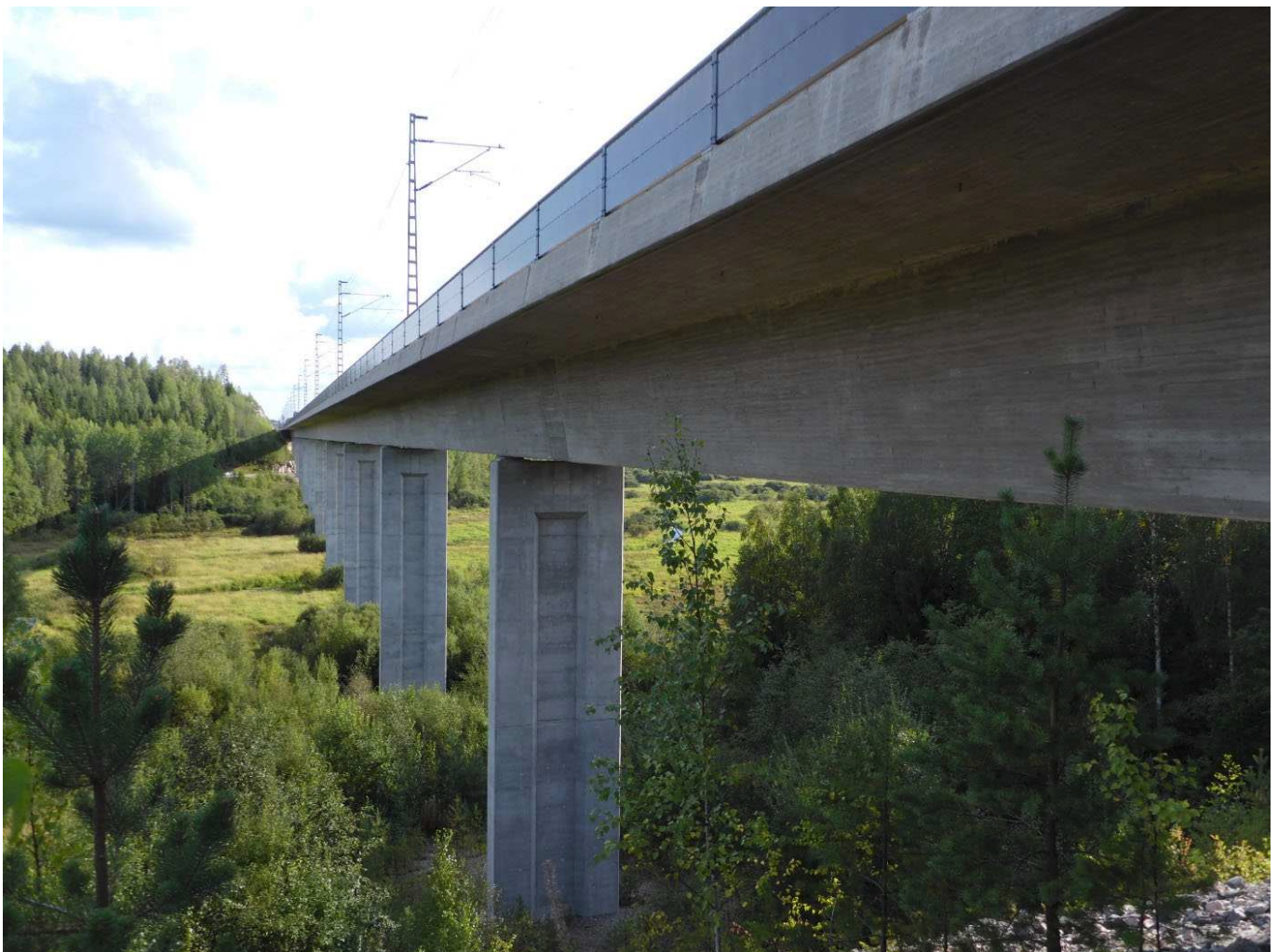
Kuva 28. Jännitetty betoninen jatkuva kotelopalkkisilta (jBjkp). Luhdanmäen ratasilta (U-4308), Hollola.
