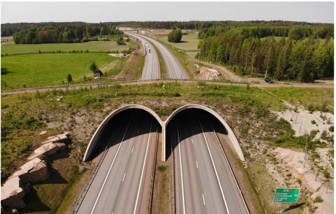
Kuva 20. Teräsbetoninen jatkuva holvisilta (Bjh). Niitynpään vihersilta (KaS-1521), Pyhtää.
