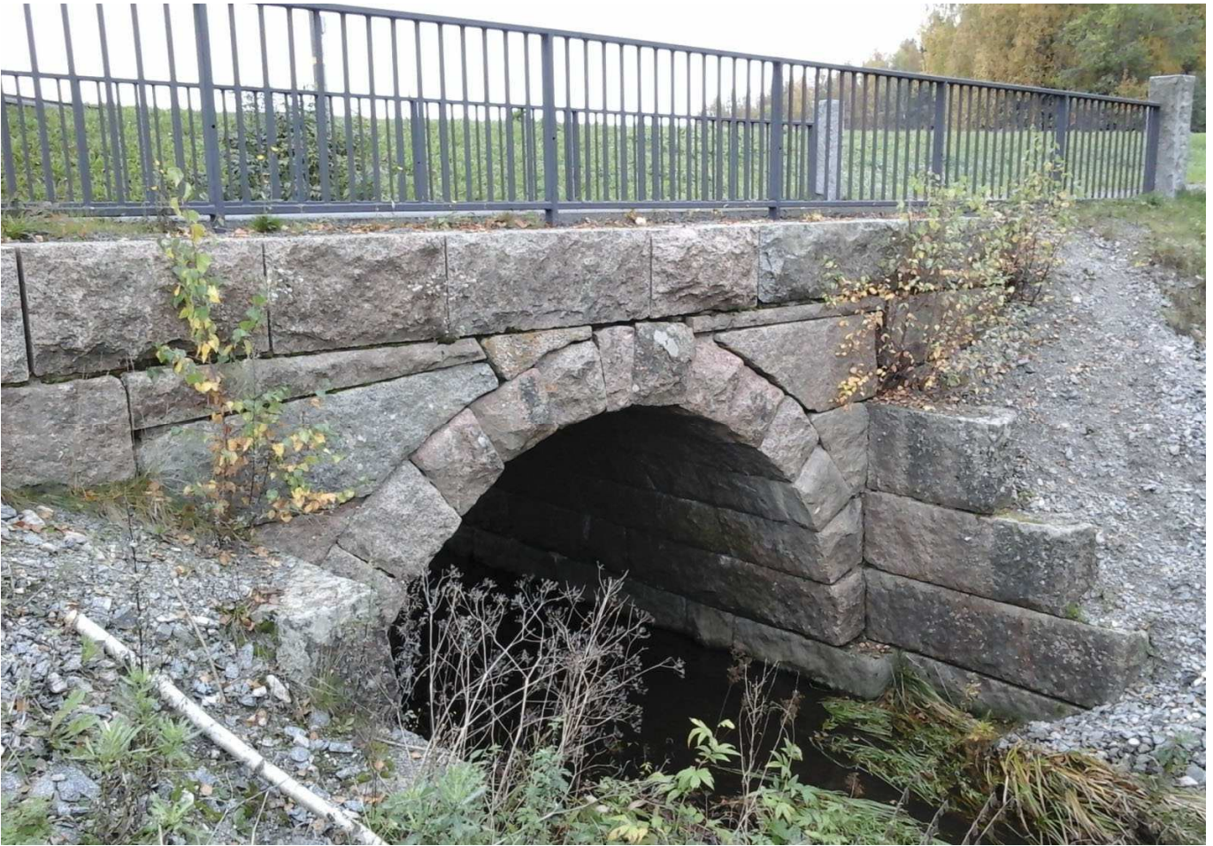
Kuva 45. Kivinen holvisilta (Kh). Kyrönojan raittisilta (U-3196), Hattula. Kiviset sillat ovat melko harvinaisia Suomessa.
