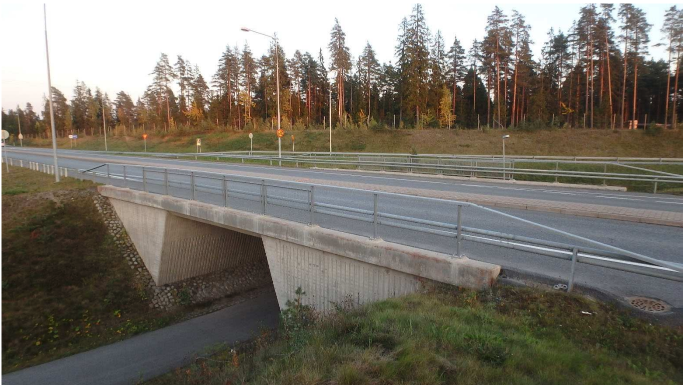
Kuva 22. Teräsbetoninen vinojalkainen laattakehäsilta (Bvlk). Saasterinteen alikulkukäytävä (U-3012), Lohja.
