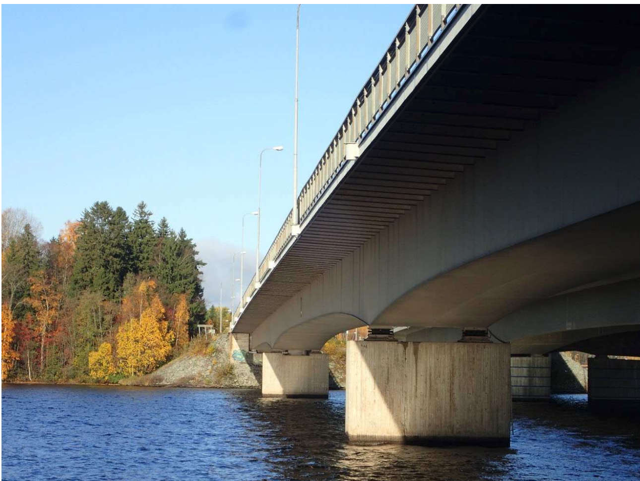
Kuva 36. Teräksinen jatkuva kotelopalkkisilta (Tjkp). Rajasalmen silta (H-1147), Pirkkala.
