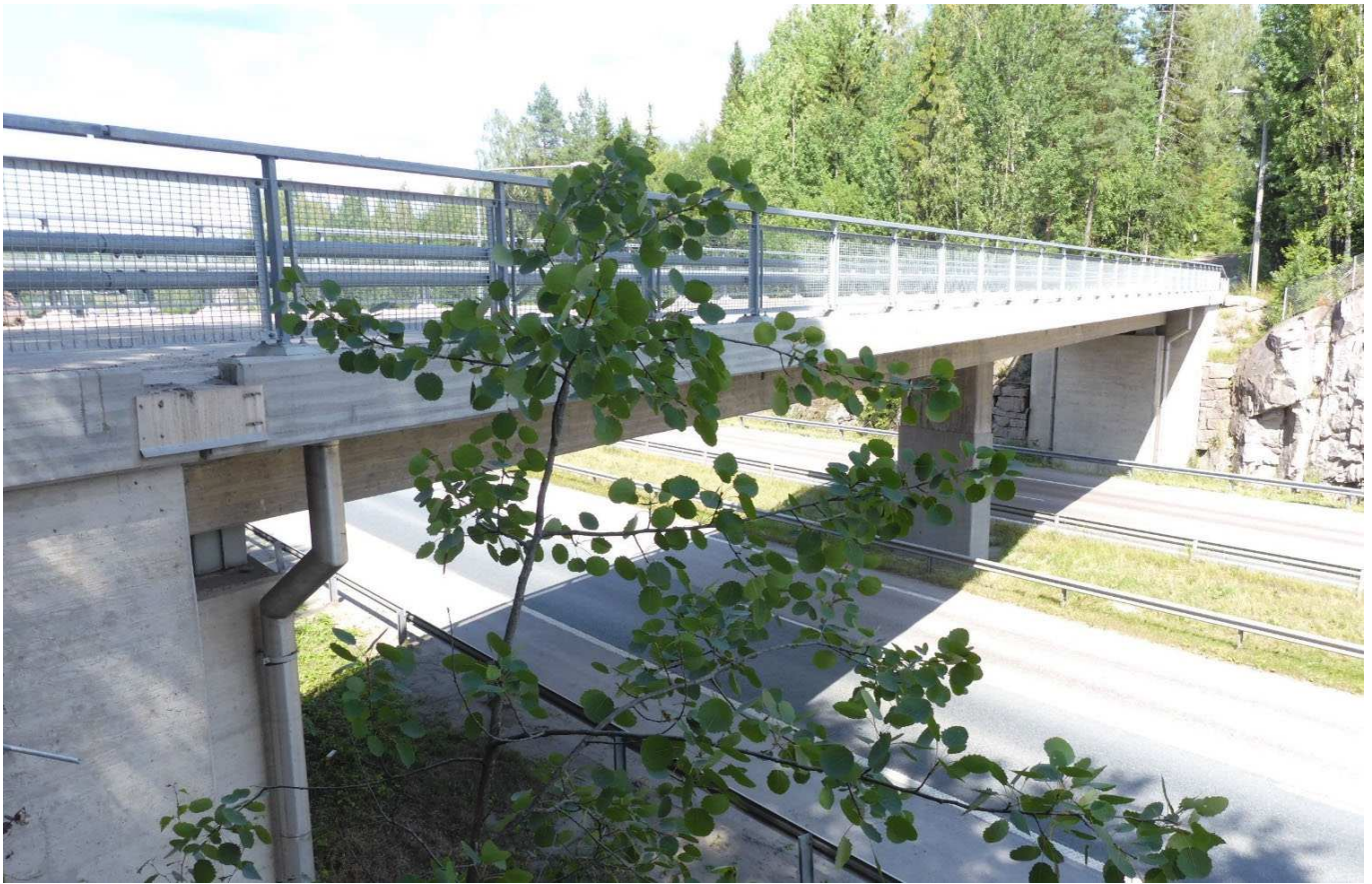
Kuva 29. Jännitetty betoninen jatkuva laattasilta (jBjl). Svartbäckin risteyssilta (U-1562), Espoo.
