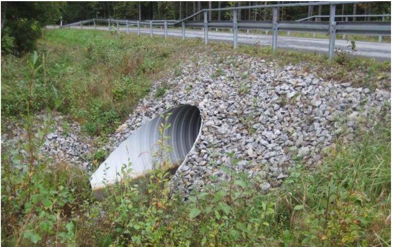
Kuva 46. Teräksinen putkisilta (Tputki). Kiviholman silta (V-5477), Kauhava.
