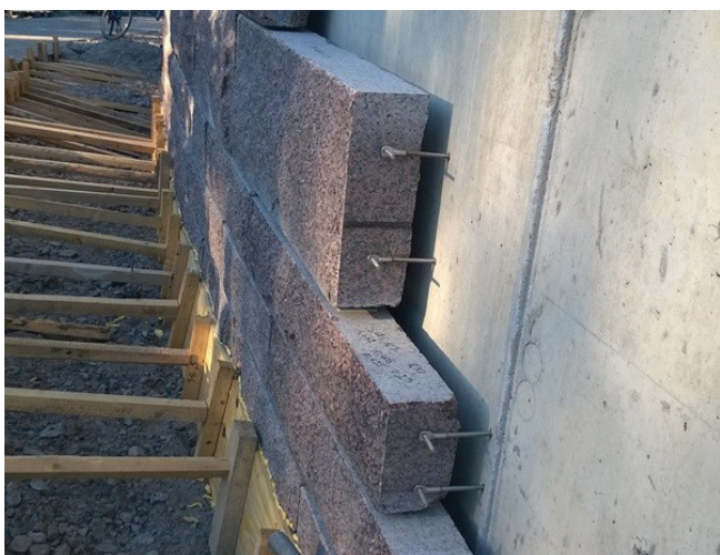
Kuva 9. Kiviverhouksen kiinnittäminen betoniin.
