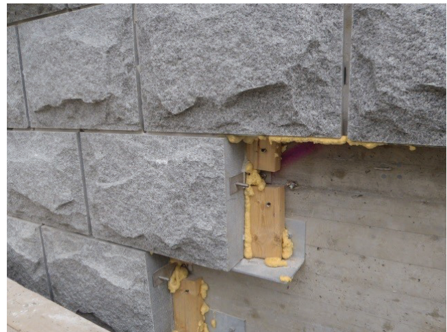
Kuva 10. Kiviverhouksen mekaaninen kiinnitys taustavalulla.
