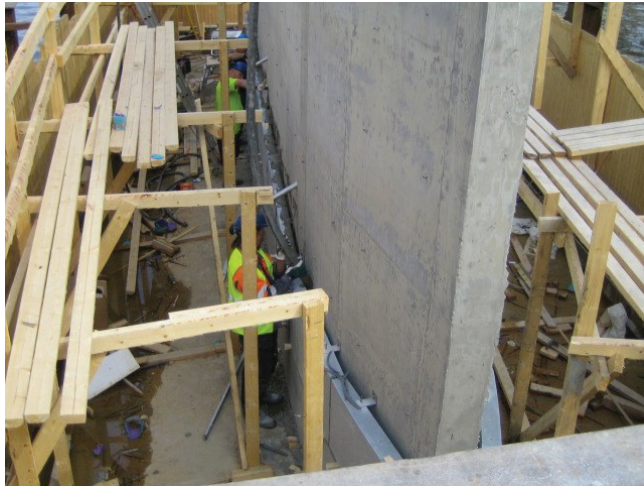
Kuva 11. Kivilaattaverhouksen taustavalun tekoa.
