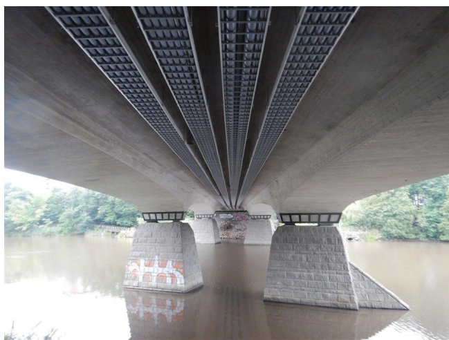
Kuva 2. Välituen kiviverhous.
