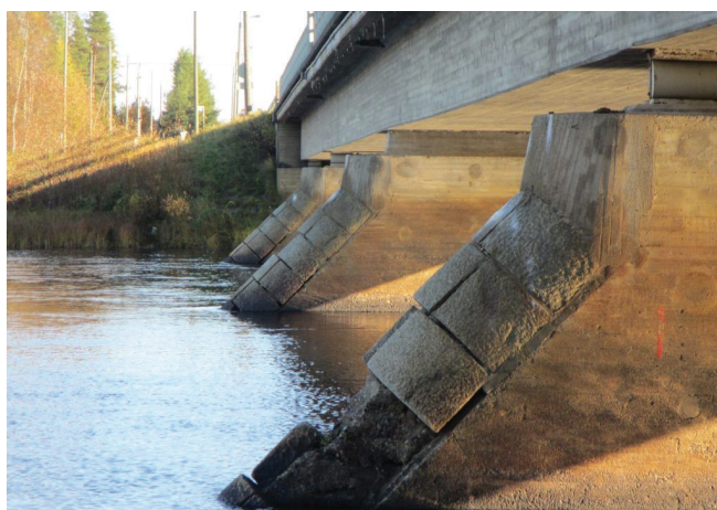
Kuva 1. Välituen vaurioitunut kiviverhous.
