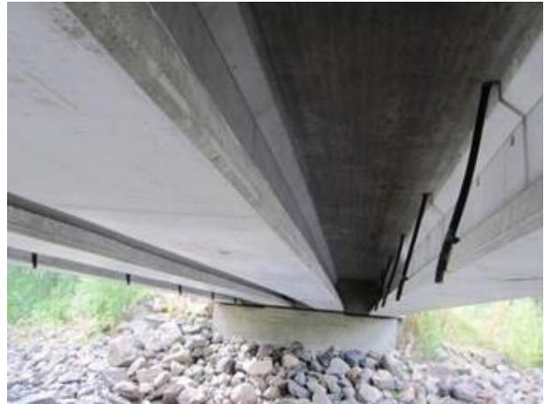
Kuva 8. Tippuputket on jatkettu PE-putkella.
