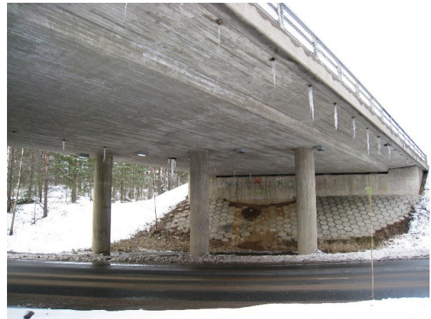
Kuva 4. Tippuputket alittavan väylän päällä.
