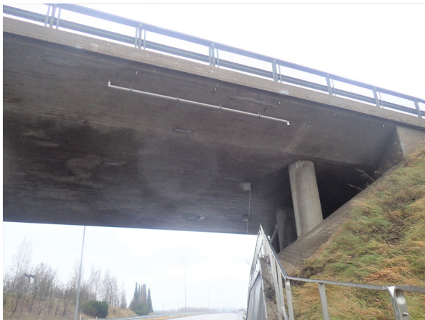
Kuva 7. Kuivatuslaitteen jatkaminen kulkuväylän päältä.
