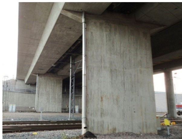
Kuva 16. Jatkettu hulevesiputki.
