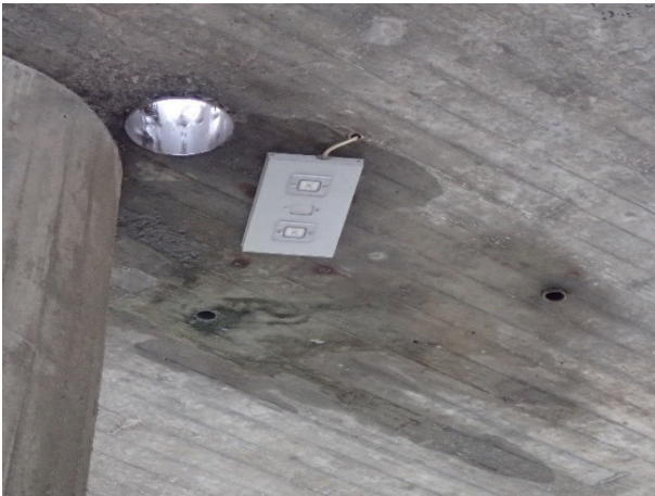
Kuva 1. Vesi leviää liian lyhyen kuivatuslaitteen ympärille.
