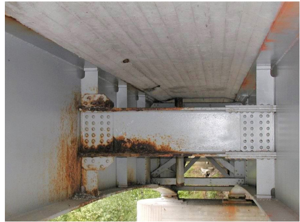
Kuva 2. Kuivatuslaite valuttaa vettä alapuoliselle rakenteelle.
