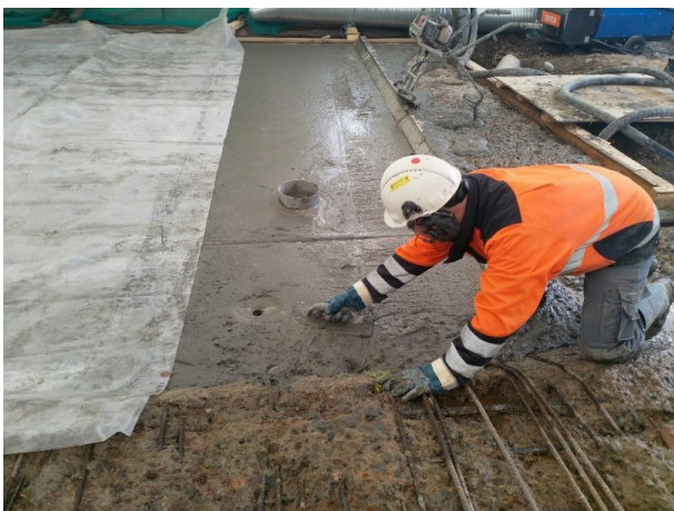
Kuva 6. Kuivatuslaitteiden asennusta muotoilu- valun yhteydessä.
