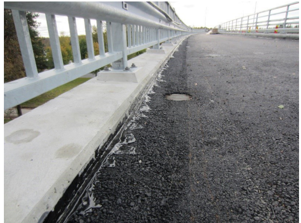
Kuva 11. Hyvin asennettu hulevesiputki.
