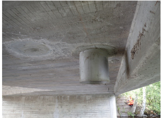
Kuva 10. Uusi hulevesiputki on asennettu ja poistetun putken reikä on paikattu.
