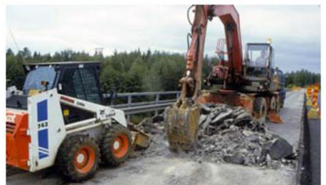
Kuva 6. Pintarakenteita puretaan tasareunaisella kaivinkoneen kauhalla.
