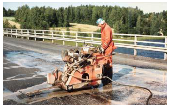
Kuva 12. Päällysteeseen leikataan kutistumissaumat timanttisahalla.
