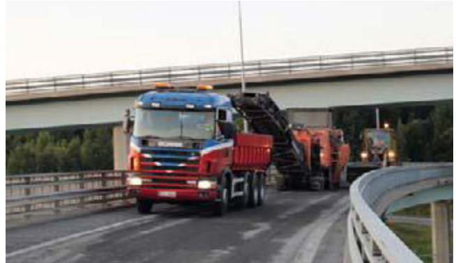
Kuva 4. Tehokas jyrsimyksikkö: kuorma-auto, kuljettimella varustettu jyrsin ja harjakone.
