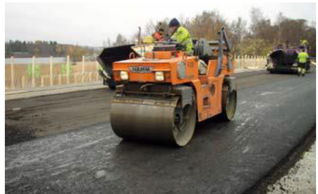
Kuva 8. Asfalttibetoni tiivistetään valssijyrällä.
