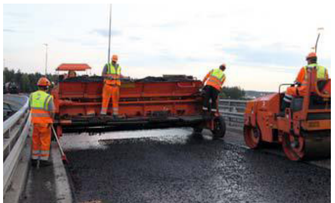
Kuva 10. Valuasfaltin pintaan jyrätään bituminoitu murske.
