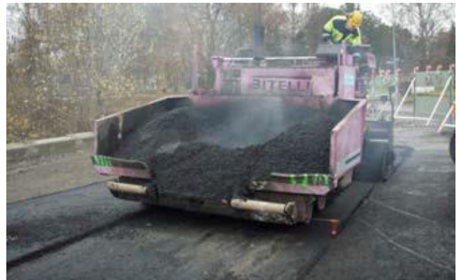
Kuva 7. Asfalttibetonin levitys asfaltinlevittimellä.
