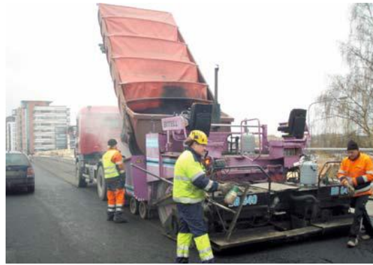
Asfalttimassan siirto levittimeen
