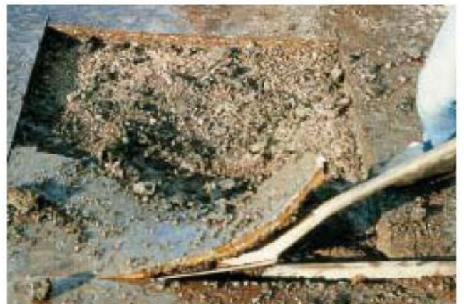
Kuva 6. Vaurioituneen päällysteen purkamista.
