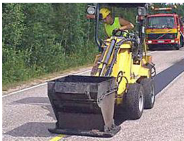
Kuva 10. KT-valuasfalttipaikkauksen levitys ja tiivistys.
