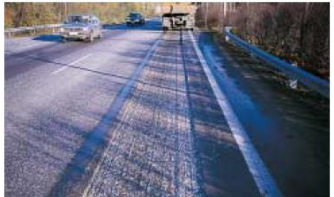
Kuva 4. Päällyste purettu laatikkojyrsimällä.
