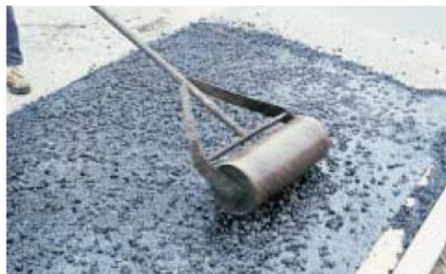
Kuva 11. Karkeutuskiviaines painetaan kevyellä valssijyrällä kuuman valuasfalttipaikan pintaan.
