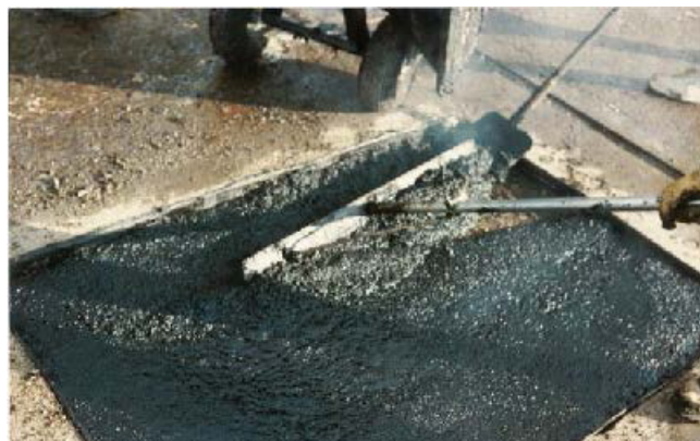
Kuva 7. Asfalttibetonin levitystä käsityönä.
