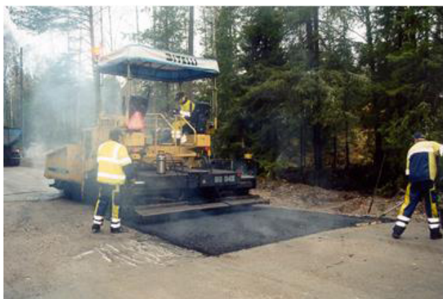
Kuva 9. Asfalttibetonipaikkaus konetyömenetelmällä.
