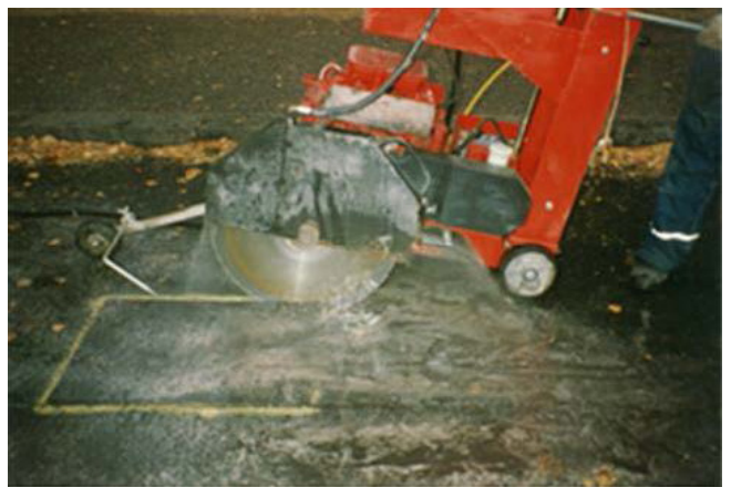
Kuva 5. Pienen paikattavan kohdan rajausta haamalla reunat pystysuoriksi.
