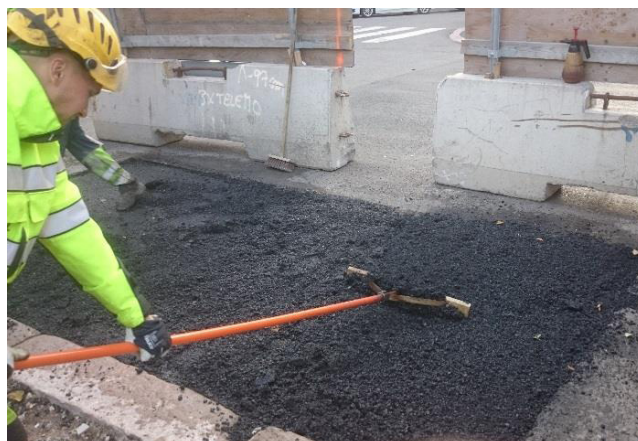
Kuva 12. PAB-paikkausmassan levitys käsityönä kolalla.
