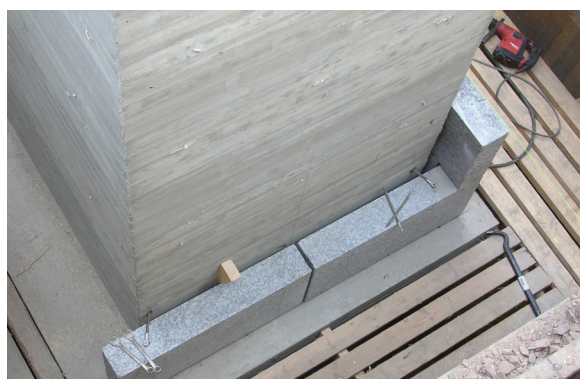
Kuva 2. Välituen kiverhouksen asennus (Äänekosken tehtaat).
