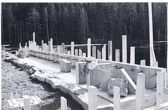
Kuva 1. Sillan reunan verhouskivet asennettuna (Ahtaansalmen silta, Keuruu).
