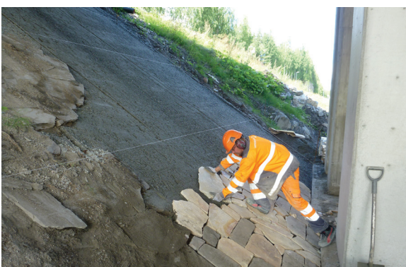
Kuva 3. Etuluiskan kivilaattaverhouksen asennus (Sorsasalon risteyssilta, Kuopio).
