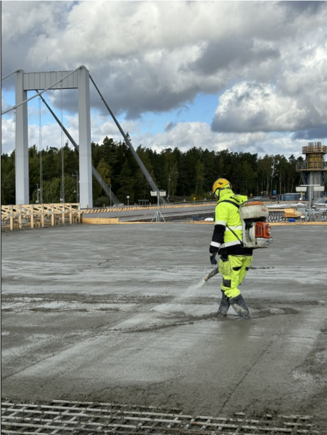
Kuva 1. Varhaisvaiheen jälkihoitoaineen levitys ruiskulla
