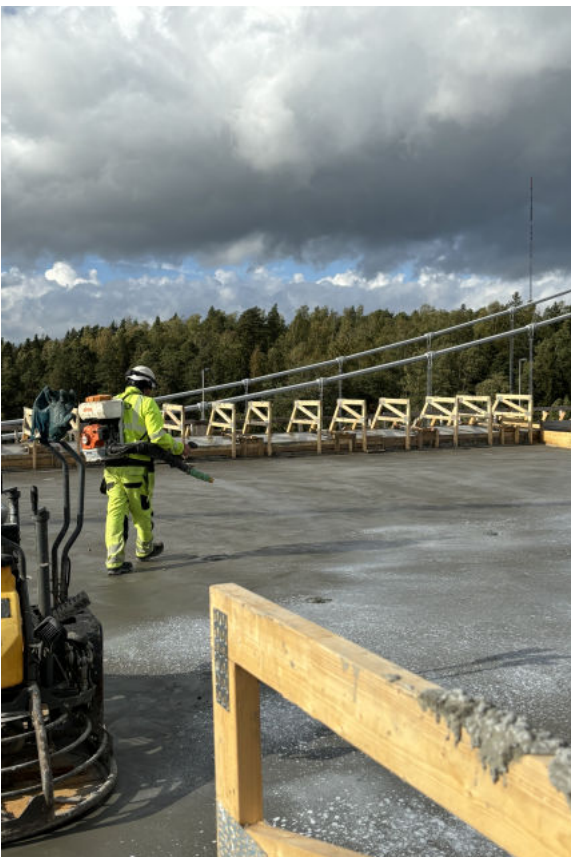
Kuva 2. Jälkihoitoaineen levitys ruiskulla
