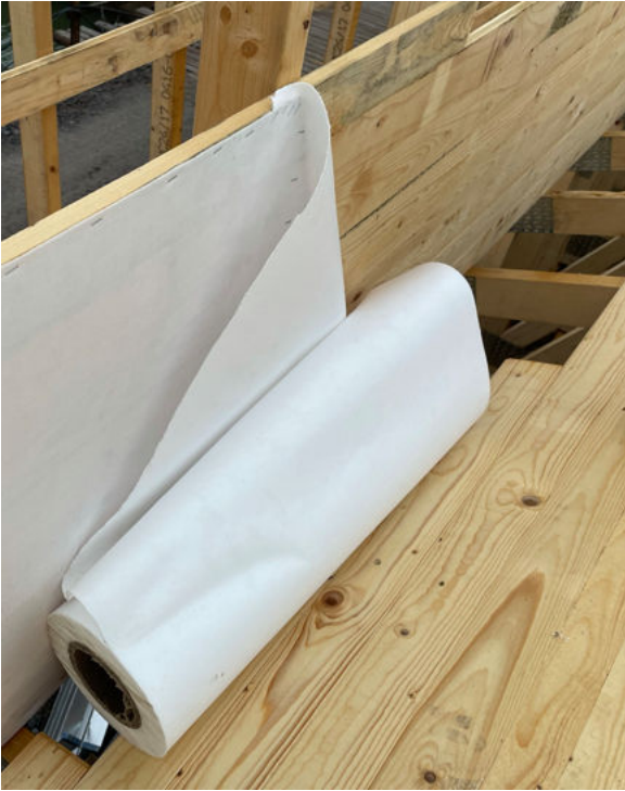
Kuva 1. Muottikankaan asennustyö
