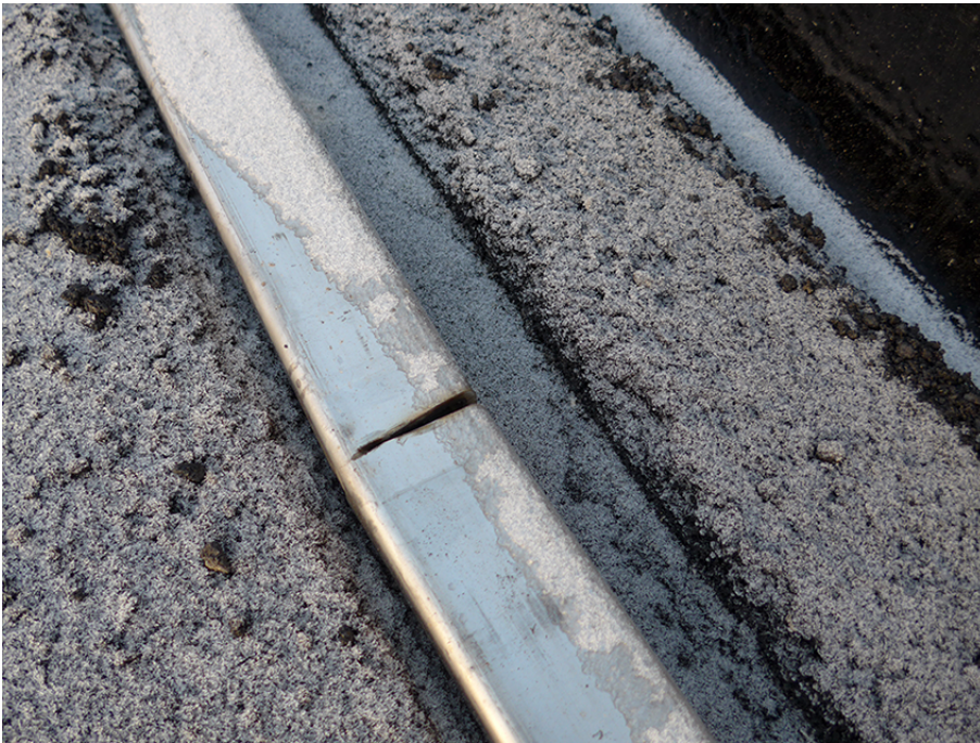
Kuva 4. Salaojaprofiili leikattu sisä- ja pystypinnasta taivuttamista varten
