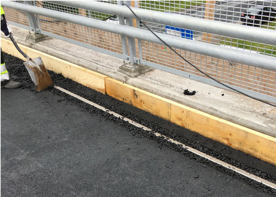
Kuva 6. Pitkittäisen reunasalaojan ympärystäytön asennus (päällysteen korkean sauman muotti asennettuna reunapalkin reunassa)
