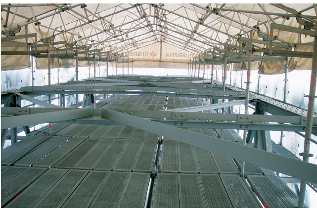
Kuva 16. Työteline teräsristikon maalausta varten
