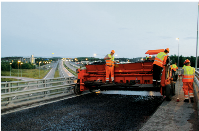
Kuva 30. Päällystystyössä on käytettävä varoitusvaatetusta
