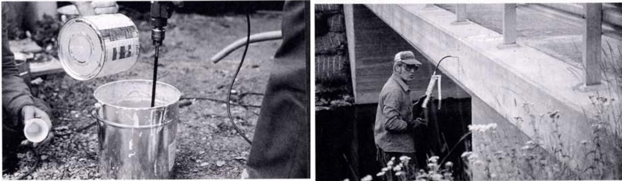
Kuva 9. Epoksimassan kovettuminen astiassa (kuva a) on huomattavasti nopeampaa kuin ohuessa liimasaumassa (kuva b)
