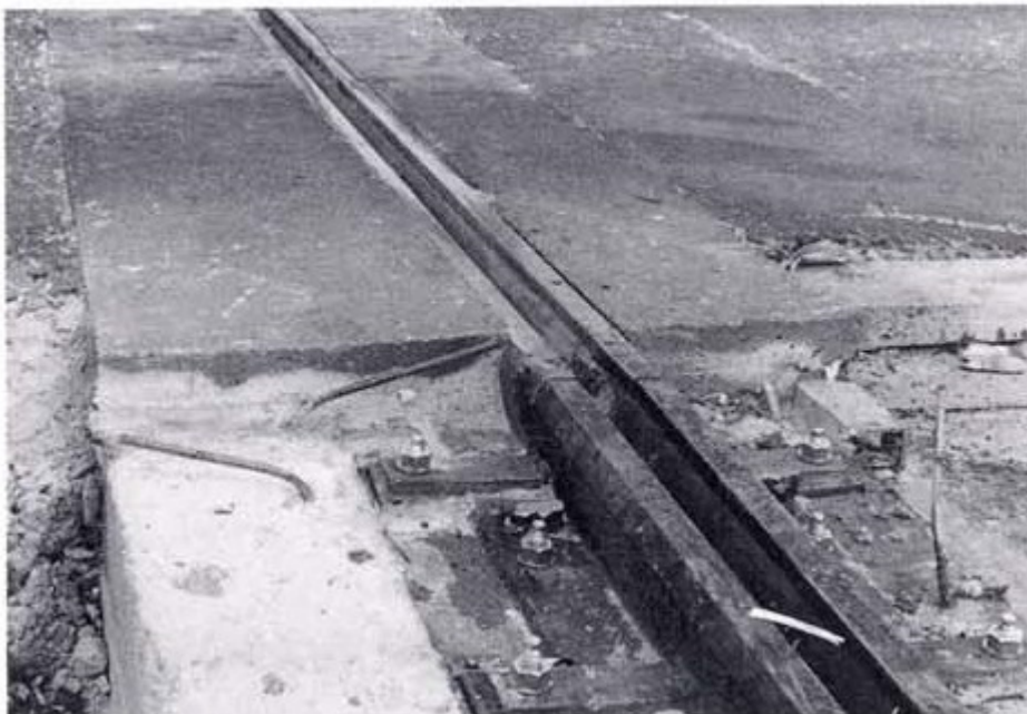
Kuva 10. Liikuntasaumalaitteen tukikaistan yläosa on valettu betonimuovista
