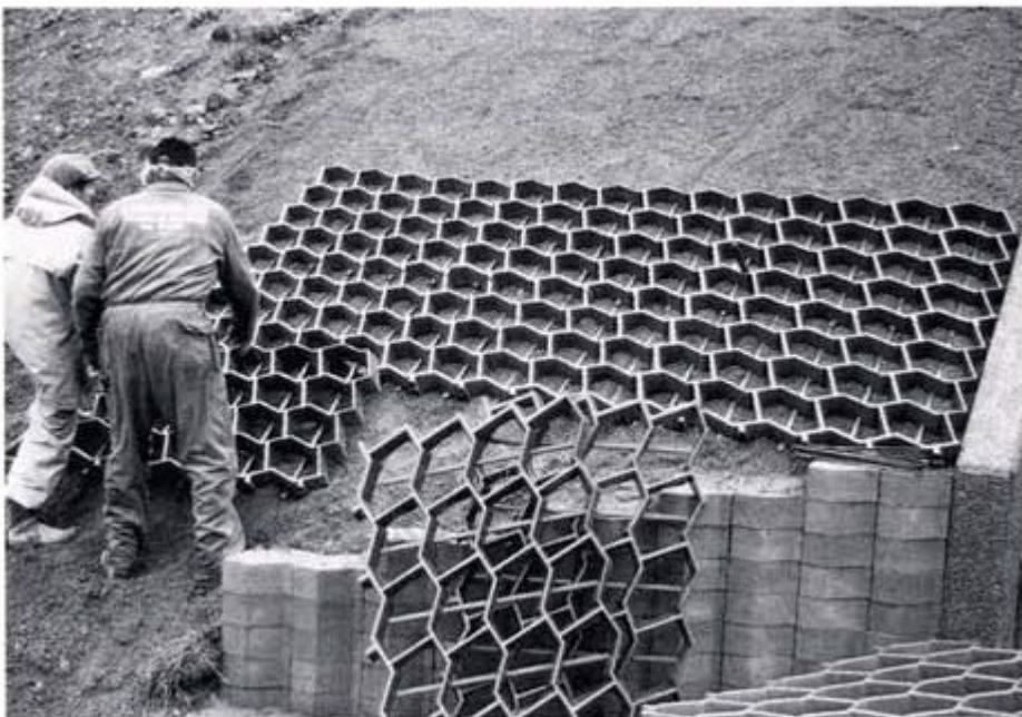
Kuva 29. Luiskakennojen asennusta
