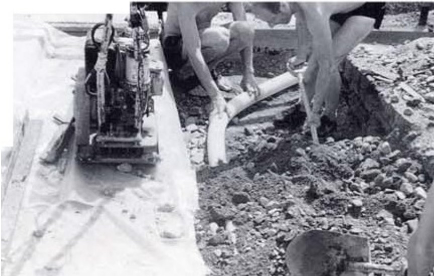
Kuva 28. Salaojaputken asennusta maatuen taustatäyttöön
