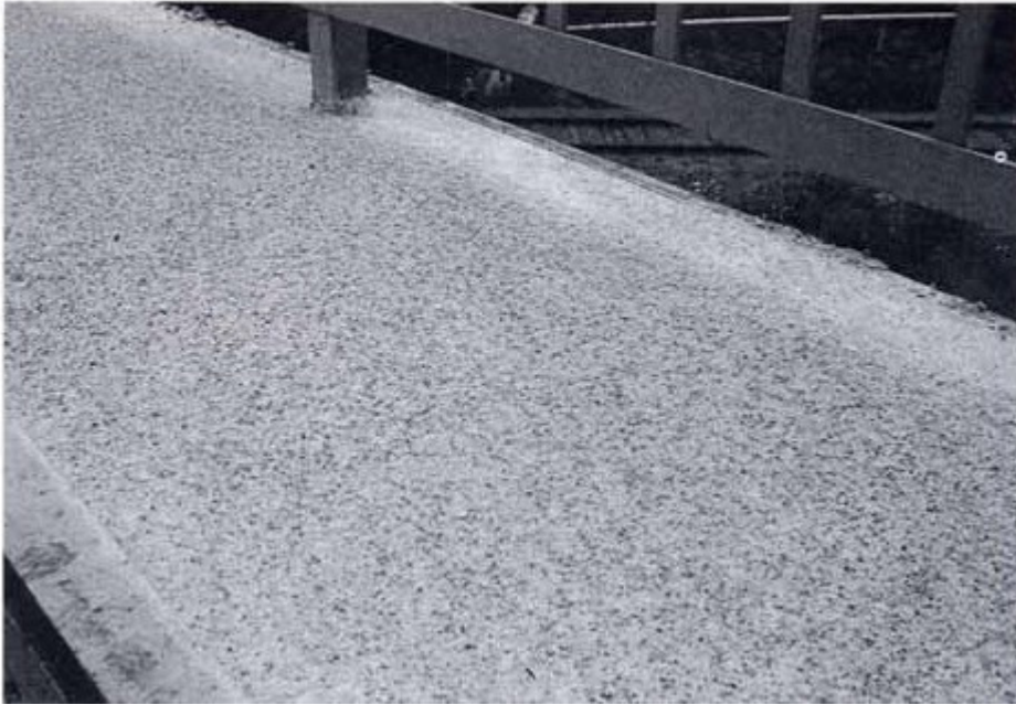
Kuva 14. Ohuiden muotoiluvalujen halkeilu voidaan estää kuiduilla
