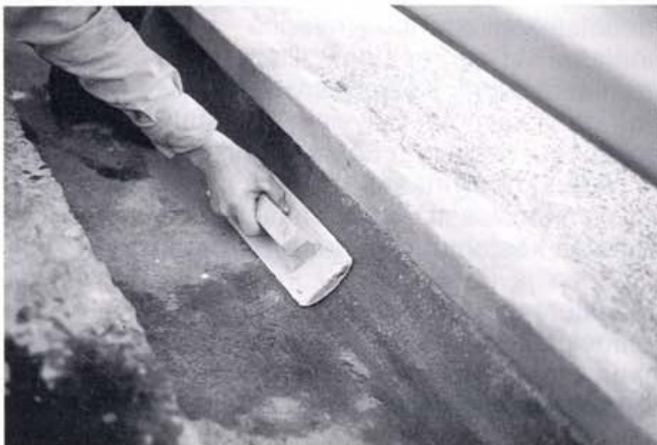
Kuva 12. Paikkauslaastista muotoiltu pulloholkka
