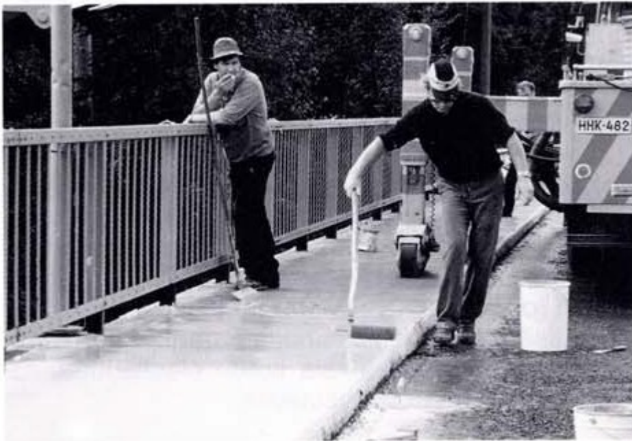
Kuva 21. Epoksipohjaisen ohutkerrospäällysteen levitystä
