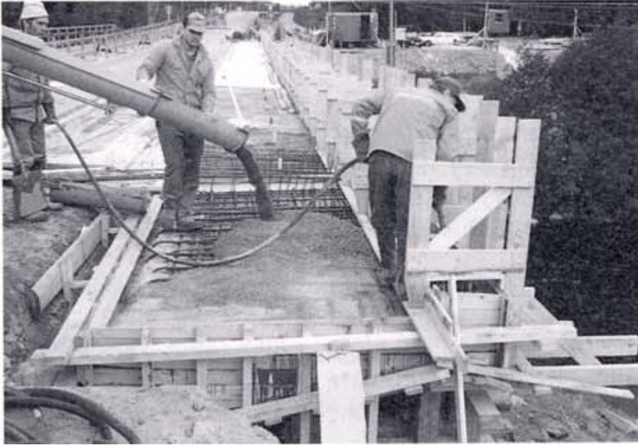
Kuva 15. Tehonotkistettua betonimassaa on helppo työstää
