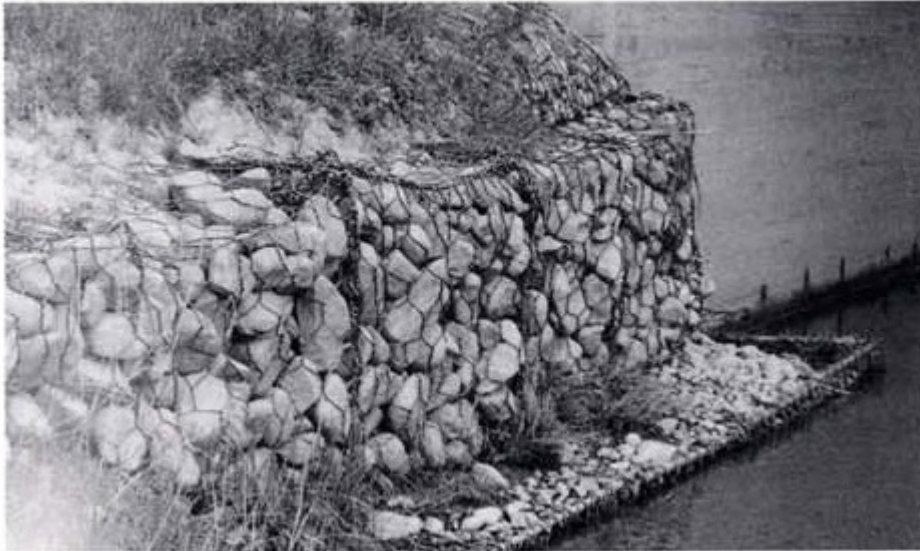
Kuva 30. Muovipinnoitettuja kivitöitä
