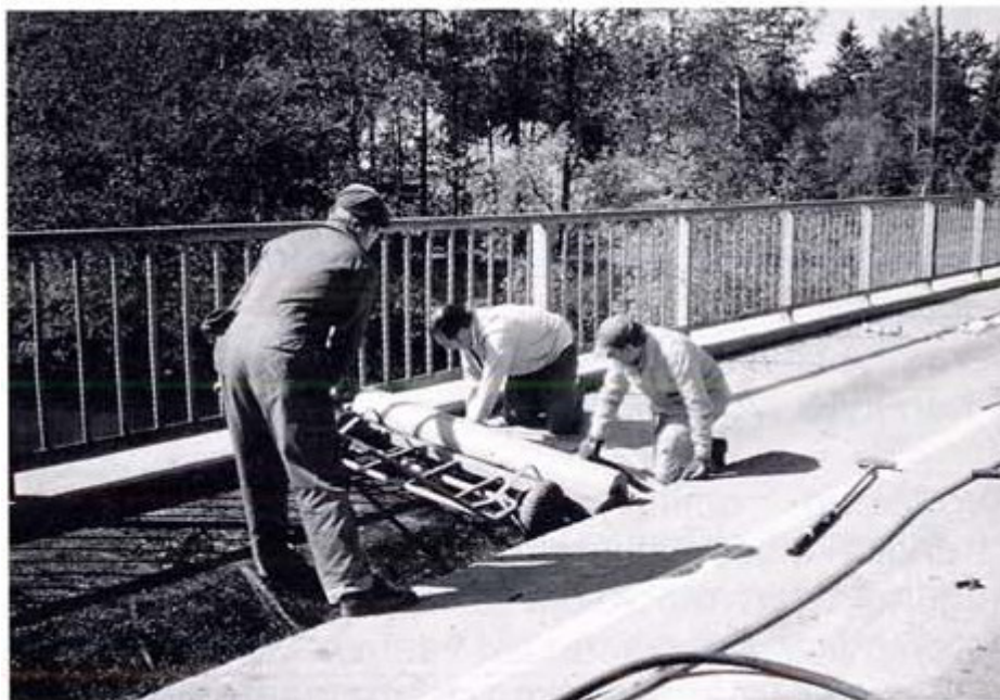
Kuva 19. Esisivelyaineen avulla kiinnitettävän vedeneristyskermin levitystä
