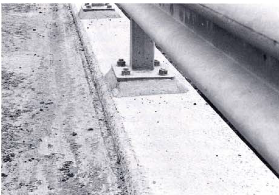
Kuva 13. Kaidepylvään kiinnitysvalu on tehty juotoslaastilla
