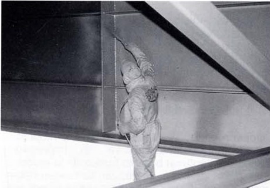
Kuva 18. Maali levitetään yleensä ruiskuttamalla
