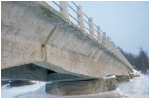
Kuva 5. Savisillan 1930-luvulla tehtyä ruiskubetonia ennen vuonna 1986 tehtyä korjausta
