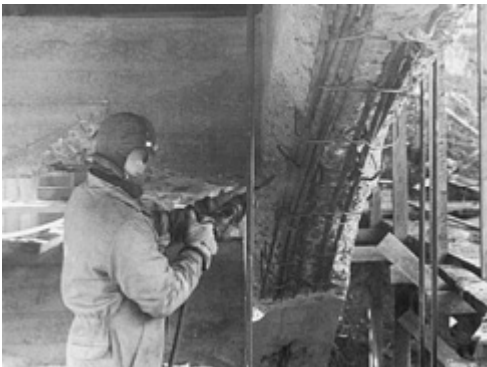
Kuva 26. Ruiskubetonoitavan kaaren piikkausta
