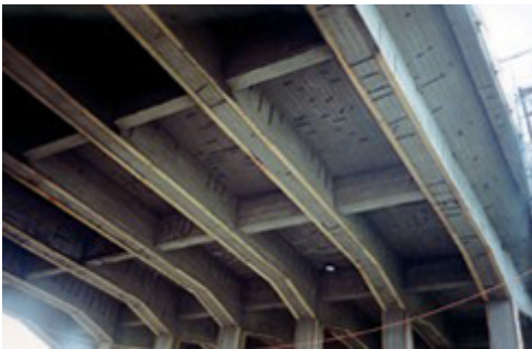
Kuva 30. Palkkien ja pilareiden muodon säilyminen on varmistettu muottien avulla
