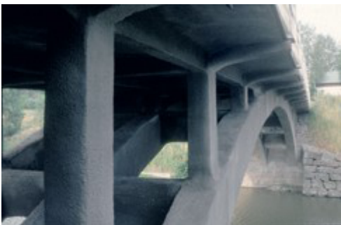
Kuva 6. Suomen vanhin teräsbetonisilta (Tönnön silta, Orimattila) korjattiin ruiskubetonoimalla vuonna 1986
