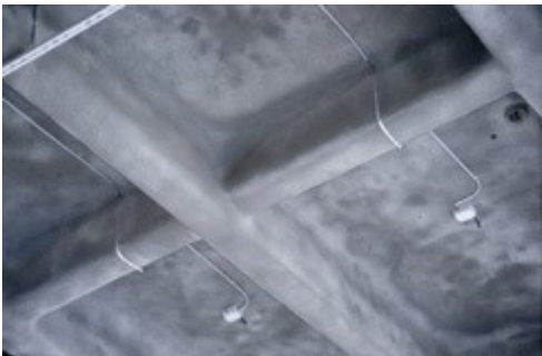
Kuva 8. Katodisen suojauksen anodiverkko on suojattu ruiskubetonilla (Emäkosken silta, Nokia)
