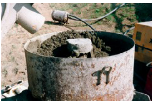
Kuva 29. Ruiskubetonimassan sekoitusta pakkosekoittimella
