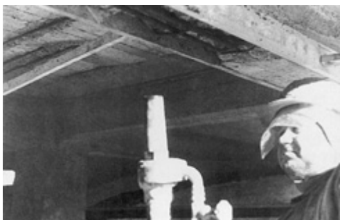
Kuva 13. Betonipeitteen riittävyys on varmistettu muotin avulla
