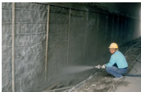
Kuva 2. Betonin ruiskutusta
