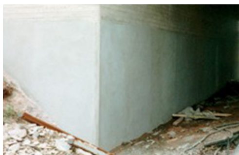
Kuva 3. Valmis ruiskubetonipinta
