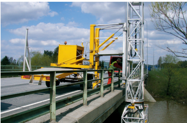
Kuva 18. Tarkastus ja korjausteline
