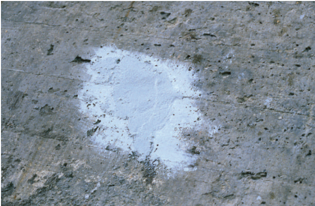
Kuva 27. Rumasti erottuva paikkaus
