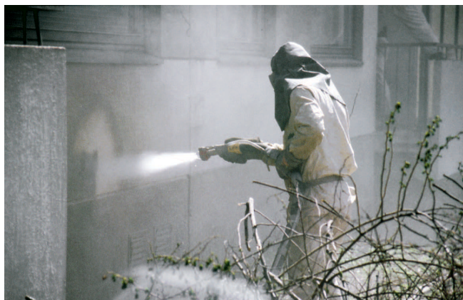
Kuva 22. Suihkupuhdistusta vesihiekkapuhallusmenetelmällä
