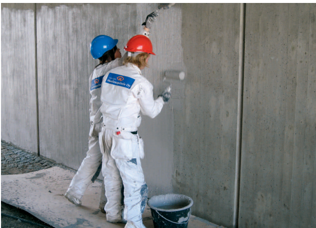
Kuva 23. Pinnoitteen levitystä telaamalla
