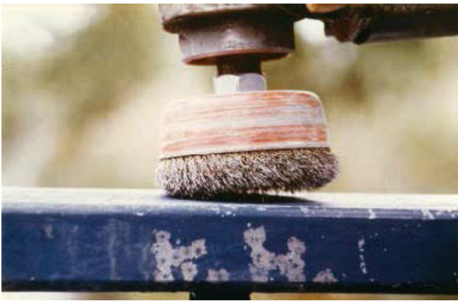
Kuva 39. Teräsharjaus koneellisesti
