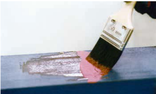
Kuva 47. Paikkausmaalaus tehdään yleensä siveltimellä
