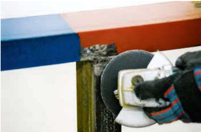
Kuva 41. Vanhan maalin reunan hionta paikkausmaalausta varten
