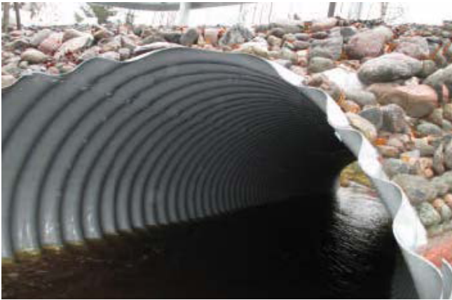
Kuva 3. Kuumasinkitty teräsputki
