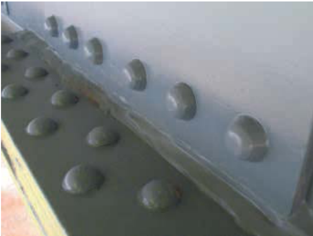
Kuva 46. Niitatuissa rakenteissa on liitososien välissä usein rakoja, jotka tulee kitata umpeen pohjamaalauksen jälkeen
