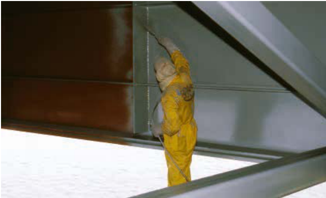
Kuva 49. Uusintamaalaus tehdään yleensä ruiskulla
