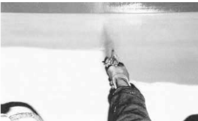
Kuva 52. Suurten pintojen ruiskutus tehdään suoraviivaisesti
