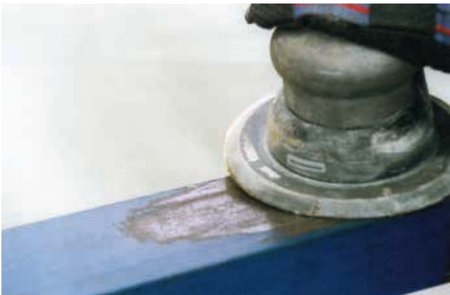
Kuva 40. Puhdistushionta paikkausmaalausta varten
