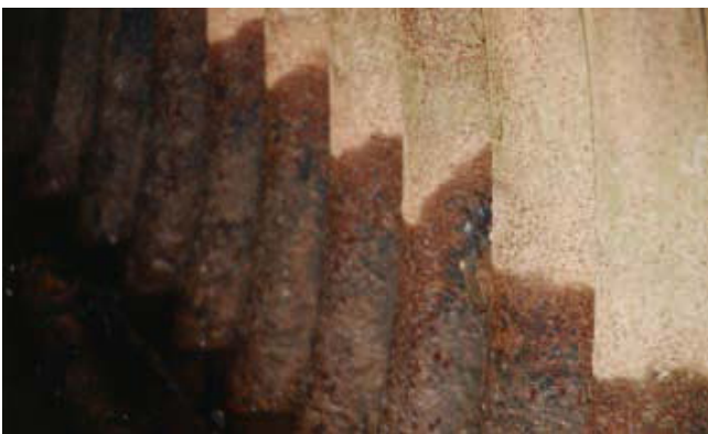
Kuva 11. Vedenpinnan vaikutusalueelta ruostunut teräsputki
