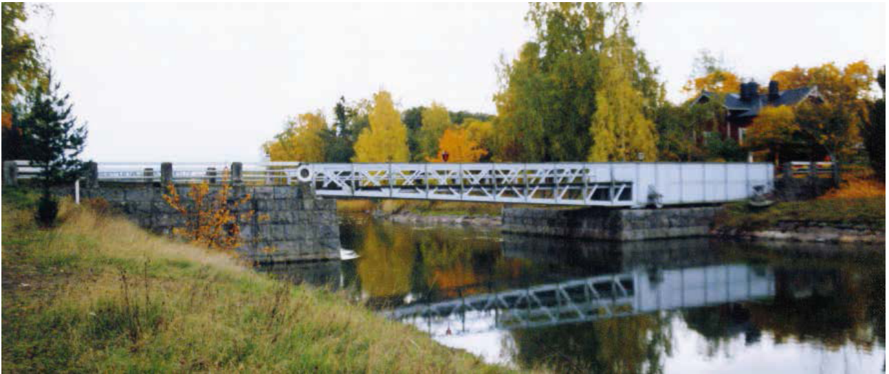
Kuva 2. Strömmankanavan vanha silta on suojattu maalaamalla vuodesta 1897 lähtien
