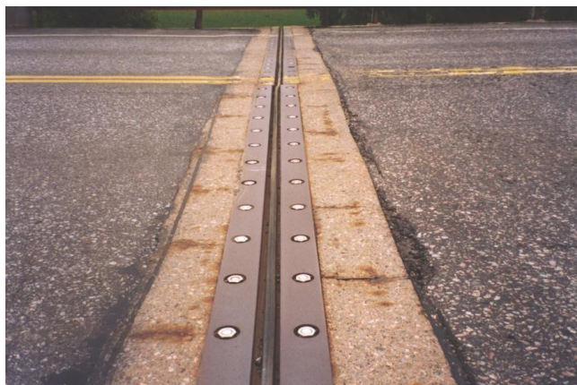
Kuva 27. Ruuvikiinnitteinen yksikuminen liikuntasaumalaite R15 / DC-7
