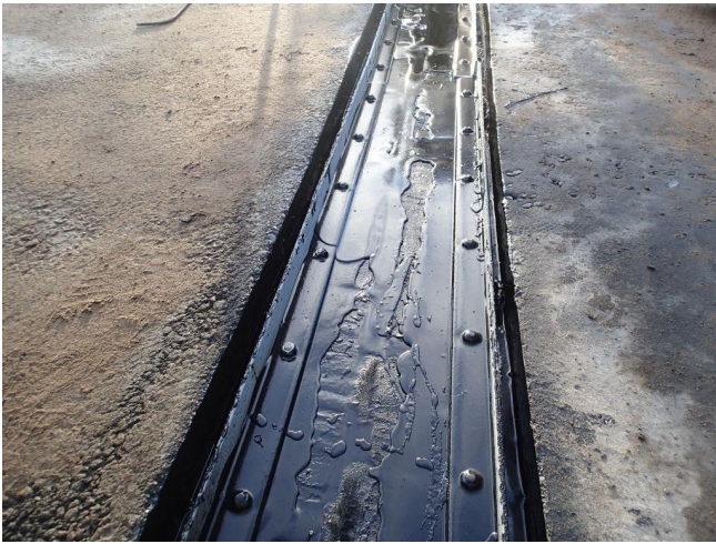
Kuva 16. Teräsoilla vahvistettu polymeeribitumisen massaliikuntasäumalaite tekoprosessin aikaan, jousia ei ole vielä kiinnitetty
