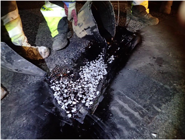
Kuva 30. Massaliikuntasauman aurausvaurion (höyläys) korjaaminen
