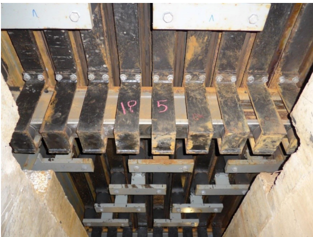
Kuva 11. Monikuminen liikuntasaumalaite kuvattuna alapuolelta, liikuntasaumalaitteen korjaus- ja maalaustyöt ovat kesken
