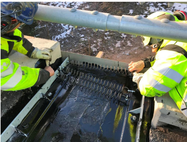
Kuva 17. Jousien asennus polymeeribitumiseen massaliikuntasäumaan
