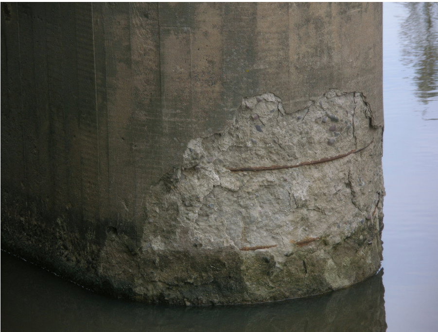
Kuva 2. Laajaa rapautumaa alusrakenteessa, paikkaus muottien avulla
