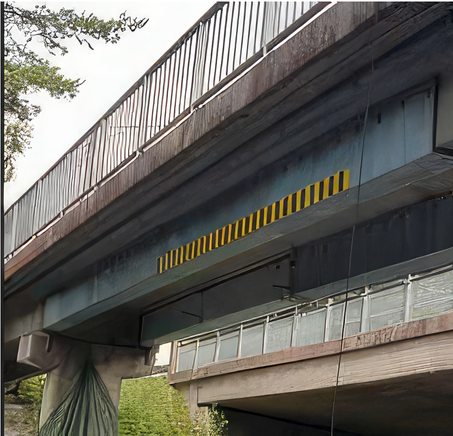
Kuva 17. Teräksinen kolhaisusuoja, jota voidaan käyttää myös muottina
