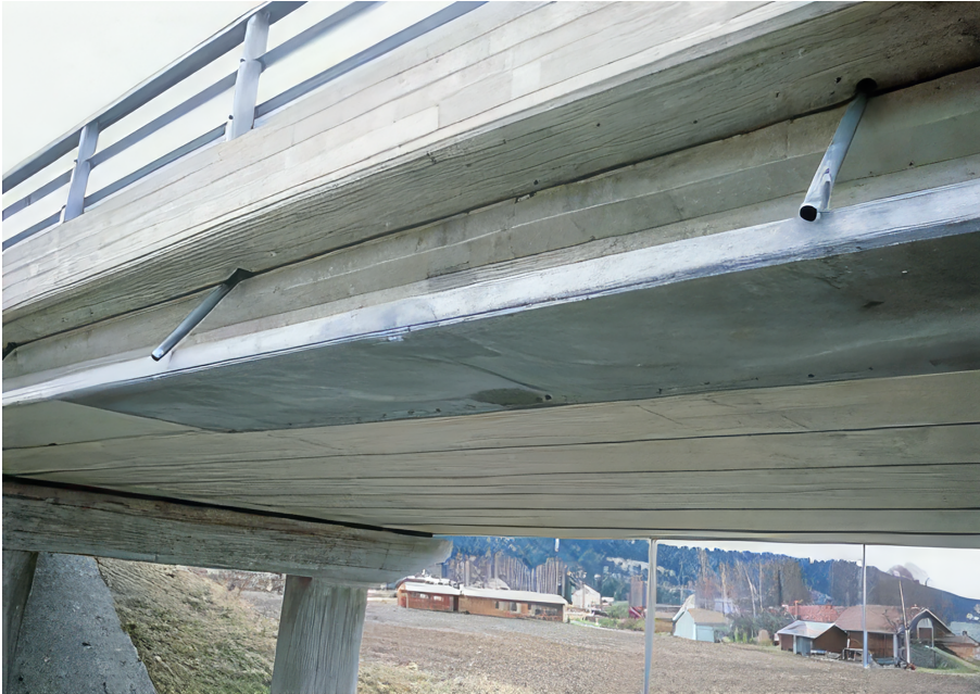
Kuva 16. Törmäysvaurion korjauksessa käytetty teräsmuotti on jätetty paikalleen
