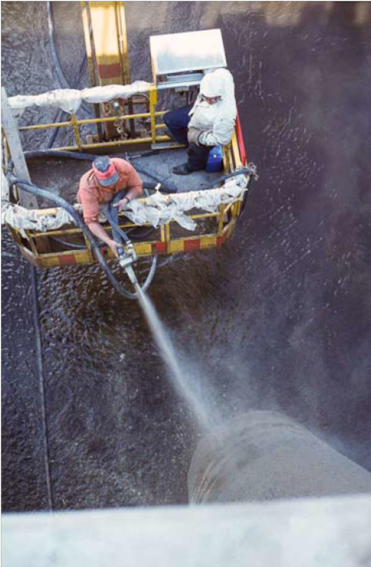
Kuva 4. Pilarin ruiskubetonointia siltakurjen korista käsin
