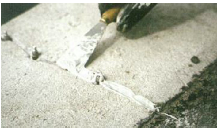
Kuva 6. Sulkuaine levitetään lastalla
