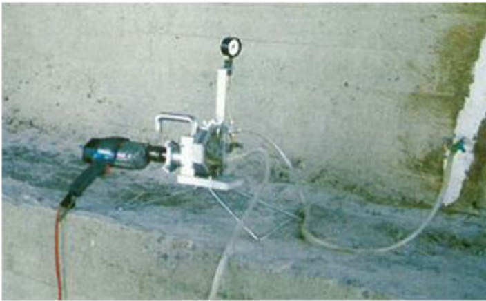
Kuva 3. Injektointilaitte ja suutinpainemittari
