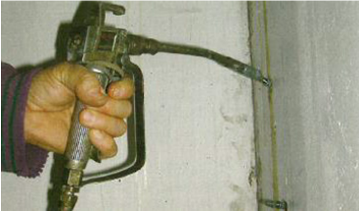
Kuva 7. Mansetilla kiinnitettäviä injektointitulppia
