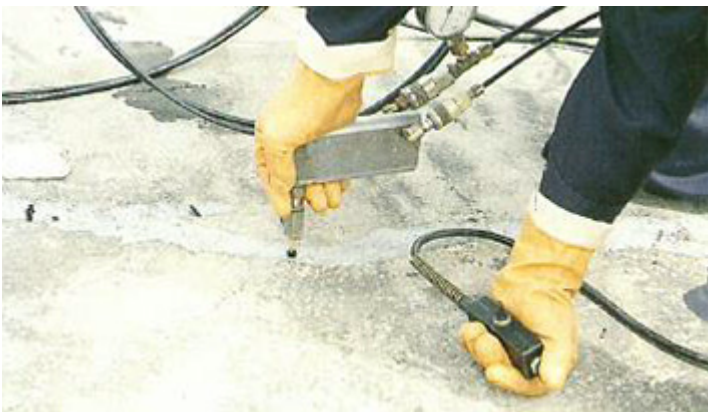
Kuva 4. Injektointilaitte, jossa komponentit sekoittuvat vasta suuttimessa
