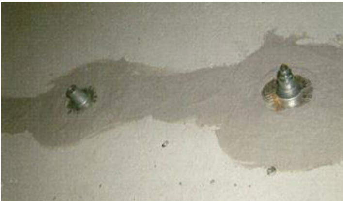
Kuva 8. Aluslevyjä ja toiseen kiinnitetty injektointinippa
