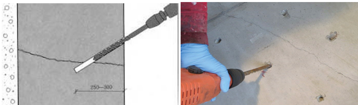
Kuva 10. Reiät porataan siten, että ne leikkaavat halkeaman
