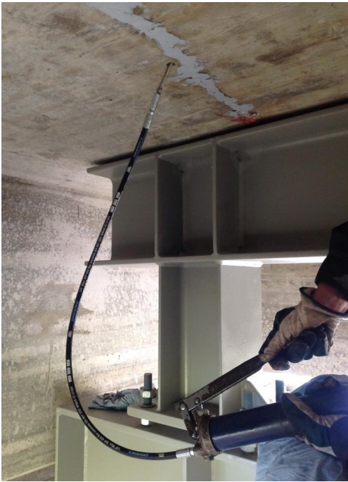
Kuva 2. Injektointityö käynnissä
