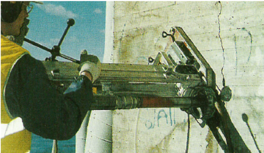
Kuva 5. Injektointityön tulos tarkistetaan rakenteesta porattavasta näytteestä
