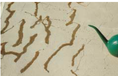
Kuva 4. Imeytysaine on kaadettu halkeaman päälle (vaihe 1)
