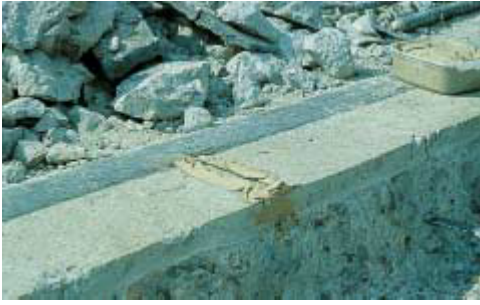
Kuva 11. Halkeaman kohdalle tehdään kaukalo
