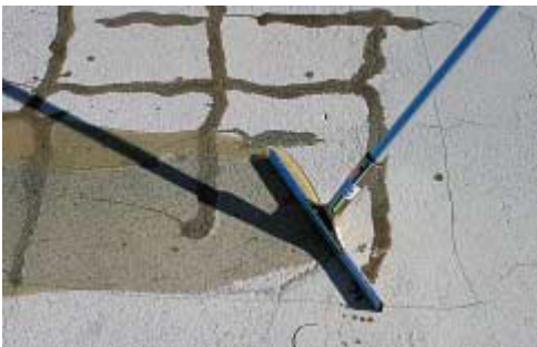
Kuva 6. Eristysalustan epoksitiivistyksen yhteydessä tehtävä imeytys tehdään joko pelkästään lastalla levittämällä tai lastalla halkeamien esikäsitteilyn (vaiheet 1 ja 2) jälkeen (vaihe 3)
