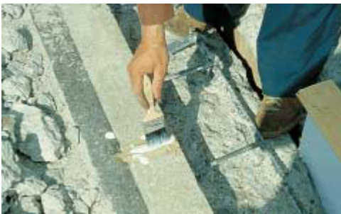
Kuva 12. Imeytysaine pidetään liikkeessä siveltimen avulla
