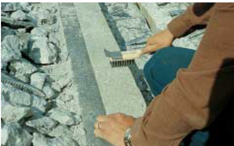
Kuva 10. Halkeaman pinta puhdistetaan
