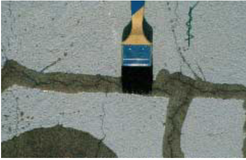
Kuva 5. Imeytysaine pidetään liikkeessä siveltimellä (vaihe 2)
