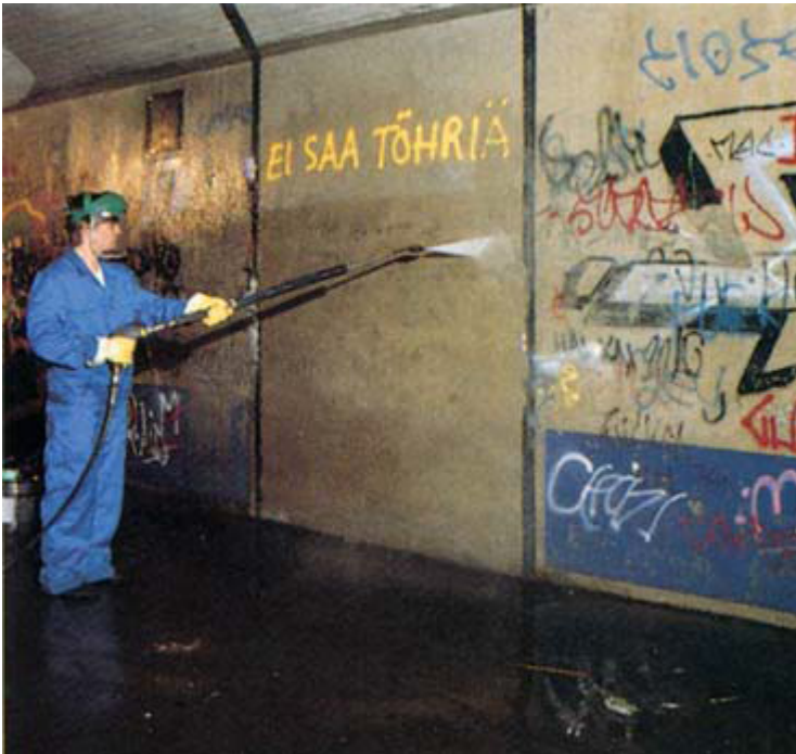
Kuva 2. Töherrysten poiston kiireellisyys riippuu siltapaikkaluokasta
