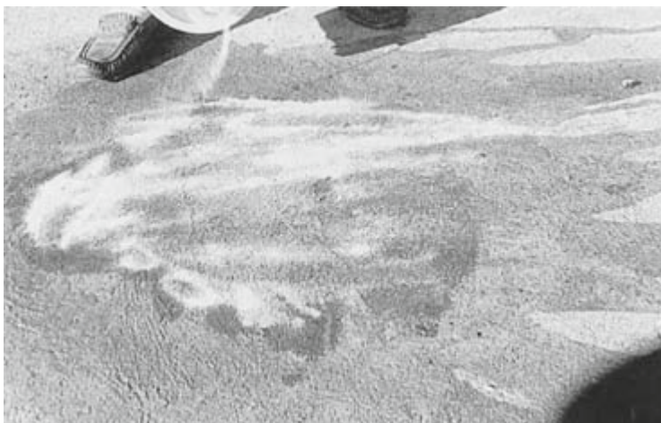
Kuva 5. Öljynpoistoaine levitetään märälle pinnalle
