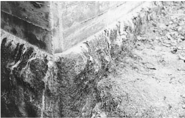
Kuva 9. Sementtiliimaa on valunut kivipinnoille
