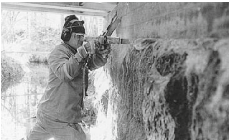
Kuva 10. Kivipintaa puhdistetaan neulahakkurilla
