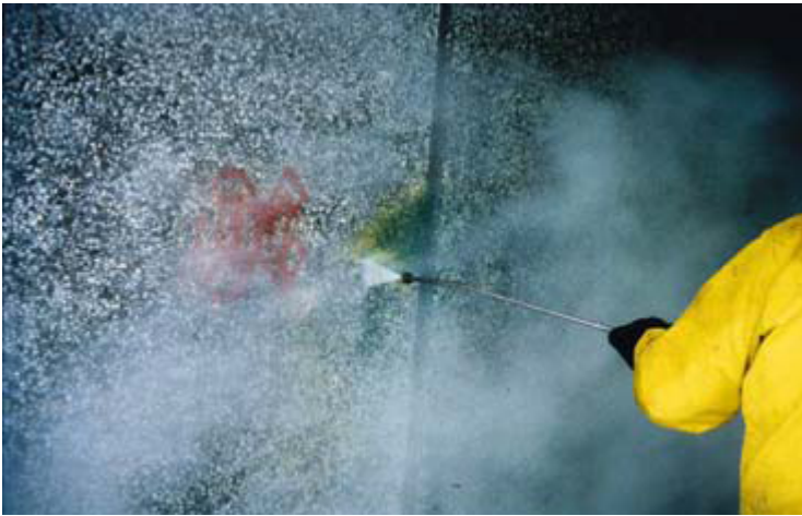
Kuva 14. Pinnan pesu suurpainepesurilla on päättymässä
