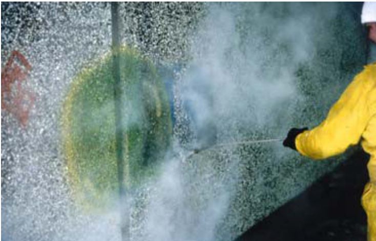
Kuva 13. Pinnan pesu suurpainepesurilla on alkamassa
