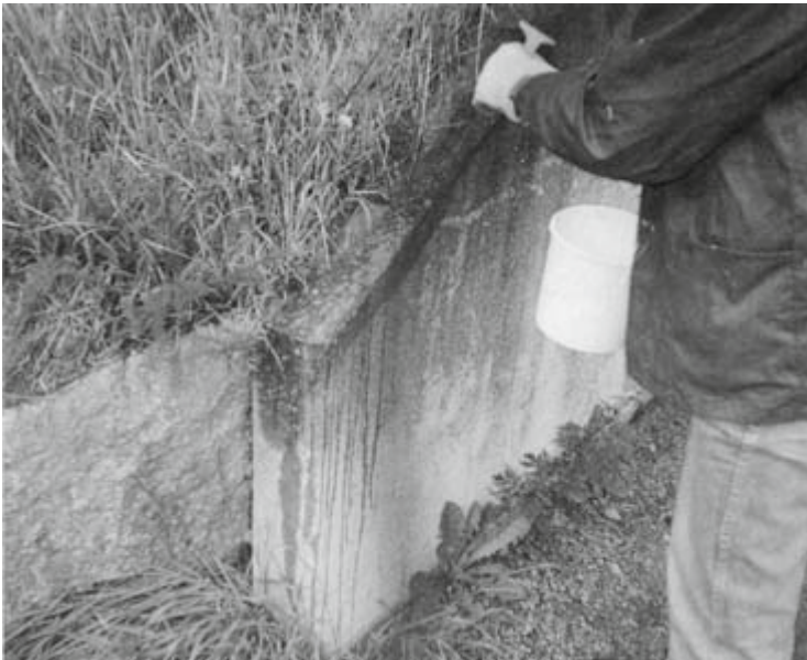
Kuva 16. Kasvinpoistoliuosta levitetään siipimuurin pinnalle
