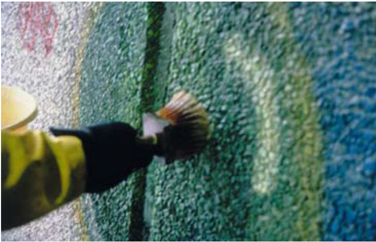
Kuva 12. Maalinpoistoaine levitetään siveltimellä
