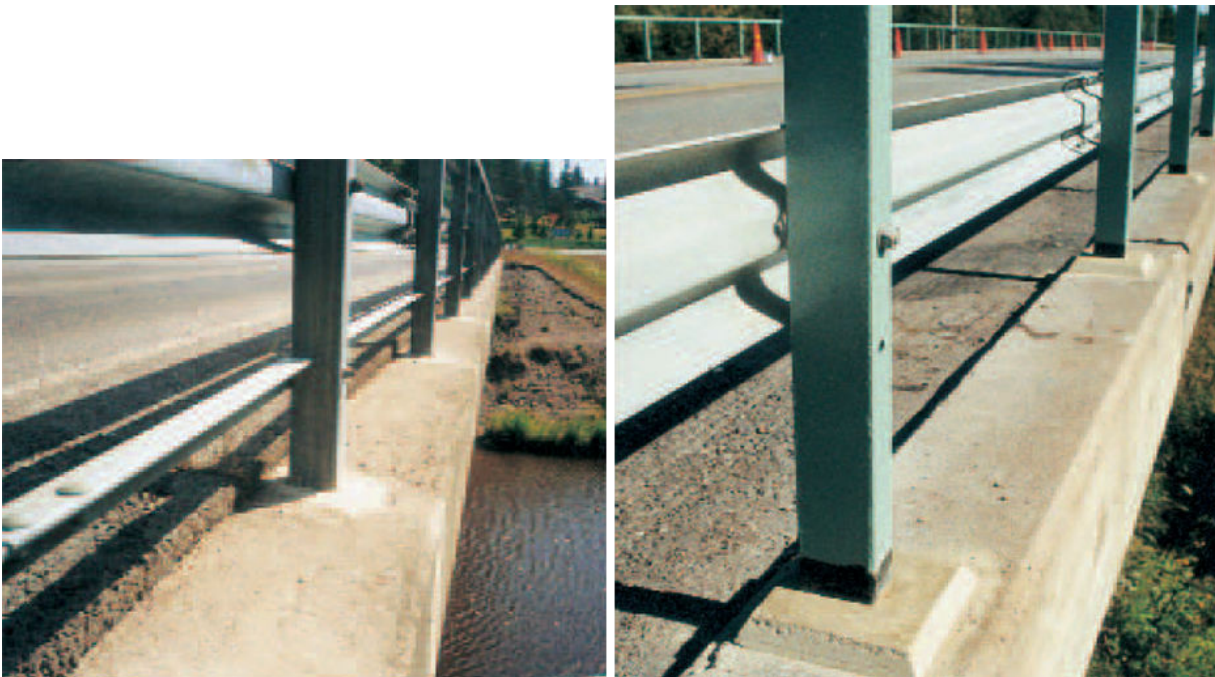
Kuva 3. Esimerkkejä eri tavoin tehdyistä kaidepylvään juuren korjauksista tyypillisine ulkonäkövirheineen
