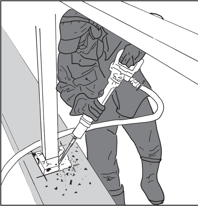
Kuva 5. Juurikoroke piikataan pois
