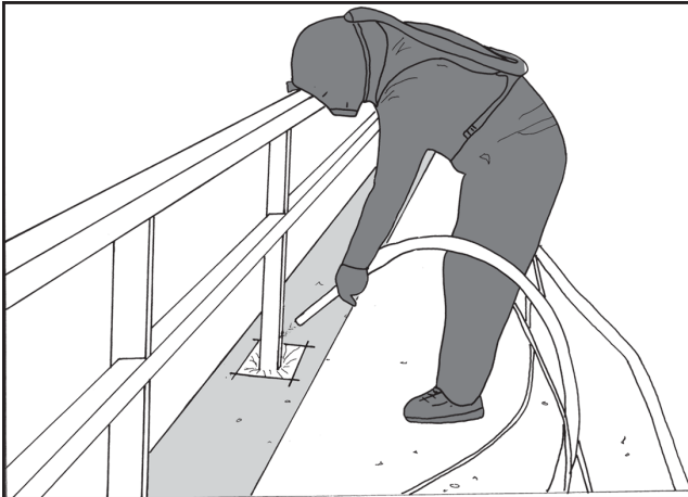
Kuva 9. Pinnanpuhdistus tehdään suihkupuhdistamalla.
