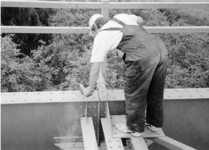
Kuva 9. Maalattavan pinnan on oltava puhdas
