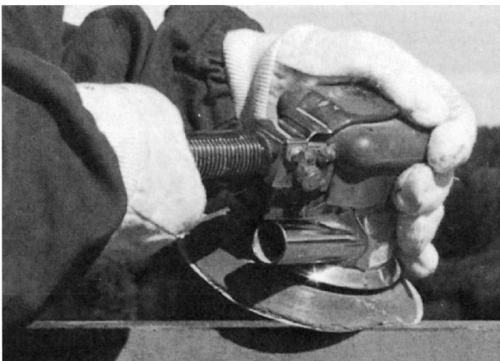
Kuva 8. Paikalleen jäävän maalin reuna on hiottava
