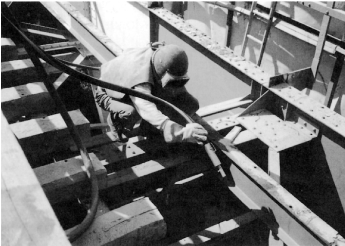
Kuva 7. Teräspalkkien suihkupuhdistusta
