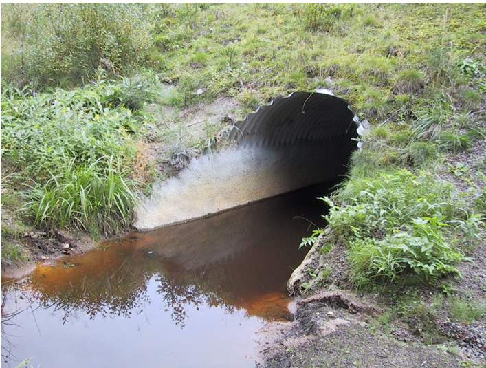
Kuva 5. Ruiskubetonoinnilla suojattu teräsputkisilta
