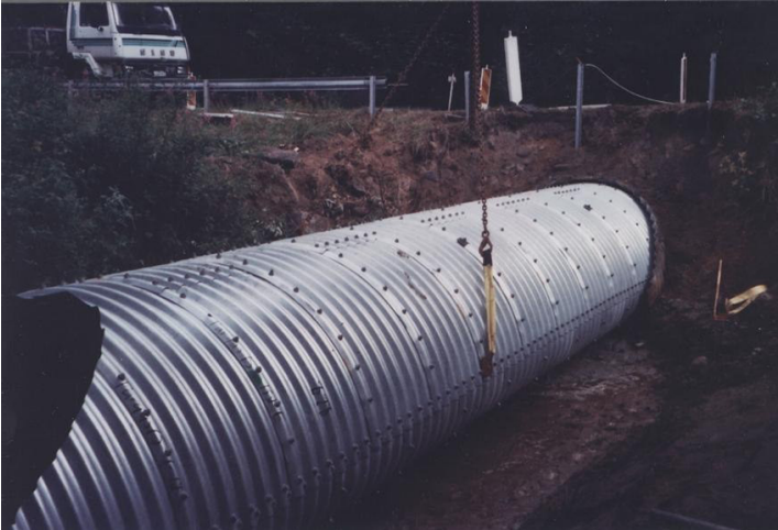
Kuva 3. Uusi teräsputki sujutetaan vanhan putken sisään
