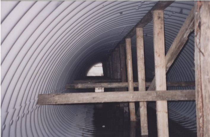
Kuva 7. Sujutusputki on tuettava betonoinnin ajaksi
