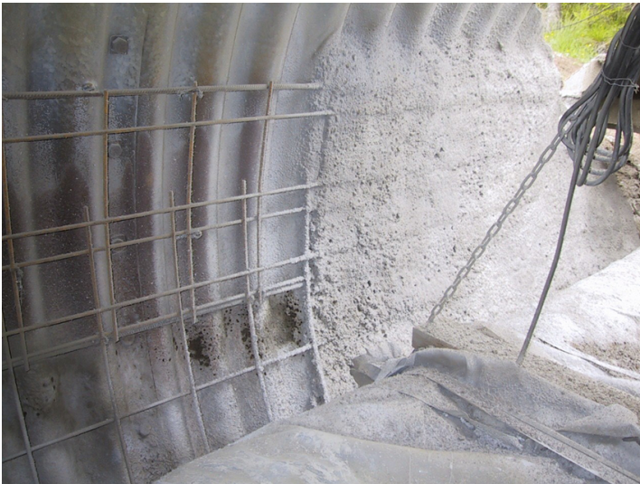
Kuva 9. Raudoitusverkko on kiinnitetty ja ruiskubetonointi aloitettu
