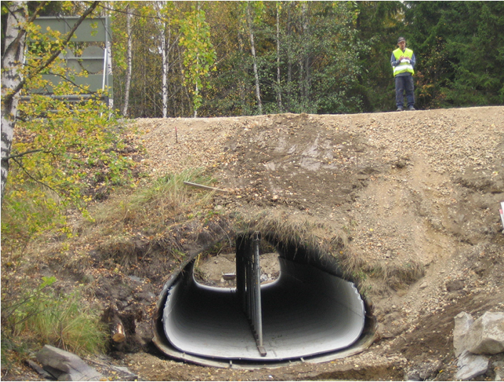
Kuva 4. Uudet teräslevyt kiinnitetään yläosastaan vanhan putken reunoihin
