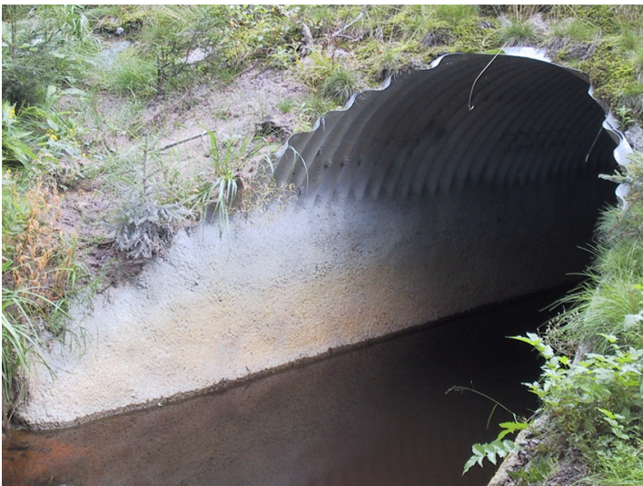
Kuva 10. Teräsputken valmis ruiskubetonointisuojaus
