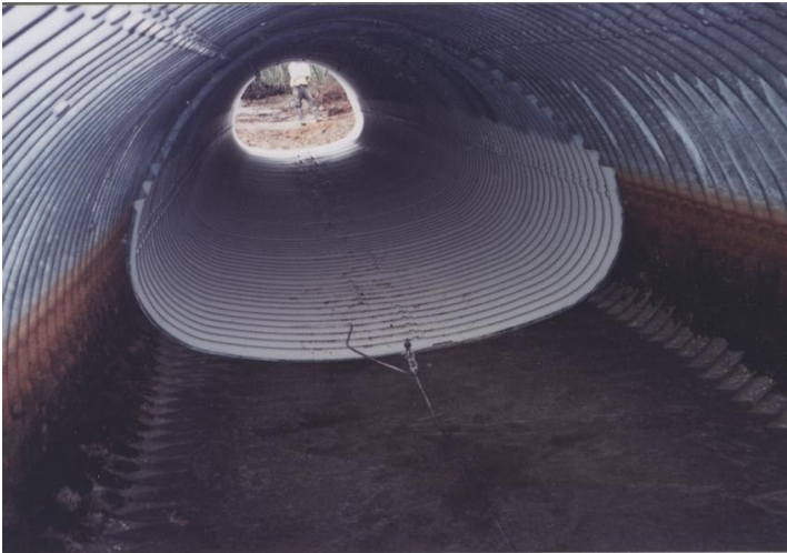
Kuva 6. Uusi teräsputki sujutetaan vanhan putken sisään vetämällä
