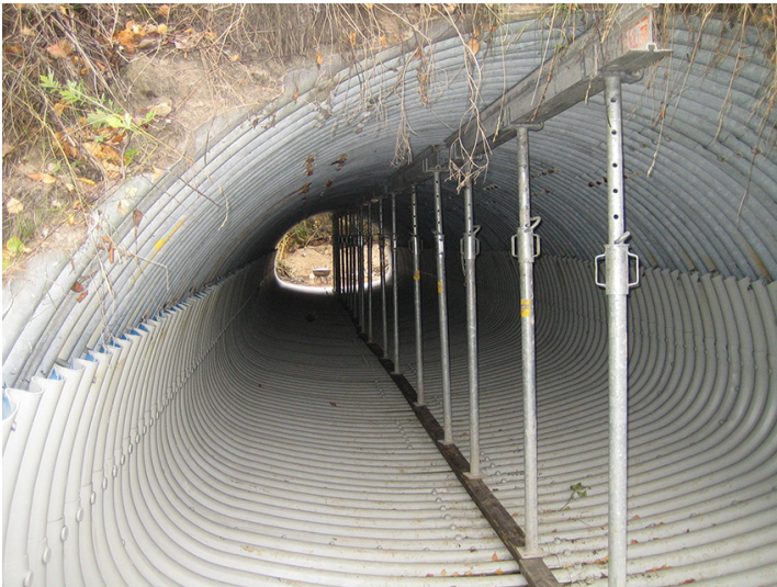
Kuva 8. Korjausosan tuenta valupainetta vastaan
