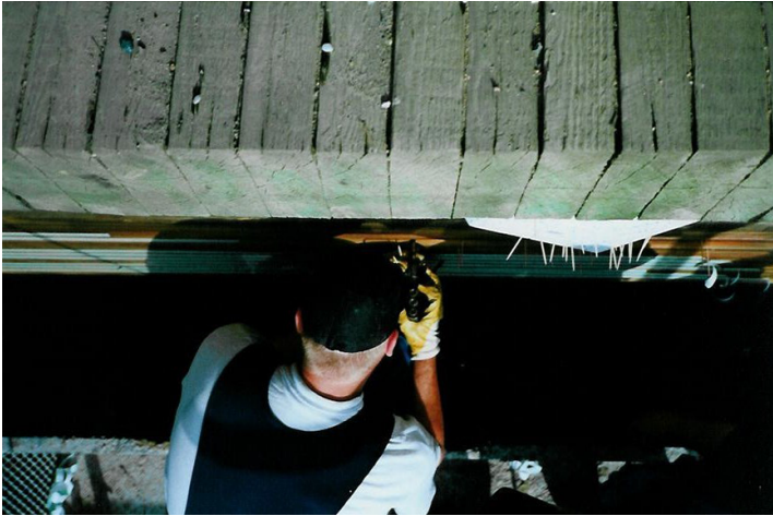
Kuva 4. Injektointia erikoissuutinta käyttäen
