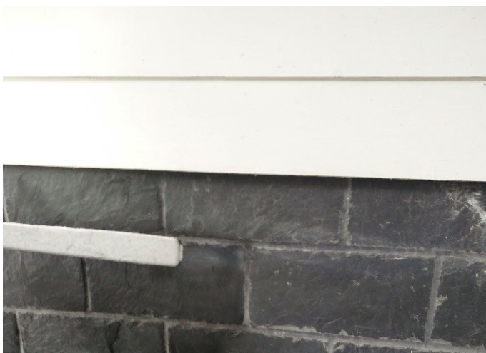
Kuva 2. Kivipinnan puhdistusta kuivajääpuhalluksella
