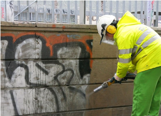
Kuva 3. Töherrysten poisto soodapuhalluksella
