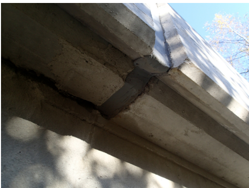
Kuva 10. Virheellisesti alapuoleltakin saumattu reunapalkki
