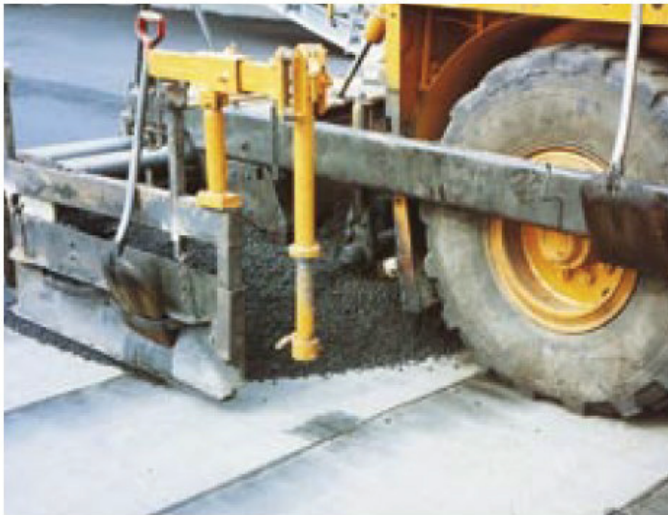
Kuva 14. Suoja-asfaltin levitys
