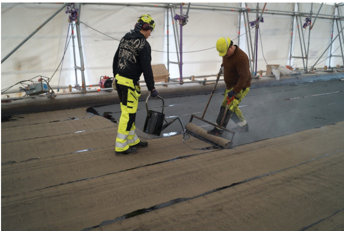
Kuva 8. Kermien kiinnitys liimaamalla
