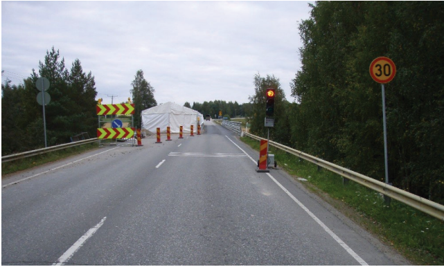
Kuva 3. Sääsuoja ja liikennevalo-ohjaus siltatyömaalla
