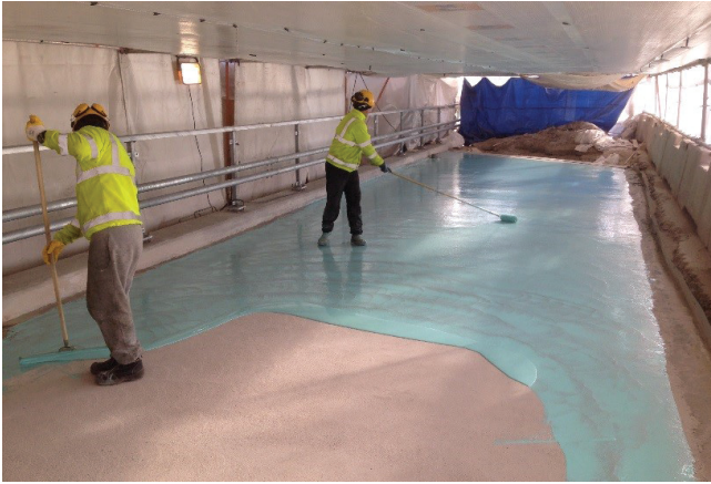
Kuva 7. Tiivistysaine levitetään lastalla ja tiivistetään telalla levityksen jälkeen
