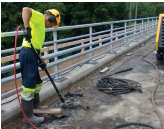
Kuva 5. Vanha vedeneristys poistetaan esimerkiksi konepetkeleellä
