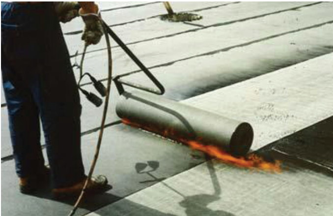
Kuva 9. Kermin kiinnitys kuumentamalla ja vetolaitetta käyttäen
