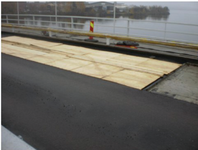
Kuva 13. Kermieristys suojataan tarvittaessa työn aikana vanerilevyillä
