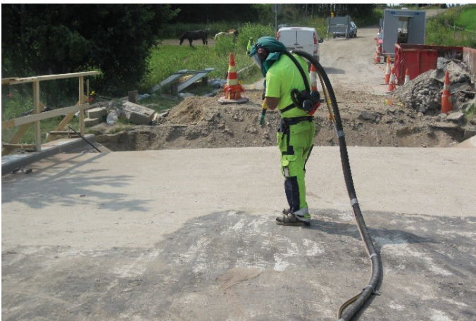
Kuva 6. Bitumijäämien poisto betonikannesta hiekkapuhaltamalla
