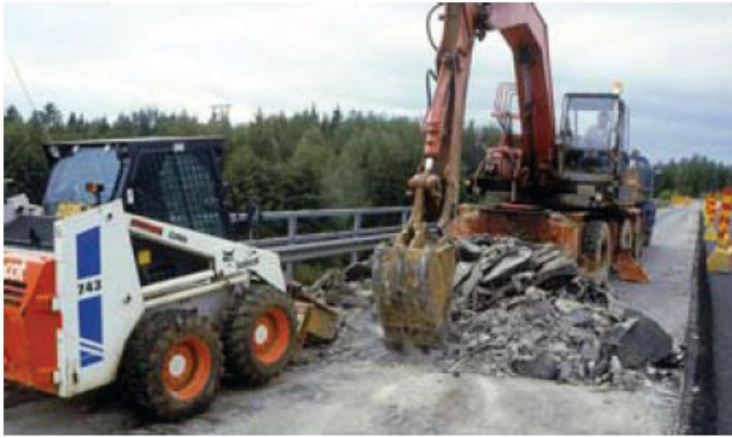
Kuva 4. Vanha pintarakenne poistetaan esim. kaivinkoneen tasateräisellä kauhalla
