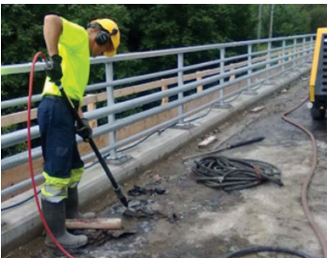
Kuva 5. Vanha vedeneristys poistetaan esimerkiksi konepetkeleellä
