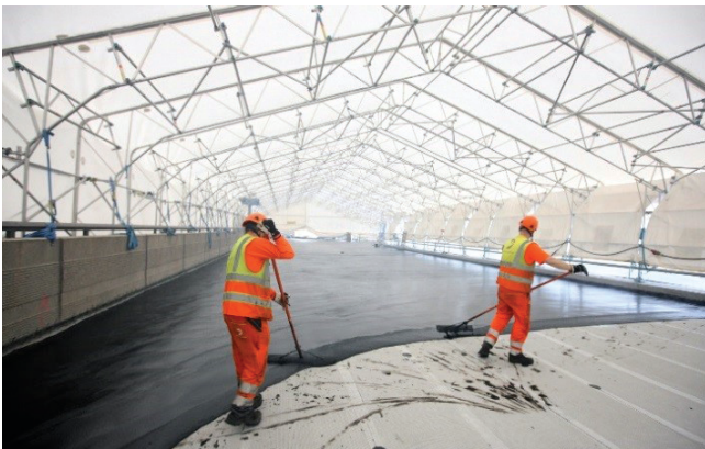
Kuva 9. Eristysmastiksin levitystä sääsuojassa
