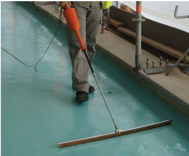
Kuva 18. Epoksitiivistyksen vesitiiviysmittaus kipinäharavalla
