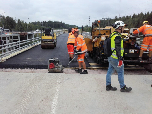
Kuva 15. Suoja-asfaltin levitys
