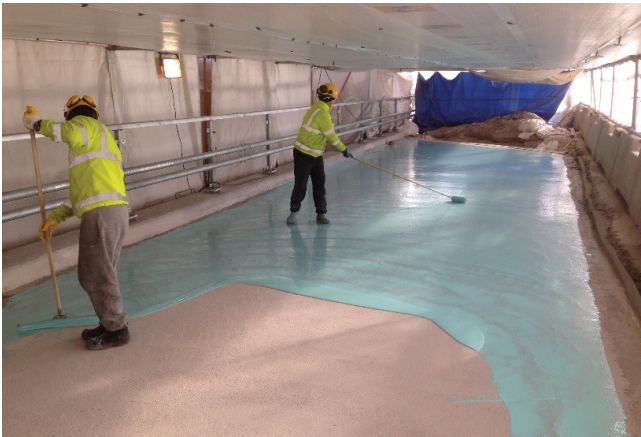
Kuva 7. Tiivistysepoksi levitetään lastalla tasaisesti ja tiivistetään telaamalla
