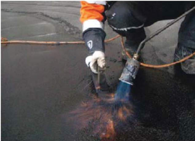
Kuva 13. Työsauman lämmitys ja tiivistys kumibitumilla KB 100
