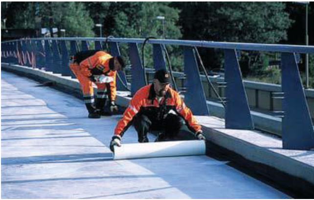
Kuva 8. Paineentasausverkon asennusta
