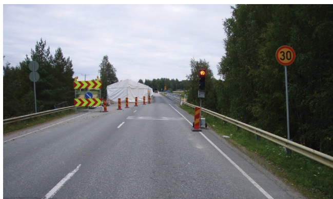
Kuva 3. Sääsuoja ja liikennevalo-ohjaus siltatyömaalla
