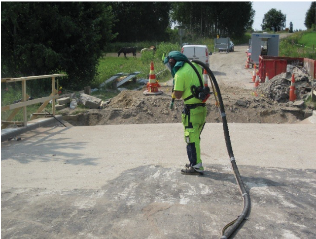
Kuva 6. Bitumijäämien poisto betonikannesta hiekkapuhaltamalla
