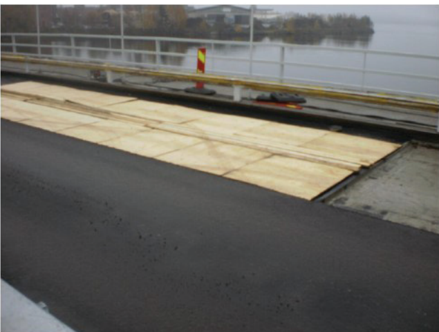
Kuva 14. Mastiksieristys suojataan tarvittaessa työn aikana vanerilevyillä
