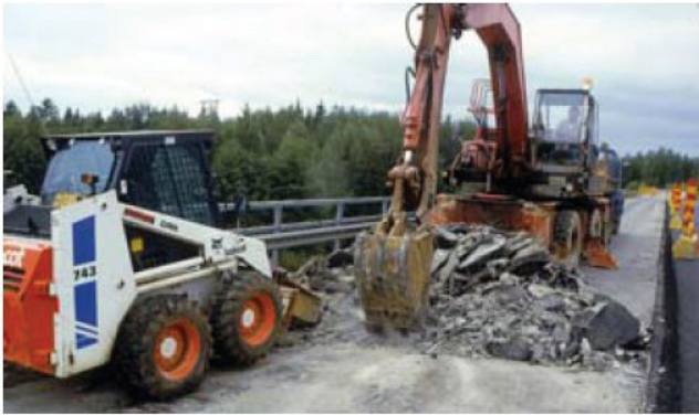
Kuva 4. Vanha päällystekerros poistetaan esim. kaivinkoneen tasateräisellä kauhalla
