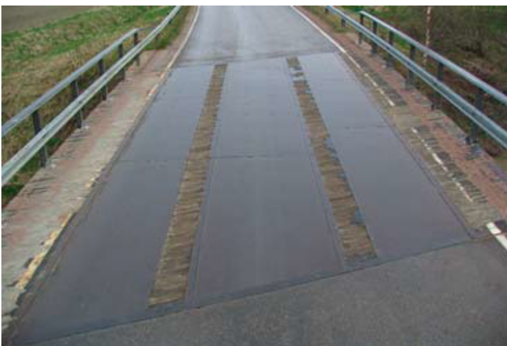
Kuva 3. Teräslevyt puukannelle asennettuina
