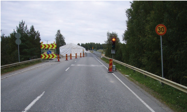
Kuva 4. Sääsuoja ja liikennevalo-ohjaus siltatyömaalla
