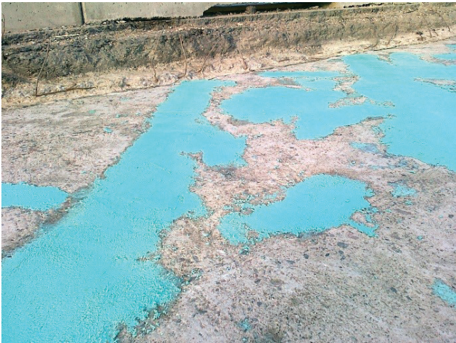
Kuva 7. Epoksin ja hiekan seoksella paikattu betonikansi
