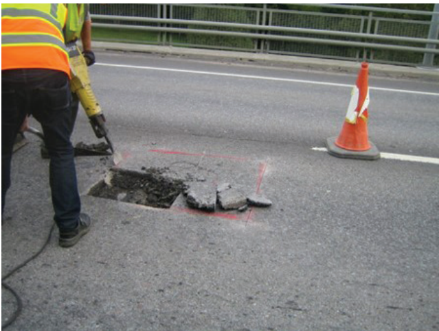
Kuva 6. Asfalttikerrosten poisto paikattavasta eristysvauriokohdasta
