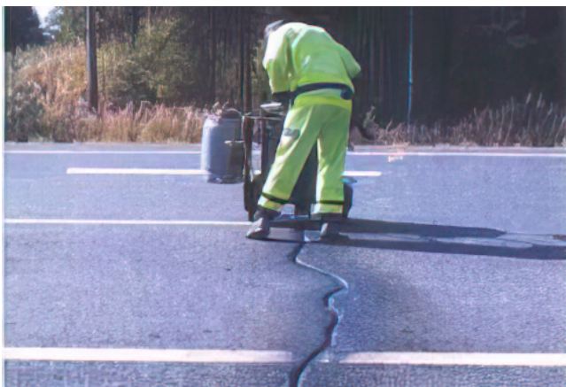
Kuva 8. Halkeaman sulkeminen saumauslaitteella
