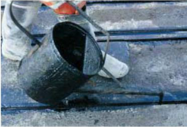
Kuva 9. Halkeaman sulkeminen kannukaatomenetelmällä
