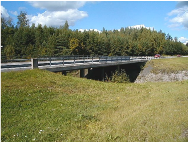
Kuva 3. Luiskat on muotoiltava loiviksi
