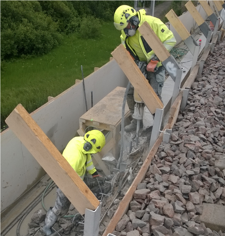
Kuva 8. Reunapalkin purkamista piikkausvasaralla
