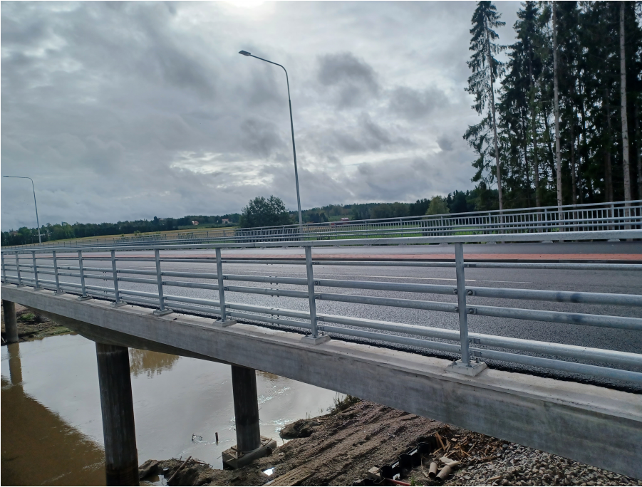
Kuva 12. Muottikangasta vasten valettu pinta
