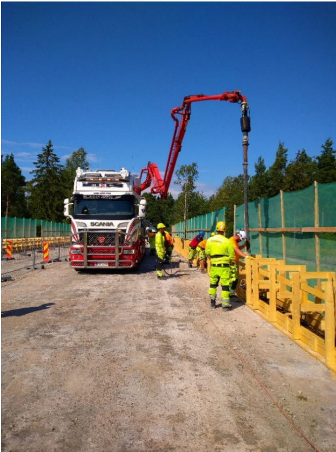
Kuva 16. Reunapalkin betonointia pumppautolla
