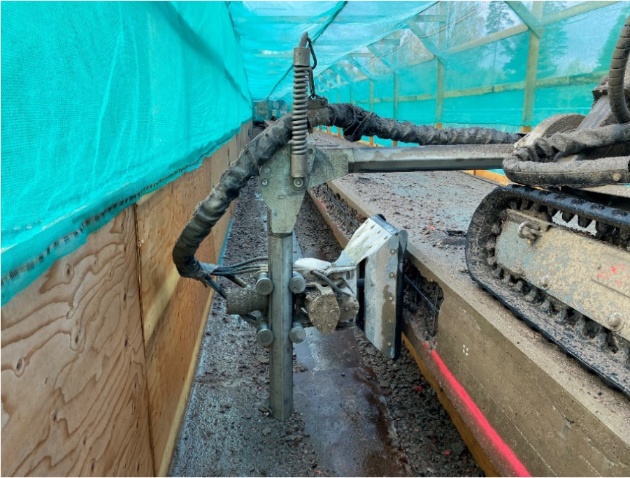
Kuva 6. Reunapalkkia puretaan vesipiikkauksella
