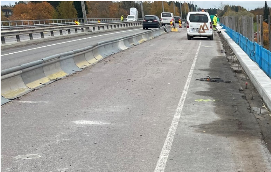
Kuva 5. Työmaa-alue on erotettu liikenteestä kaiteella
