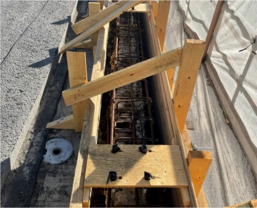
Kuva 10. Paikalla tehty puumuotti
