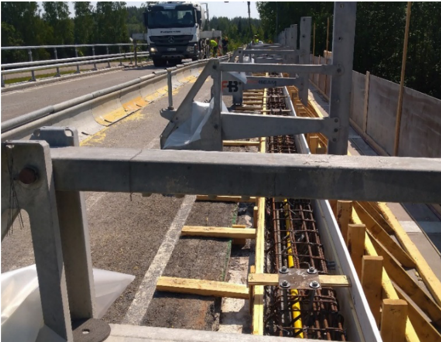
Kuva 9. Telineinä on käytetty siirrettäviä valmistelineitä
