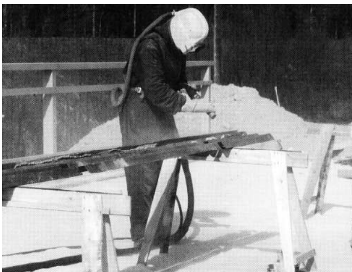
Kuva 4. Pesty pinta suihkupuhdistetaan
