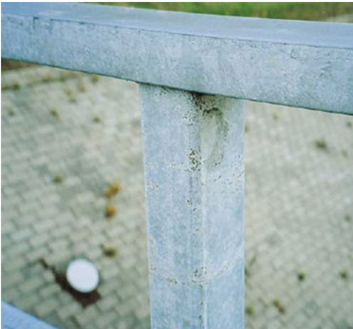
Kuva 1. Sinkkikerrosta ei saa päästää ohenemaan liiaksi
