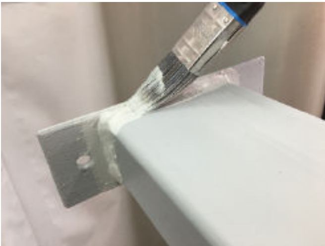
Kuva 6. Hitsausliitoksen ja särmän vahvennusmaalaukset
