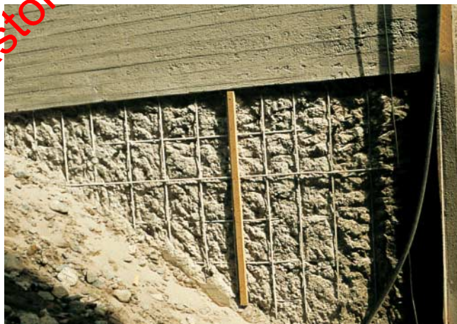
Kuva 4. Rajattu ja piikkattu maatuon alaosa.
