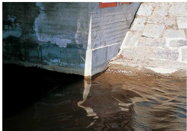
Kuva 3. Kuivatyönä tehty maatuen manttelointi.
