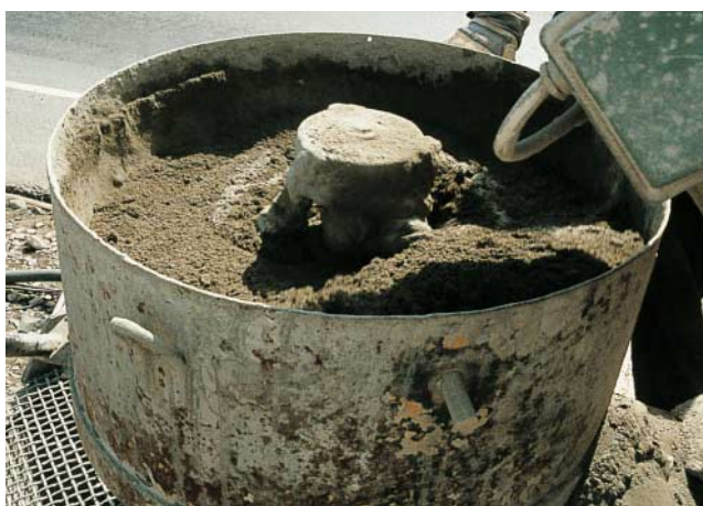
Kuva 8. Betoni sekoitetaan pakkosekoittajassa.
