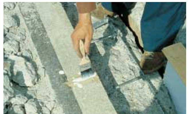
Kuva 12. Imeytysaine pidetään liikkeessä siveltimen avulla.
