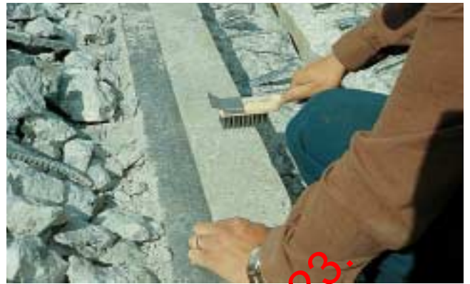
Kuva 10. Halkeaman pinta puhdistetaan.
