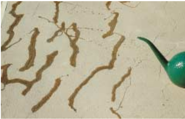
Kuva 4. Imeytysaine on kaadettu halkeaman päälle (vaihe 1).
