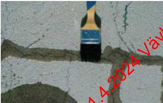
Kuva 5. Imeytysaine pidetään liikkeessä siveltimellä (vaihe 2).
