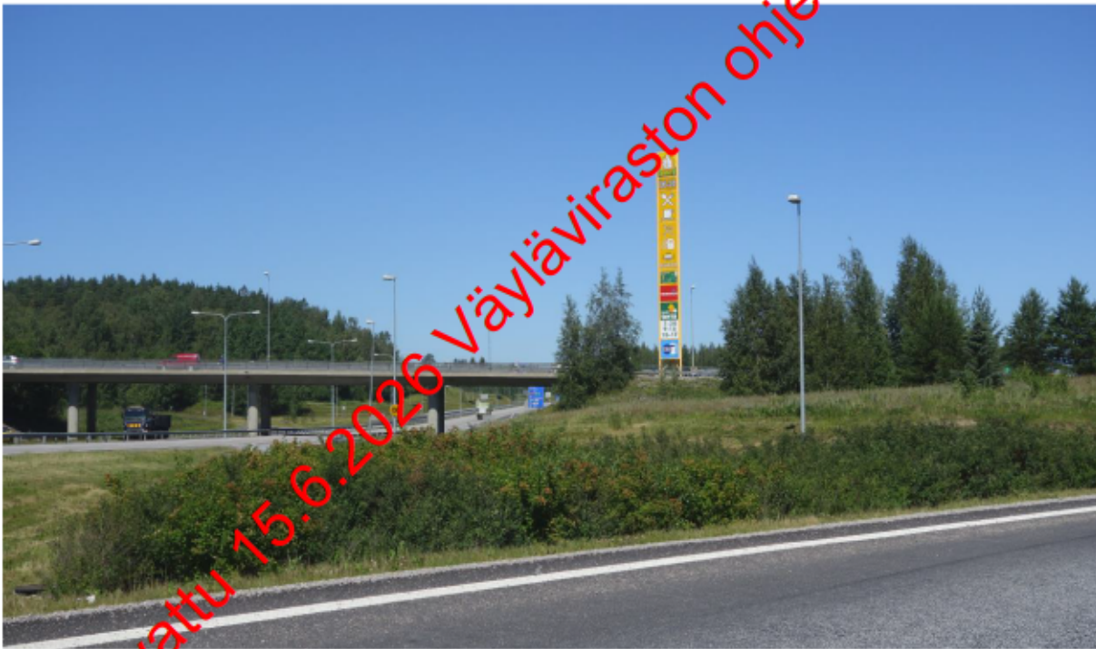
Kuva 4. Esimerkkikuva valtatie eritasoliittymäalueesta rampilta katsottuna.
