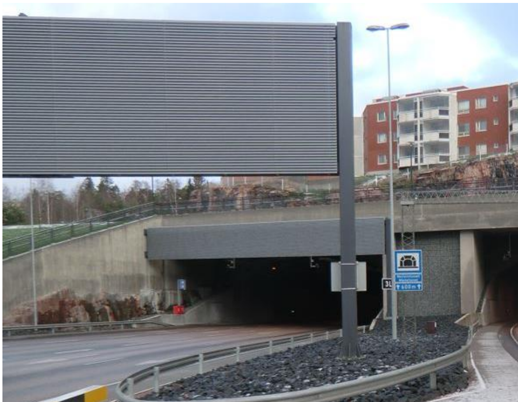
Kuva 32. Mestarintunnelin eteläisen poistumisalueen häikäisyesteet.
