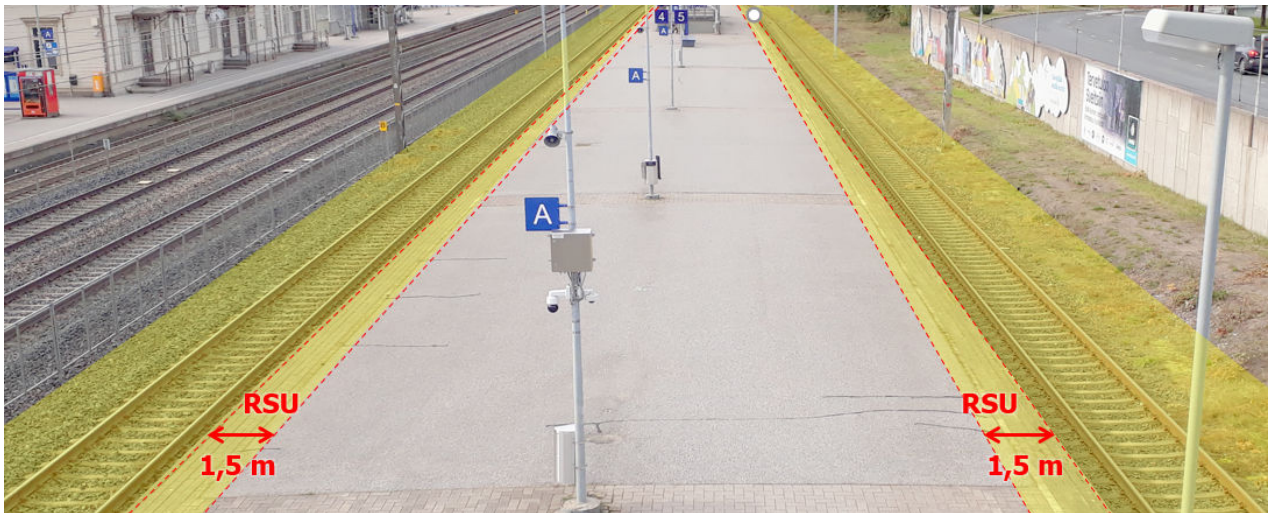
Kuva 21. Työkoneella työskentely laiturialueella RSU:n sisäpuolella edellyttää ratatyölupaa
