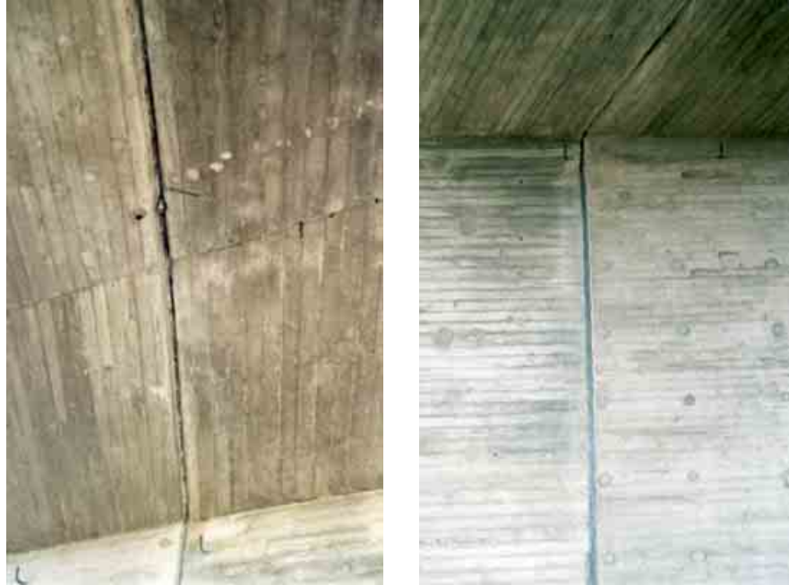
Kuva 7.14 Kansilaatan ja kehäjalan saumat.
