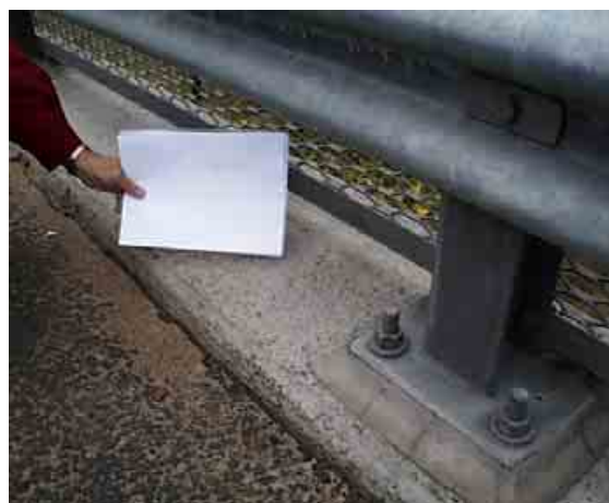
Kuva 2.2 Mäntymäen pohjoispuolen alikulkukäytävän reunapalkki.
