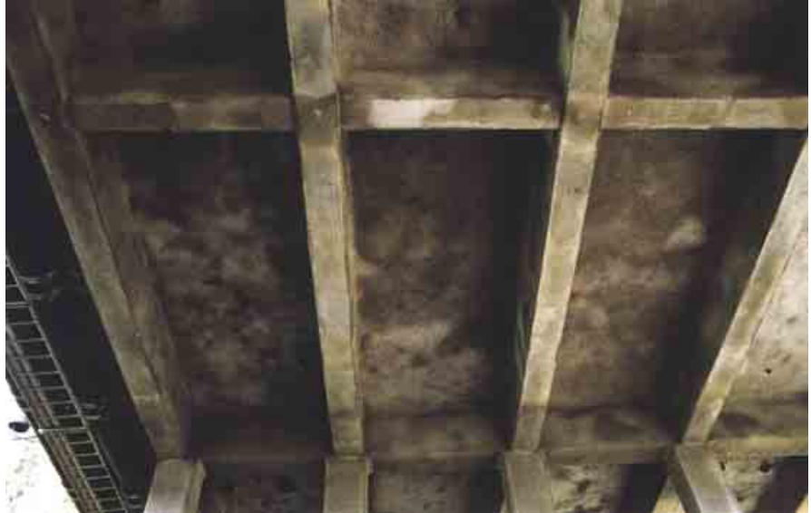
Kuva 5.3a Äänekosken sillan palkistoa.
