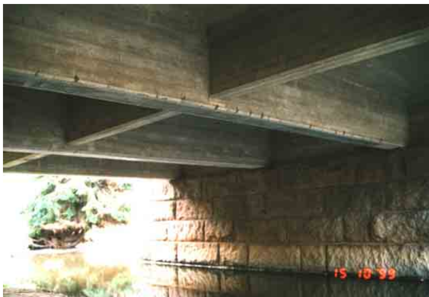
Kuva 5.1 Bembölen sillan palkisto.
