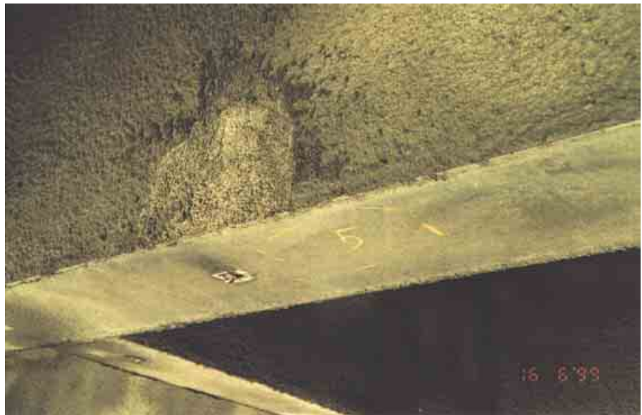
Kuva 5.3b Teräslevy irti alustasta.
