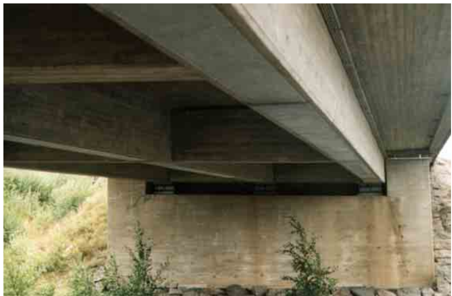
Kuva 5.8 Jylhänrannan sillan palkistoa.
