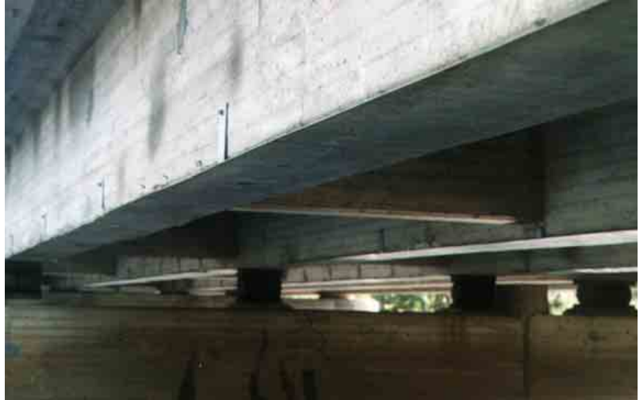
Kuva 5.4a Kuivajoen sillan palkistoa.
