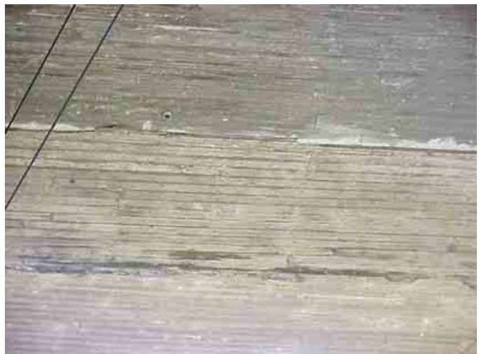
Kuva 7.33 Levennysosan saumat.
