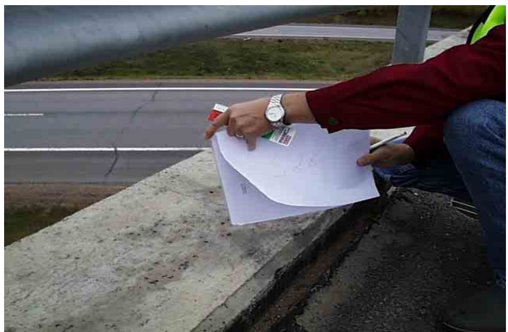
Kuva 2.4 Pasin risteyssillan reunapalkki.
