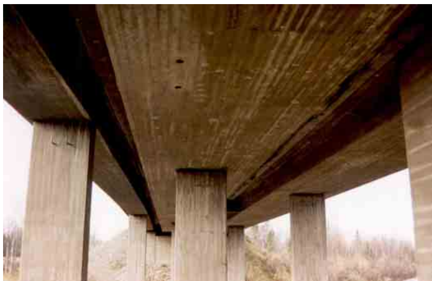
Kuva 7.16 Levennysosa (vasemmalla).
