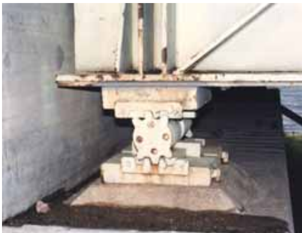
Kuva: Haukiperän sillan liikkuva laakeri.
