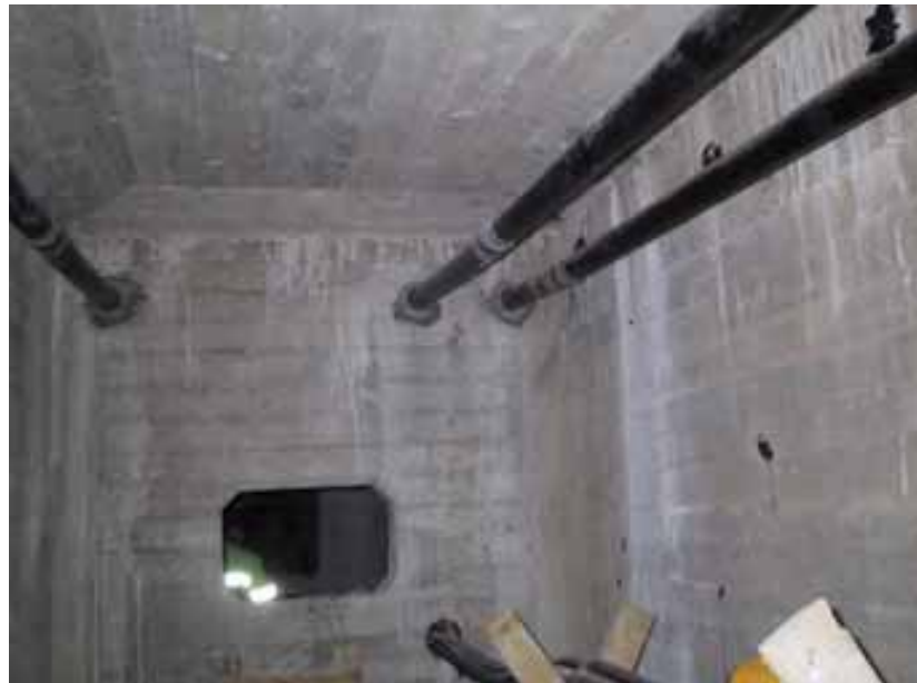
Kuva: Jänteiden läpivienti kotelon poikkipalkeista (suunnitelman ennakkokopion 28.2.1998 mukaan) ja valokuva valmiista rakenteesta.
