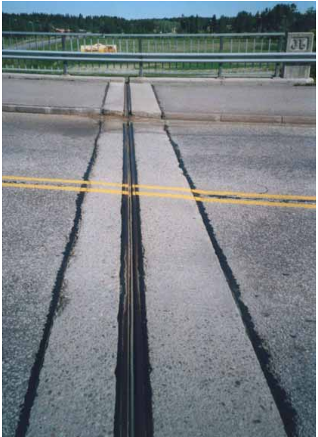
Kuva 3.7 Epoksibetoninen tukikaista.
