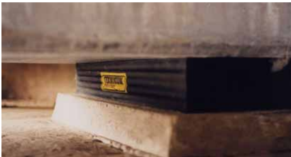
Kuva 2.2 Esimerkki kumin pursuamisesta.
