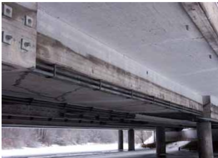
Kuva: Pituussuuntaisten jänteiden vaaka- ja pystygeometria välituilla ja jänteiden kulku kotelon ulkopuolella keskiaukossa.
