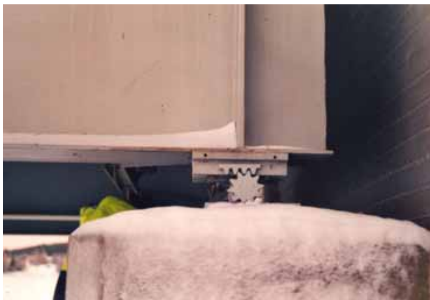
Kuva: Pellon sillan laakeri. Ulkoilman lämpötila -25^{\circ}\text{C} .
