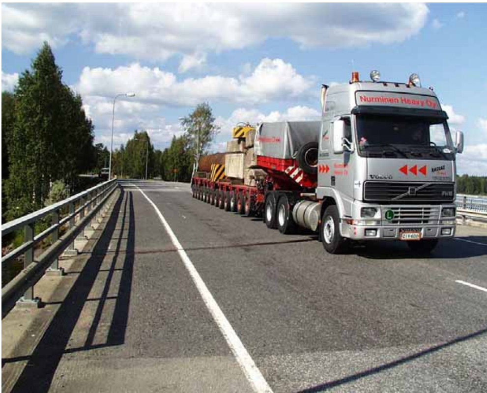
Kuva 6.1 Tavanomainen sillan koekuormitusjärjestely (Isonkivensalmen silta, Keuruu).
