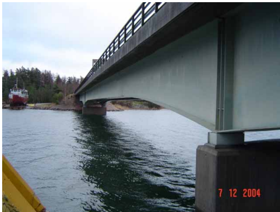
Kuva a) Yleiskuva.
