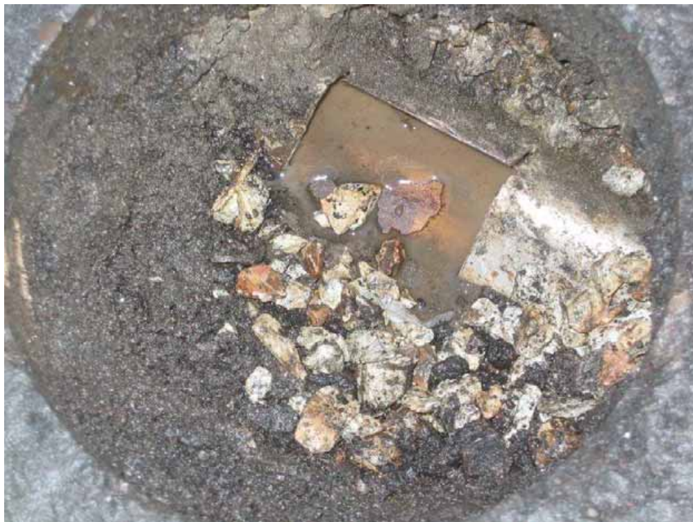
Kuva 3.10 Reunasalaojan avauskohta. Teräsprofili leikattiin auki.
