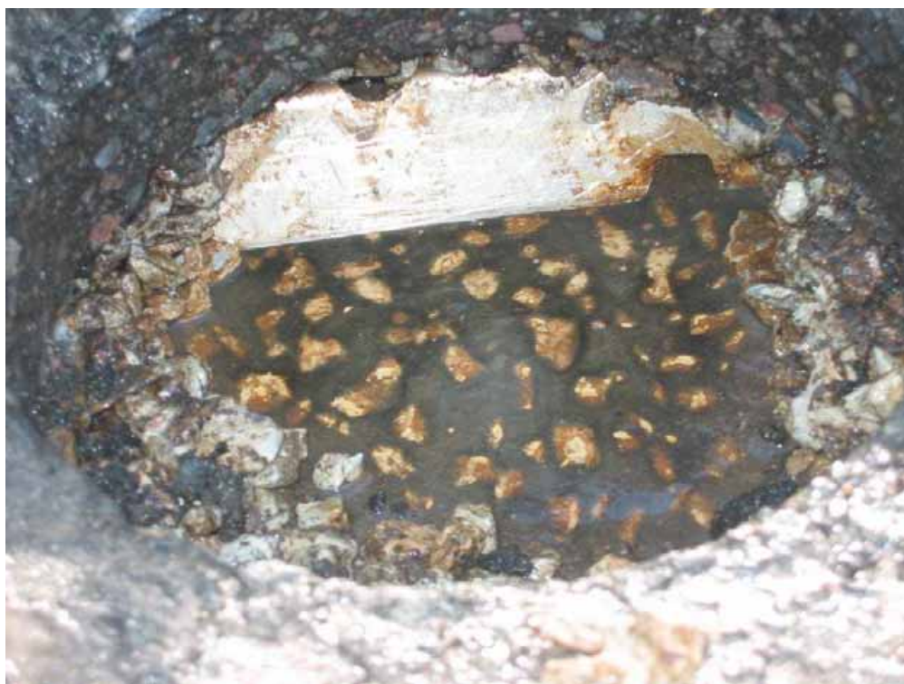
Kuva 3.11 Reunasalaojan avauskohta. Endoskooppitähystys tehtiin putken reunakolosta.
