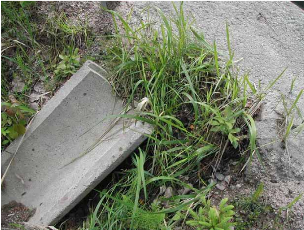
Kuva 3.9 Pintavesikourun yläpäässä on alkava eroosioaurio pintavesien ohjauslaitteiden puuttumisen takia.
