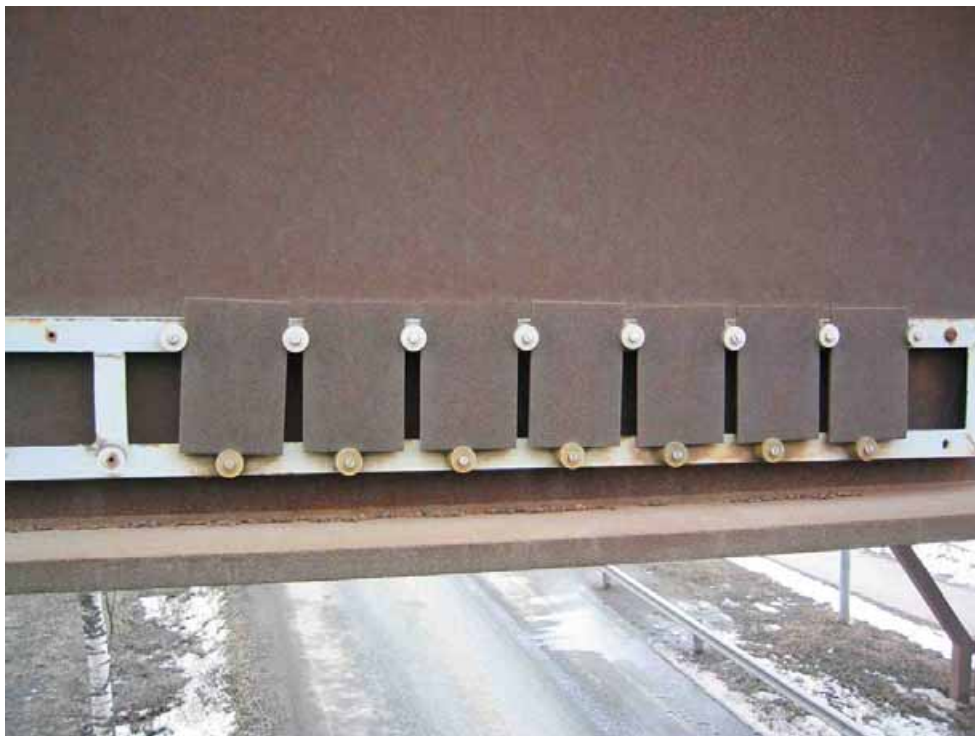
Kuva 2.1 Säänkestävä teräs ei-suositeltavassa ympäristössä Itäkeskuksen siltapalkissa, kuva VTT:n tutkimusraportti NRO BTU075-041245-10.5.2004.
