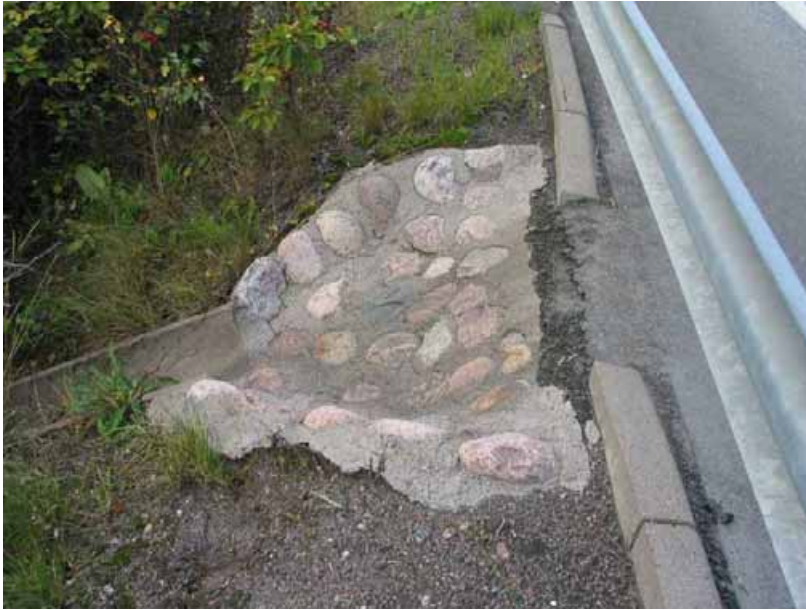
Kuva 3.4 Pintavedet ohjataan kouruun reunusten ja suppilon avulla.
