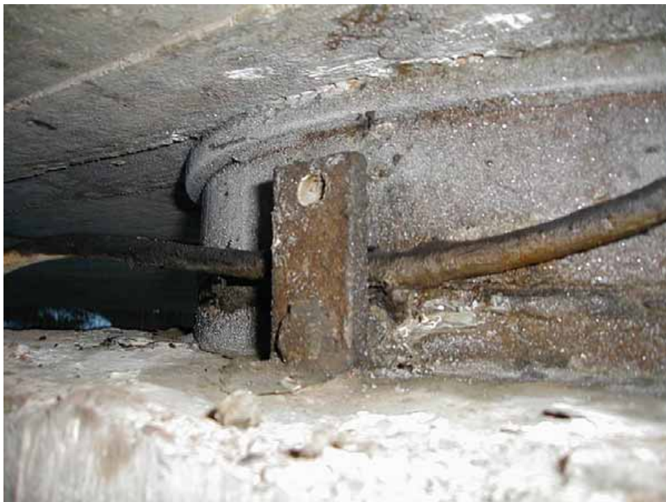
Kuva b) Laakeri B2. Kuvassa näkyvä johto ei kuulu laakerin rakenteisiin.
