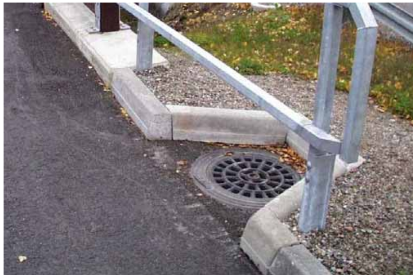
Kuva 3.2 Betonireunus ja pintavesikaivo.
