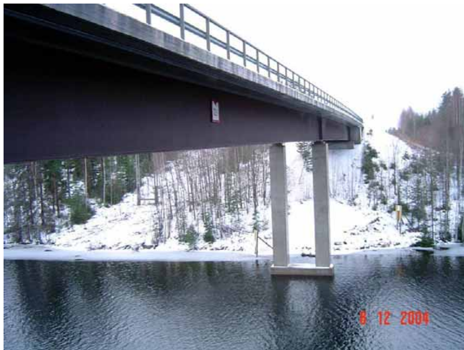
Kuva a) Yleiskuva.
