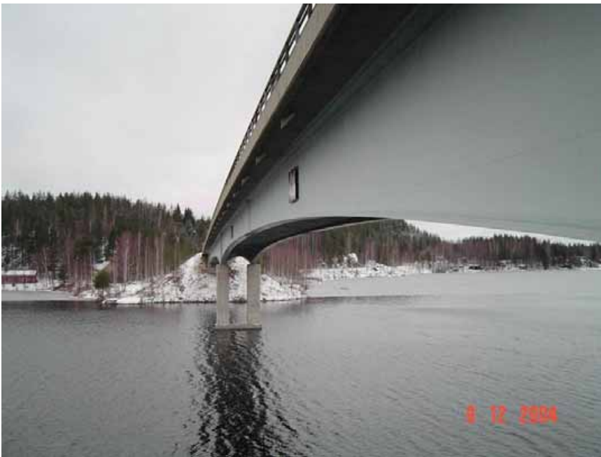
Kuva a) Yleiskuva.
