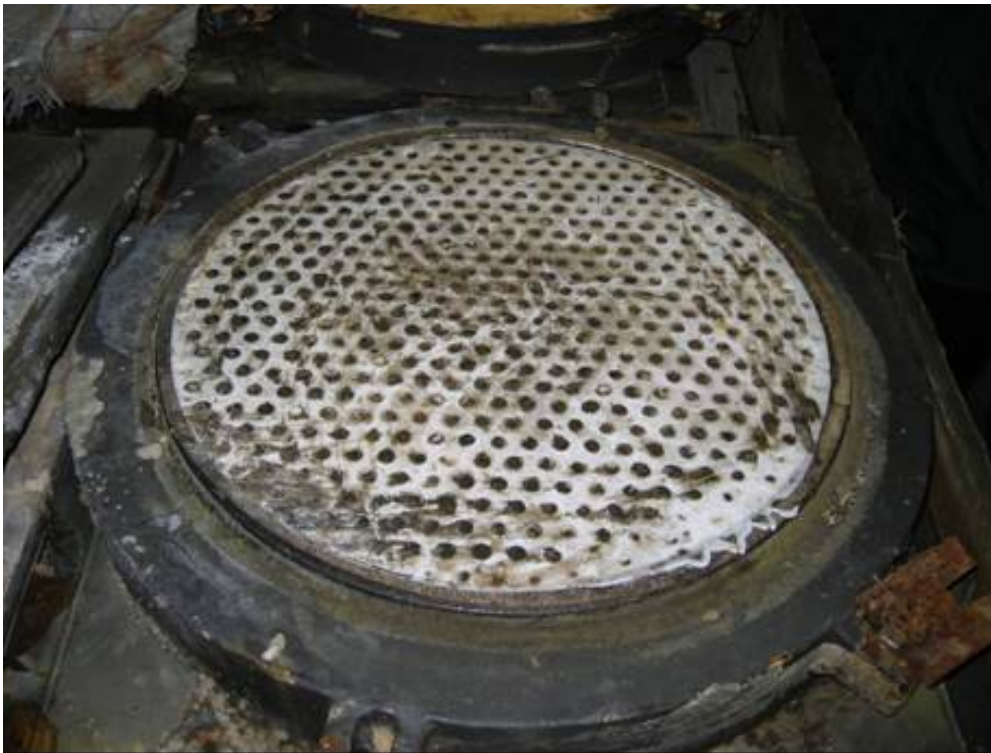
Kuva 4.3 Vaurioitunut teflonlevy Ruissalon sillassa.
